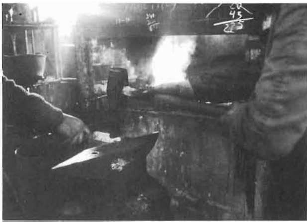
LÁMINA 29 a.—Afilado del hierro.
