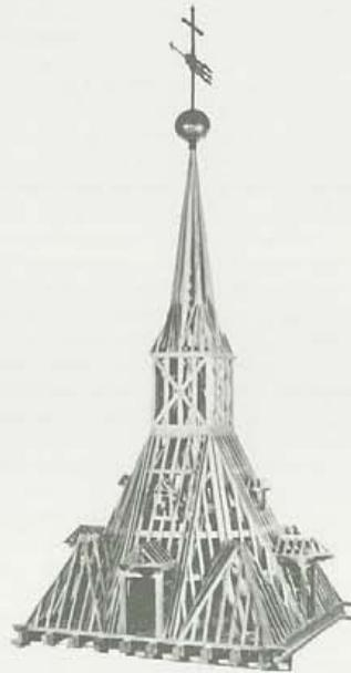
**67. MAQUETA DE LA CARPINTERIA DE ARMAR CORRESPONDIENTE A LAS CUBIERTAS DEL CONVENTO**
