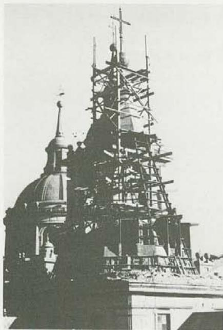
LA NUEVA ESTRUCTURA METÁLICA DE LA LUCERNA EN SEPTIEMBRE DE 1963. LAS TRAZAS SON LAS DE HERRERA, DEDUCIDAS DE SUS DIBUJOS Y DE LOS GRABADOS DE PERRET. ES INDUDABLE QUE HOY NO NOS HUBIERAMOS PERMITIDO EMPLEAR HIERRO EN SUSTITUCIÓN DE LA MADERA. EN AQUELLOS AÑOS SE IMPUSO IMPERATIVAMENTE POR TODOS LOS ESTADOS DE OPINIÓN.
