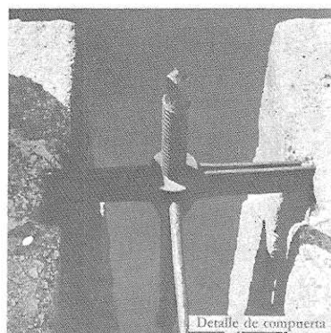
Detalle de compuerta
