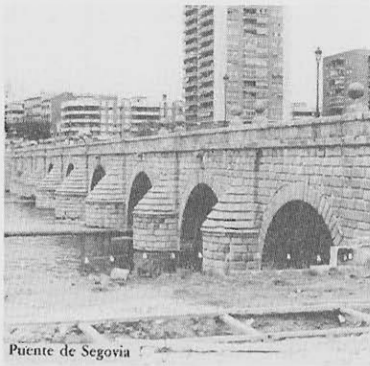
Puente de Segovia
