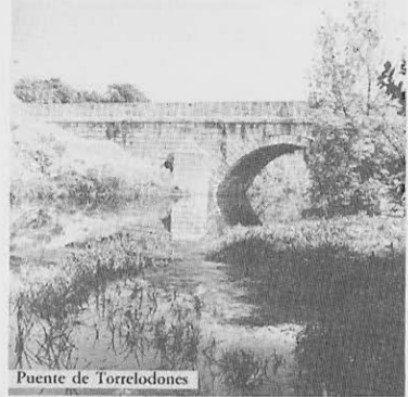
Puente de Torrelodones
