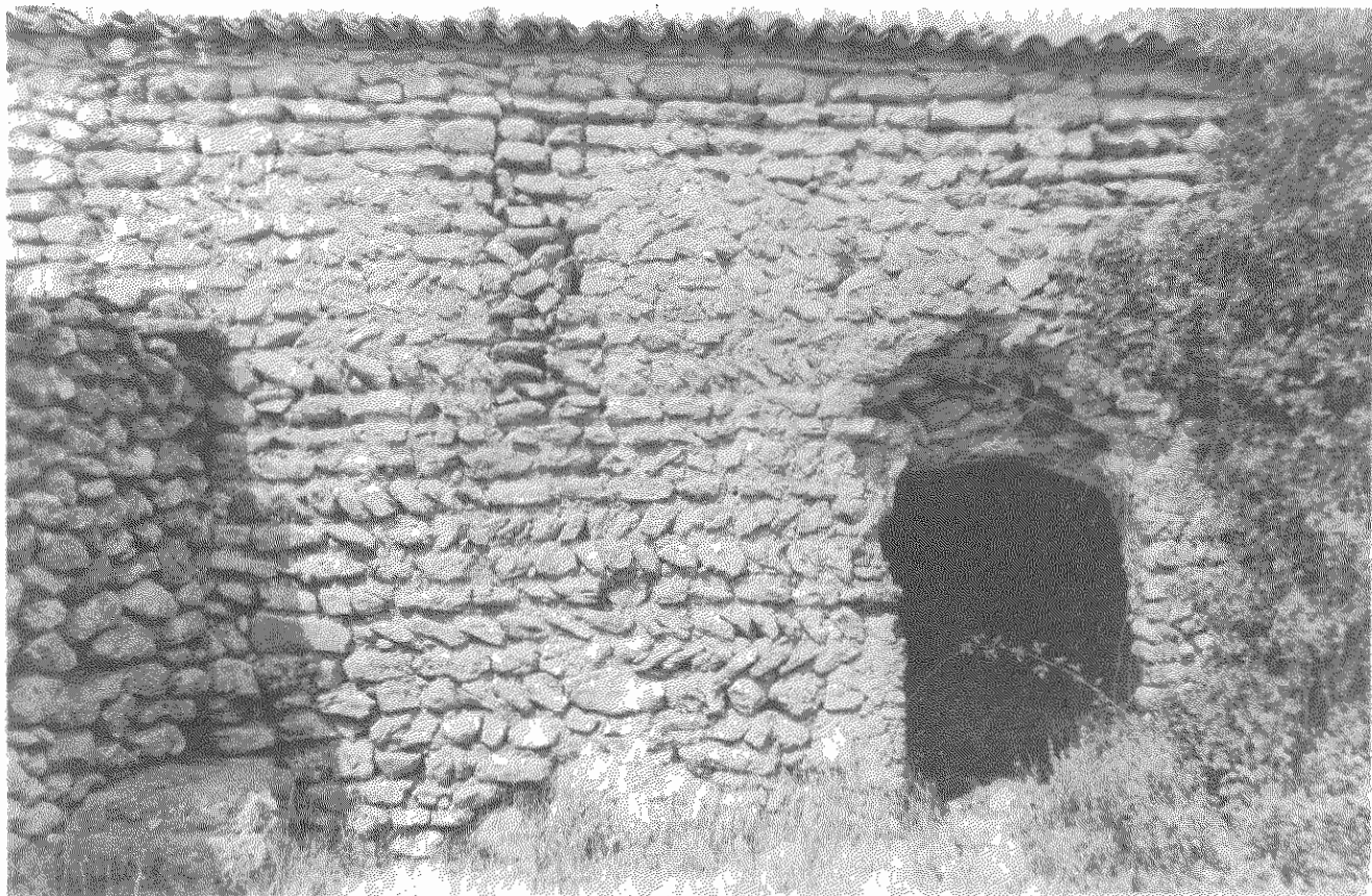
Lámina 2.—Mampostería en opus spicatum y aparejada con ayuda del encofrado en el despoblado de Cariola (Alcalá).
