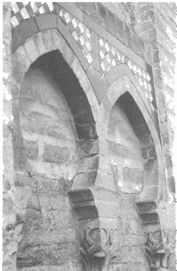
6: Detalle de uno de los arcos ciegos. En las claves de los pequeños arcos de herradura tímidos se aprecia un pequeño círculo, que en los otros arcos de este tipo alterna con un rectángulo, tal y como apareció en la Fig. 5.
