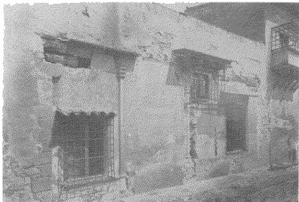
Vista exterior del pórtico cegado (17-IV-1973).
