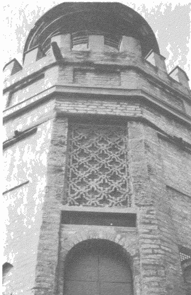
7: Detalle del segundo cuerpo de la torre del Oro: friso de alizares bajo el almenaje y bajo el paño de sebka que hay sobre la puerta de acceso.
