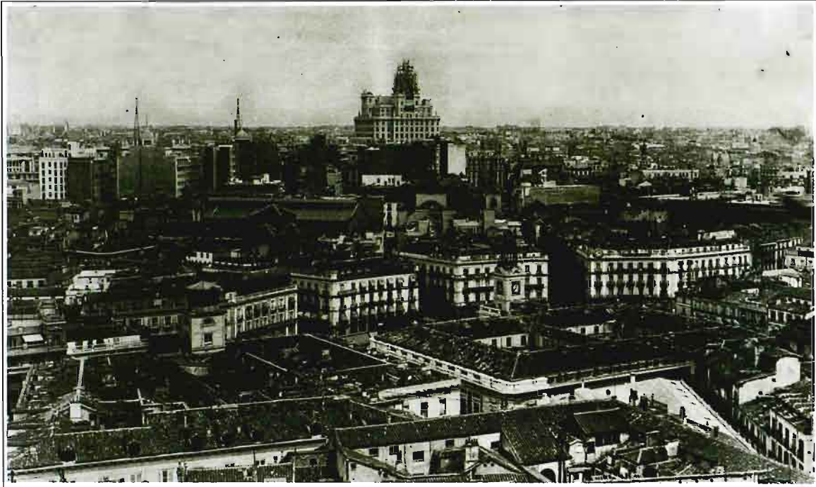
Fig. 3. Vista de Madrid. En primer plano la Puerta del Sol. En segundo plano la Telefónica en construcción. A. F. del Museo Municipal. I. N. 21.587. 1929.
