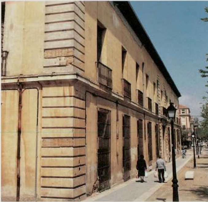
22. Impostas y falsos sillares en fachada.
