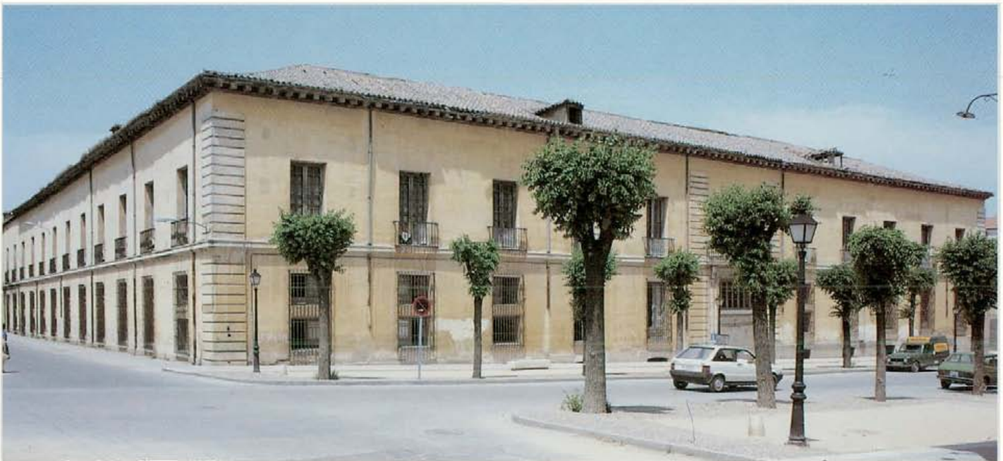
24. El edificio antes de la rehabilitación.
