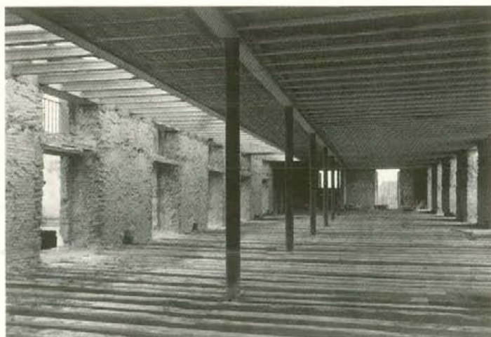
32. Planta alta. En construcción.
