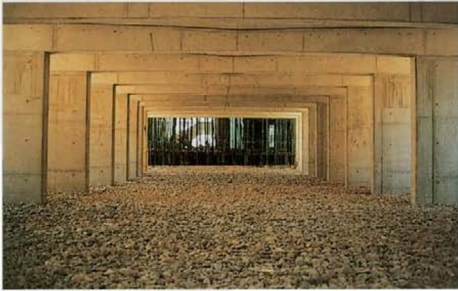
35. Pórticos y pantallas que sustentan el auditorio y configuran el vestíbulo.
