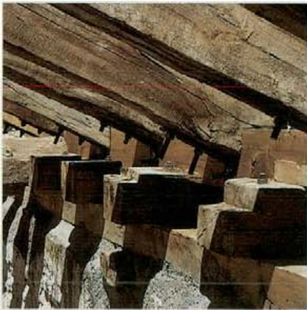
28. Detalle. Armaduras de cubierta, uniones.
