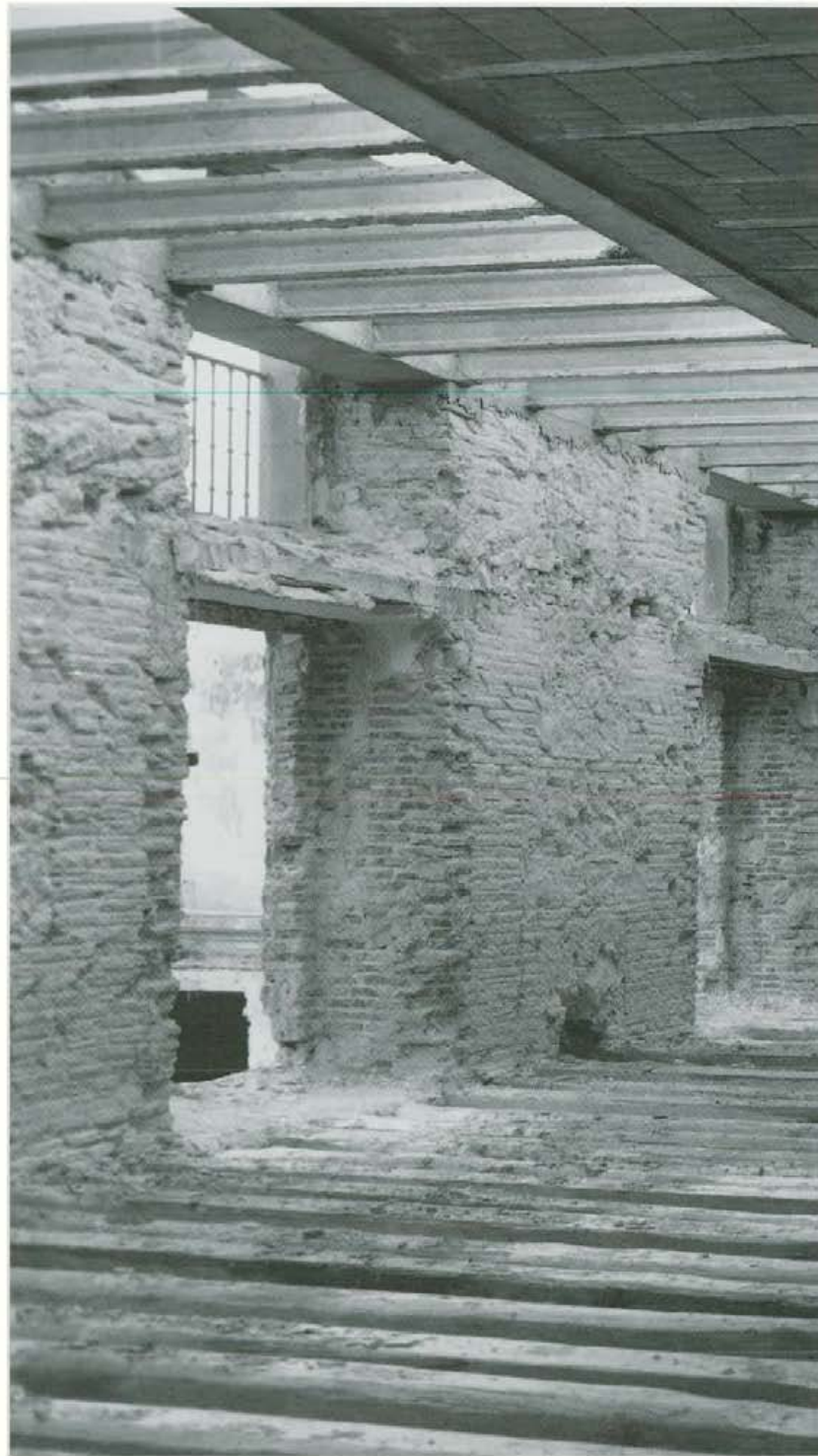
Planta Alta. Nave en construcción.
