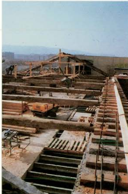
29. Refuerzo de correas bajo los puentes.
