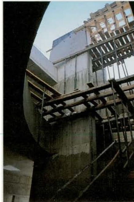
43. Proa de hormigón y estructura del núcleo extremo.
