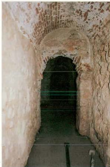
14. Cimentación abovedada. Bodega.
