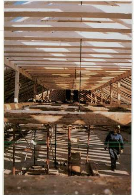
30. Tirantes madera y pendolones metálicos.
