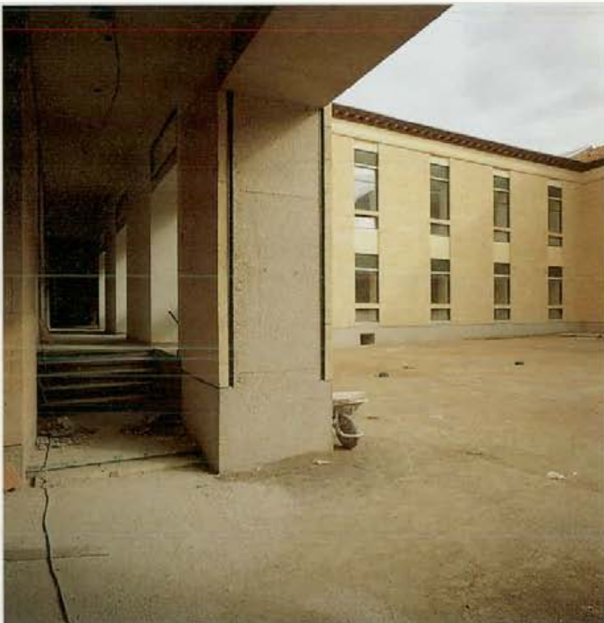
32. Fachada del patio de c/ Capitán, aplacada con piedra.
