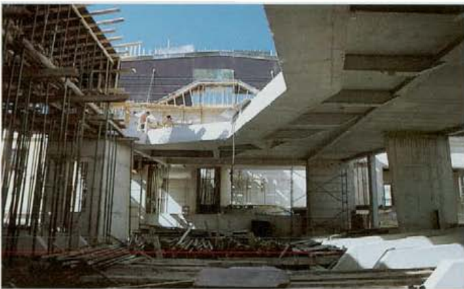
42. Proa de hormigón y estructura del núcleo extremo.
