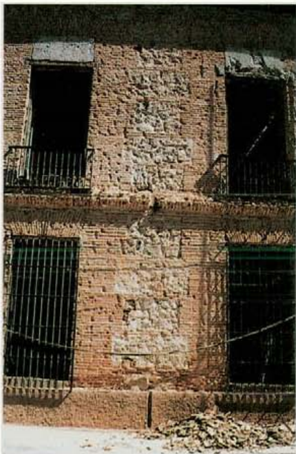
13. El muro aparejado.
