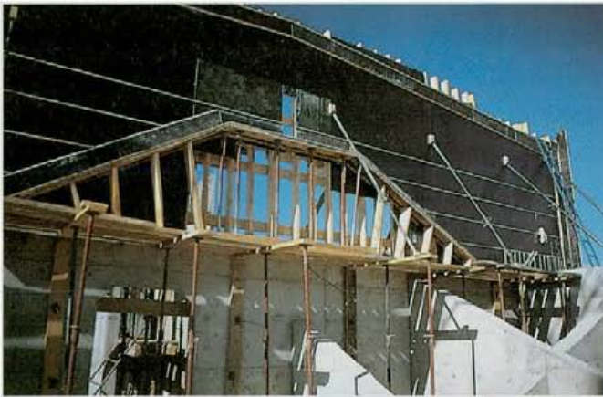
37. Ménsulas y vigas balcón.
