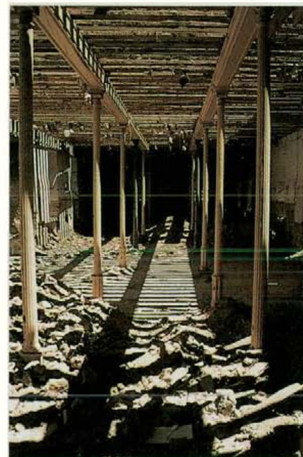
15. Forjado de viguería de madera.
