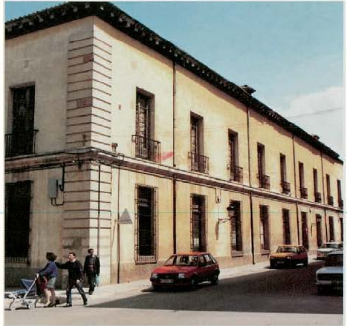
23. El edificio antes de la rehabilitación.
