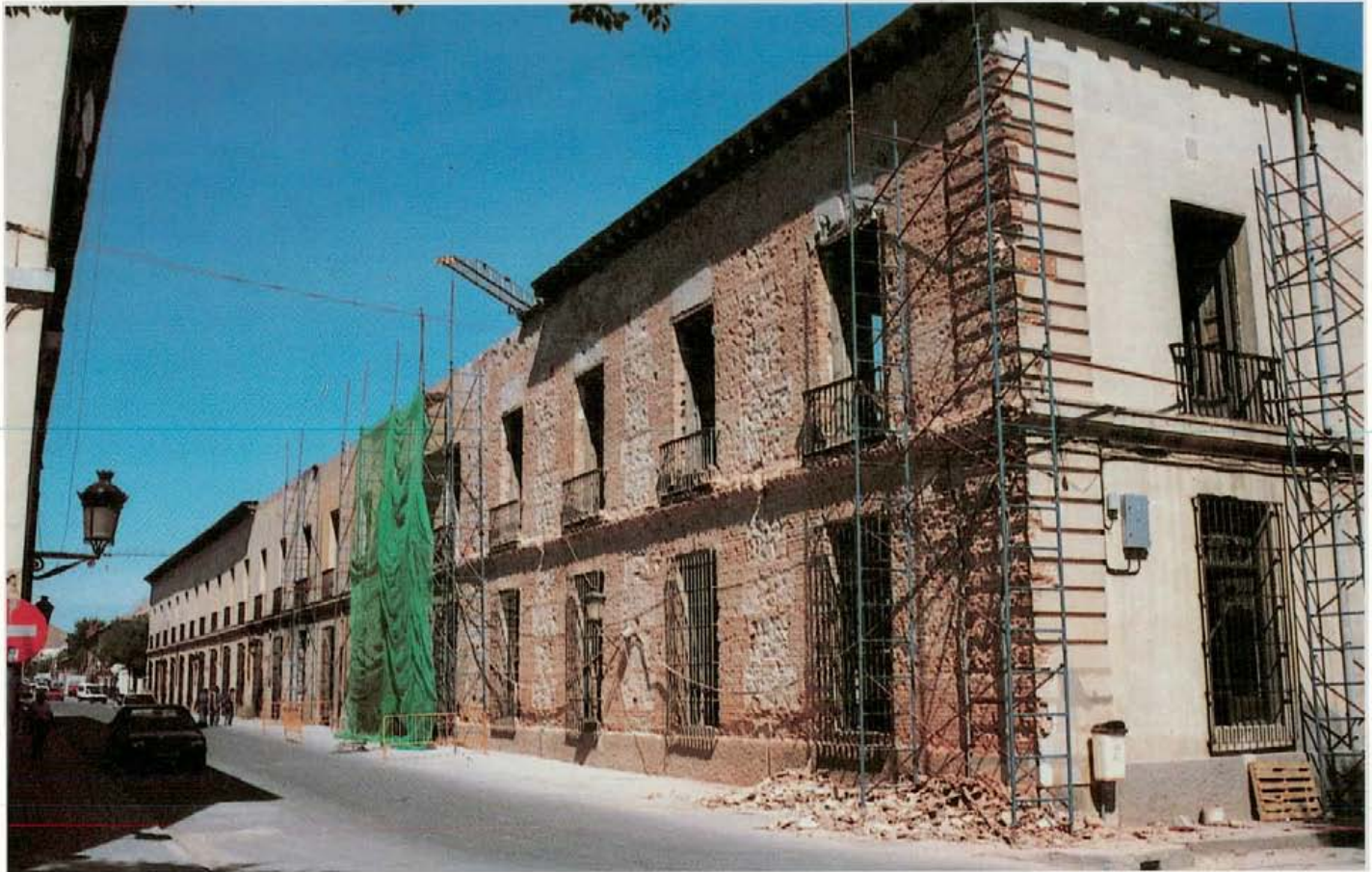
20. Revestimiento de fachada.
