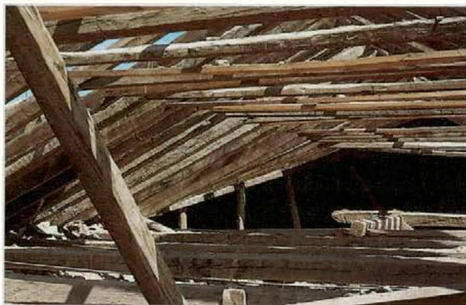
17. Armaduras de cubierta.
