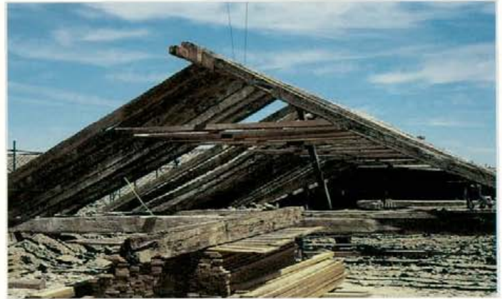
16. Armaduras de cubierta.
