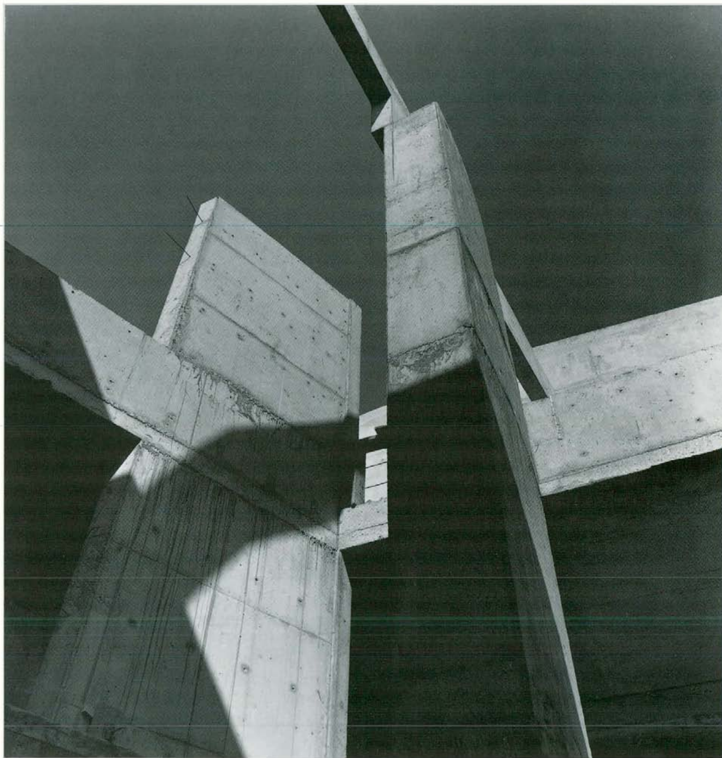
40. Pantallas de hormigón.
