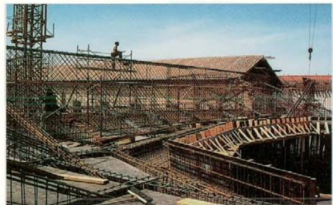
39. Armado de ménsulas y vigas balcón.
