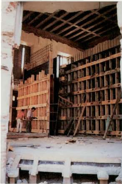
25. Losa nervada de zunchado de esquina.
