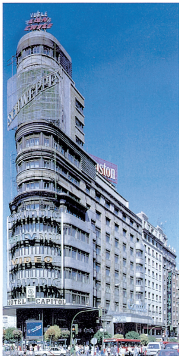
Martínez Feduchi y V. Eced: Edificio Capitol, 1931-1933
