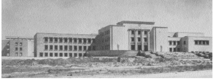
Pascual Bravo: Escuela Técnica Superior de Arquitectura después de su reconstrucción, 1940.
