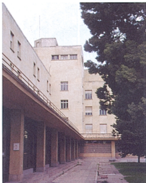
Pascual Bravo: Escuela de Arquitectura, 1932-1943.
