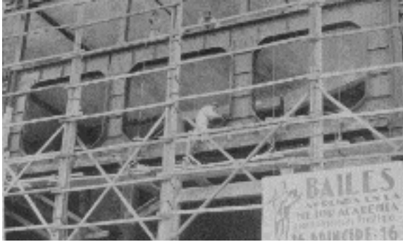
V. Eced y L. Martínez Feduchi: Edificio Carrión, montaje de la viga Vierendell de fachada, 1932.
