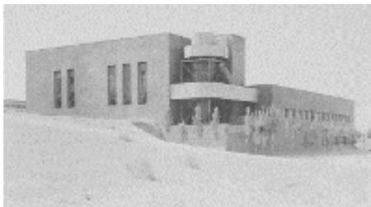
Manuel Sánchez Arcas: Central Térmica de la Ciudad Universitaria, 1932-1935.
