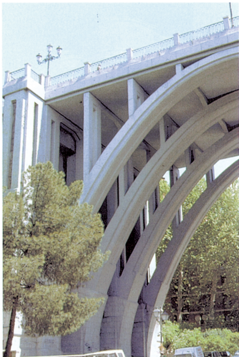
J. Ferrero, J. J. Aracil y L. A. Muguero: Viaducto, 1932-1942
