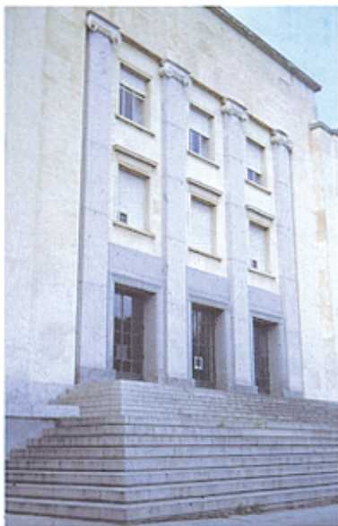
Pascual Bravo: Escuela de Arquitectura, 1932-1943.
