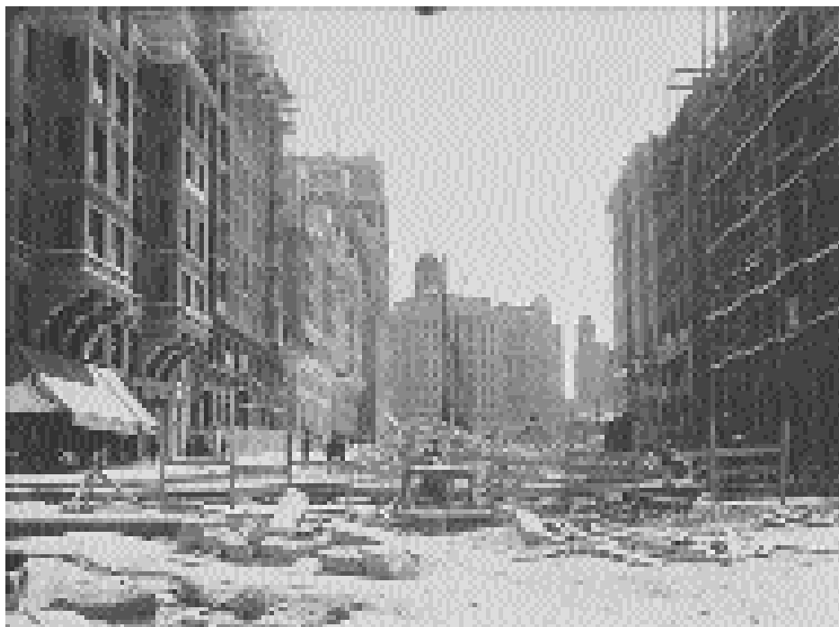
Vista del tercer tramo de la Gran Vía en construcción, 1929.
