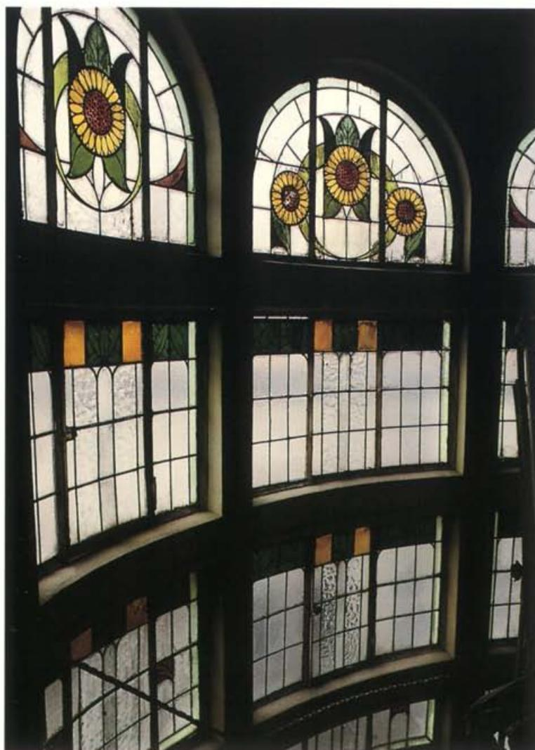
vidriera, con una varilla de refuerzo por cada uno, con armaduras y pletinas de hierro y plomos de sección tipo H.
