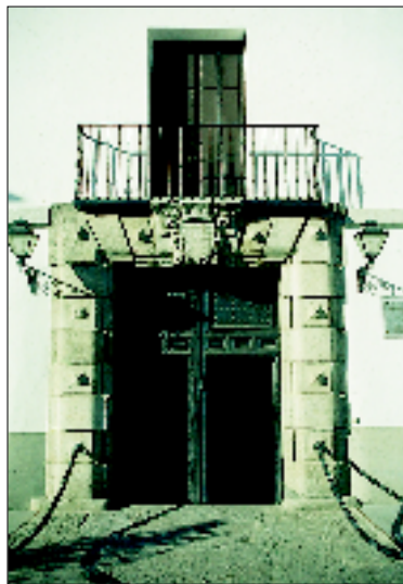
Puerta principal de la Casa Palacio de Godoy
