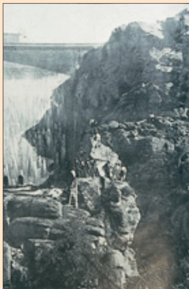
La presa del Villar en 1908
