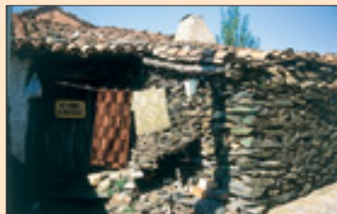
Construcción con lajas de piedra
