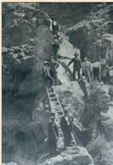
Visita a las obras de la presa del Villar en 1908
