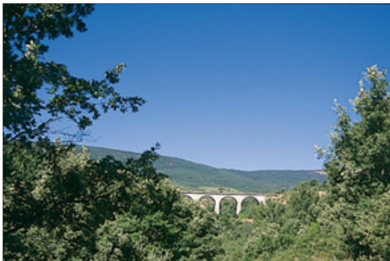
Viaducto de la Dehesilla
