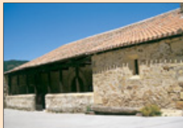
Uno de los pórticos de la Iglesia de Santo Domingo
