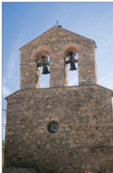
Espadaña de la Iglesia
