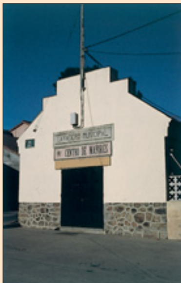
Antiguo lavadero municipal
