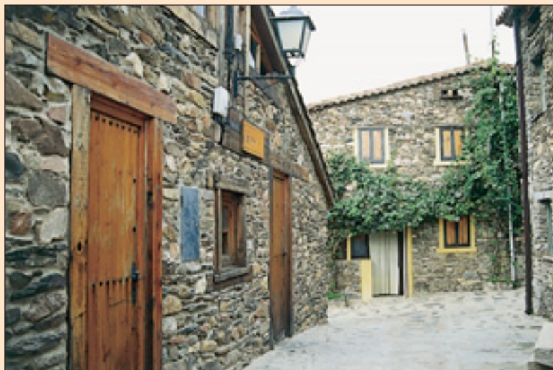
La Fragua rehabilitada
