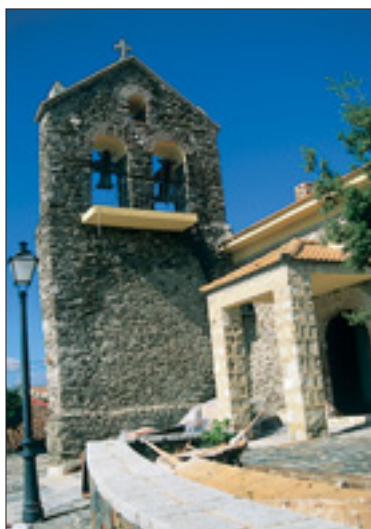
Iglesia de Santa Catalina de Alejandría y detalle de la Espadaña
