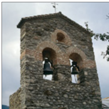
Espadaña de la Iglesia
