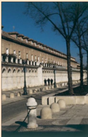
Lateral porticado del Palacio
