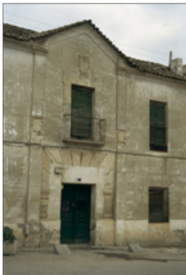
Casa de la Tercia
