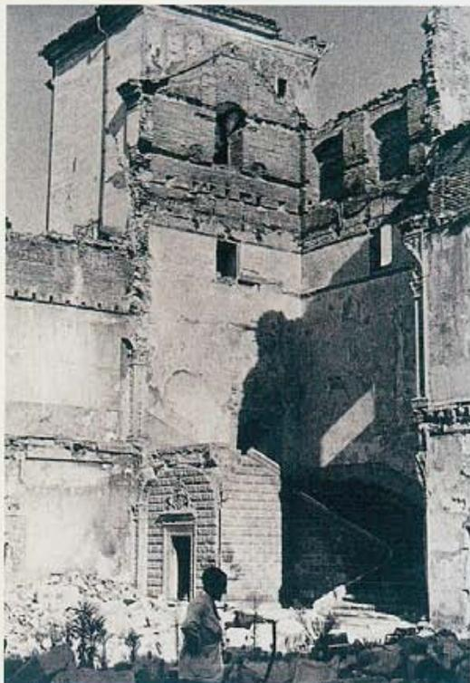
Otras obras concretas de restauración, dentro de nuestro período de tiempo elegido, fueron las de José Aspiroz para el afianzamiento de la fachada de entrada y del ángulo de uno de sus muros mediante un atado con tirantes y anclajes de hierro, ante la negativa terminante de la Administración a una reconstrucción.
