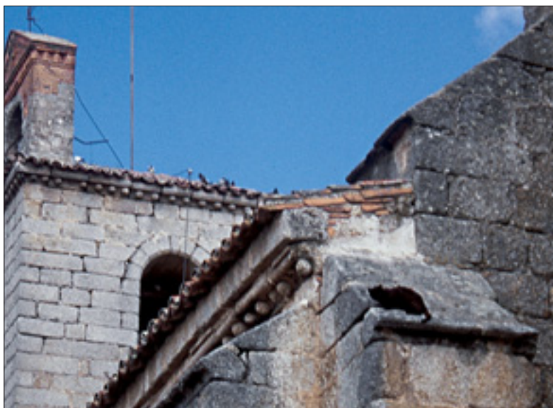
Gato sobre el contrafuerte de la Iglesia de San Esteban
