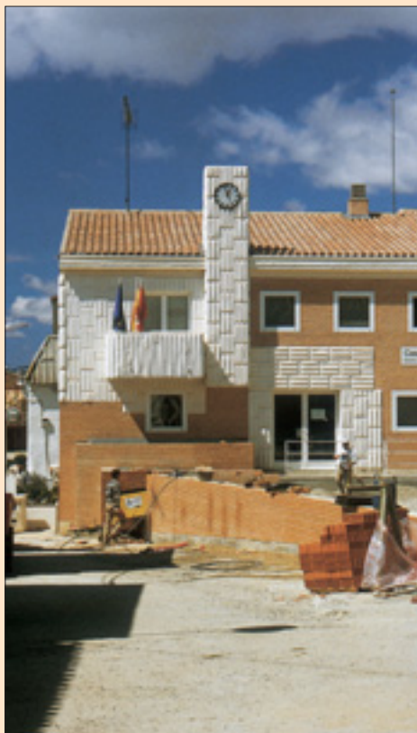
Construcción del nuevo ayuntamiento
