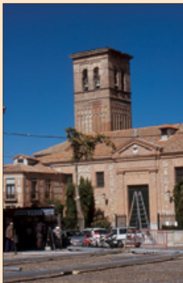
Torre de la iglesia tras el incendio de 1999
