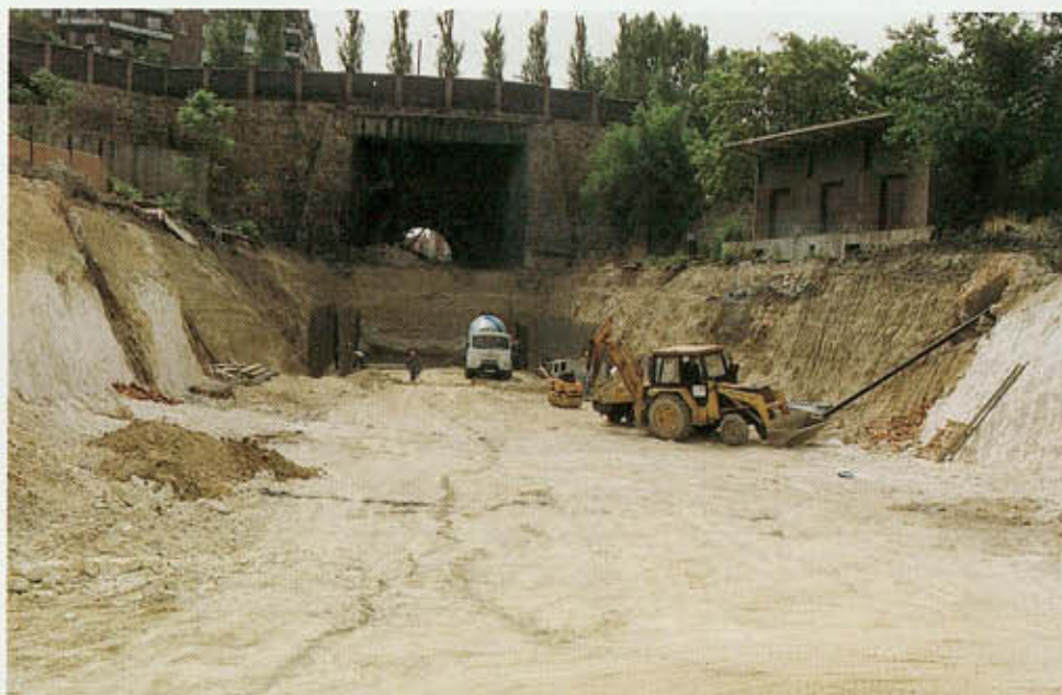
Figura 1.42 Vista de las obras realizadas en la Estación Imperial. Puede observarse debajo de la construcción de la derecha un nivel más oscuro, que corresponde al yacimiento paleontológico.
