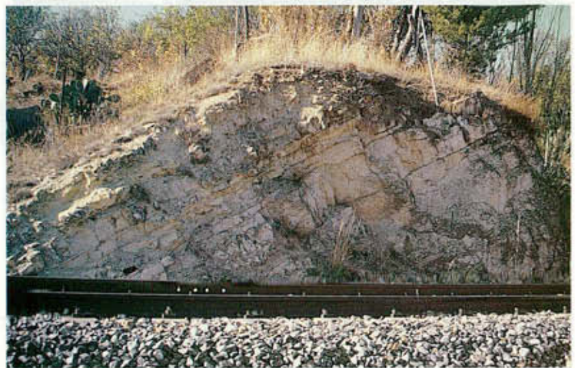
Figura 2.13. Afloramiento de Soto del Real correspondiente al talud de la vía férrea.
