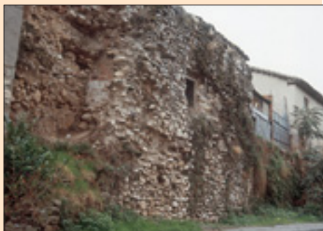
Restos de la muralla
