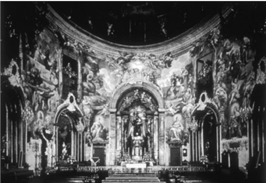
Fig. 6-Paramentos de la iglesia de San Antonio de los Alemanes
