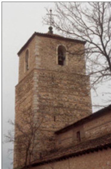
Torre de la iglesia de la Asunción
