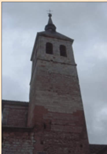
Torre de la iglesia de la Asunción
