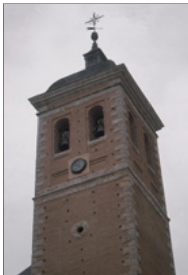
Torre de la iglesia de la Asunción
