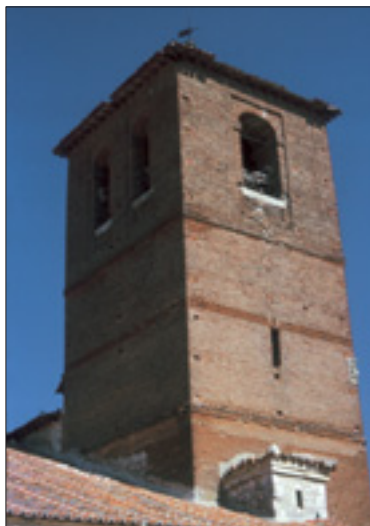
Detalle de la torre de la iglesia
