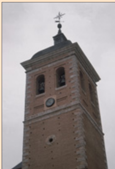
Torre de la iglesia de la Asunción
