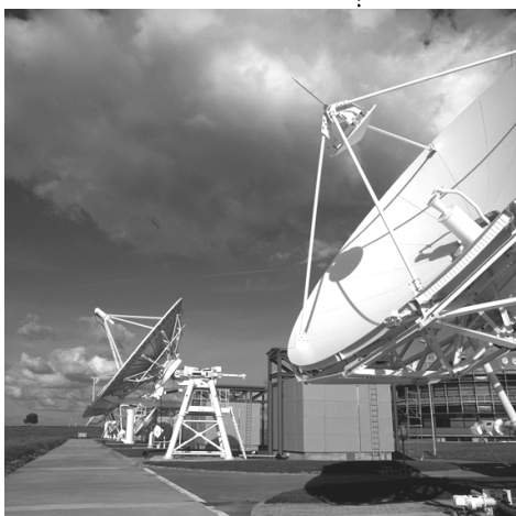
Antenas del Centro de Control de Arganda
