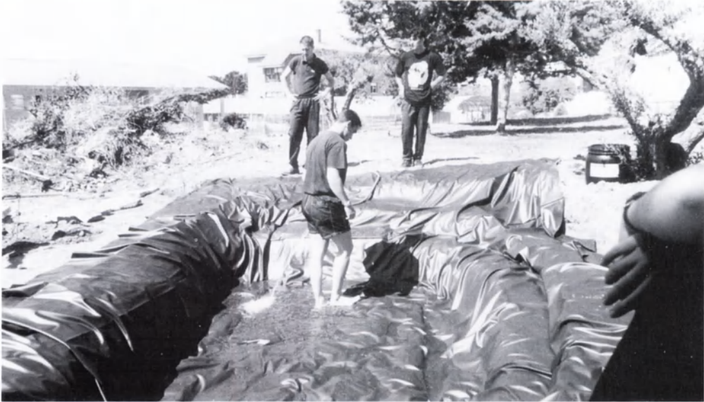
Acoplamiento de la lámina flexible.
