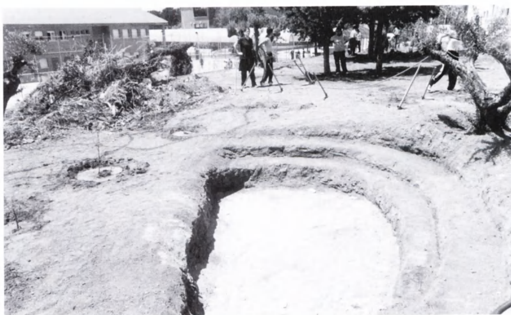
El agujero del estanque ya preparado.
