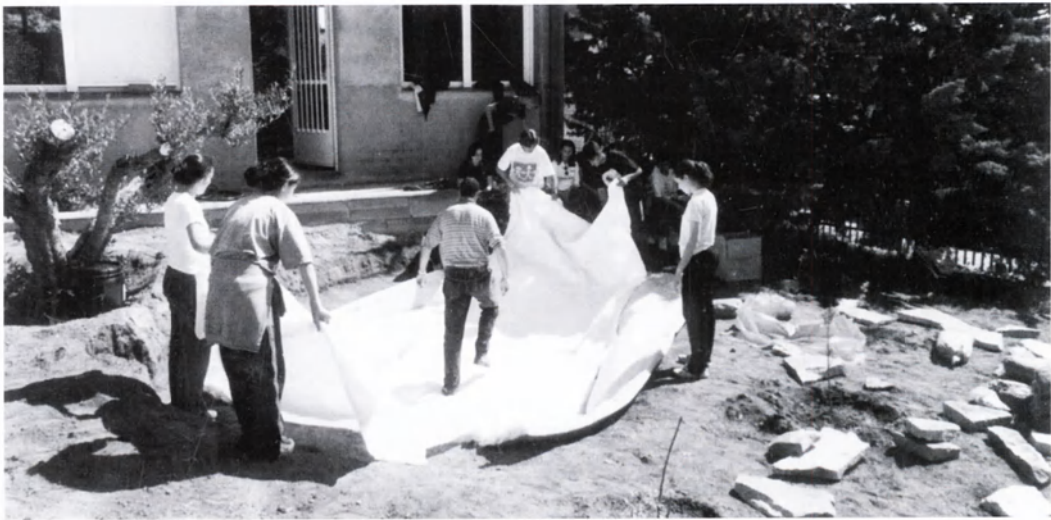
Se coloca una segunda capa de fieltro de 3 milímetros.
