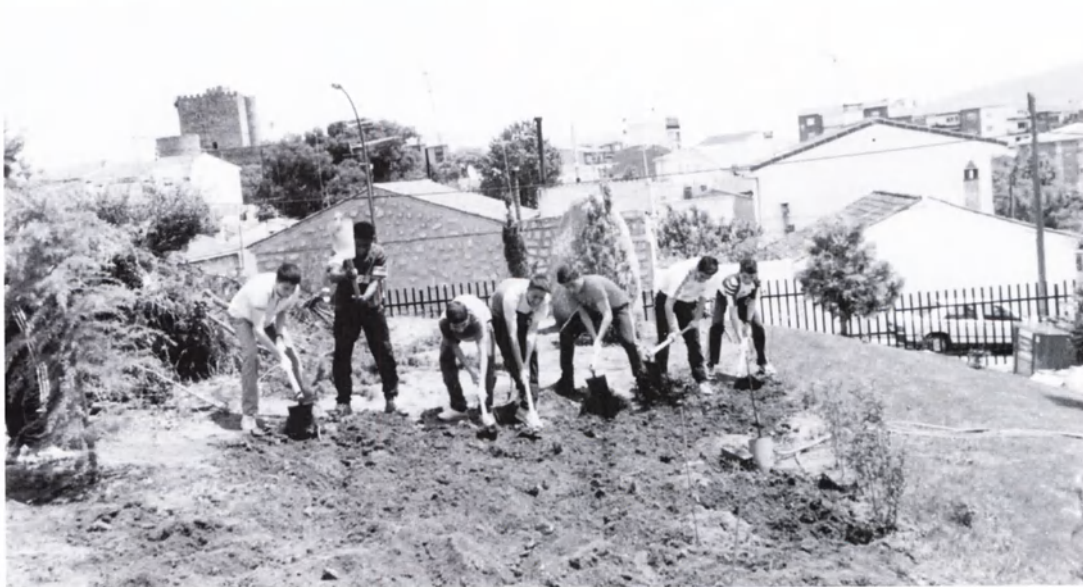
Preparación del terreno y escavación del hoyo.
