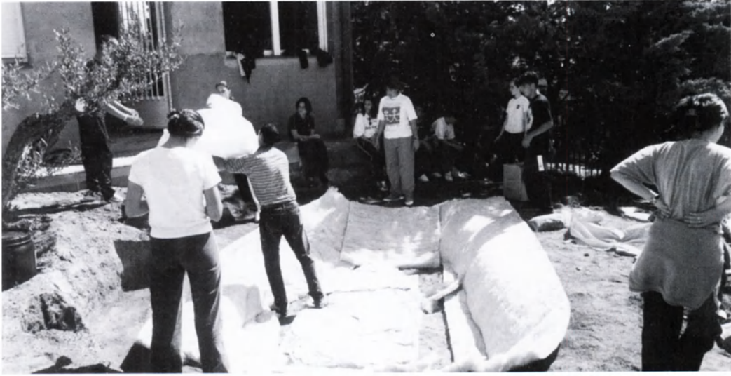
Colocación de una manta de material aislante usado en construcción.
