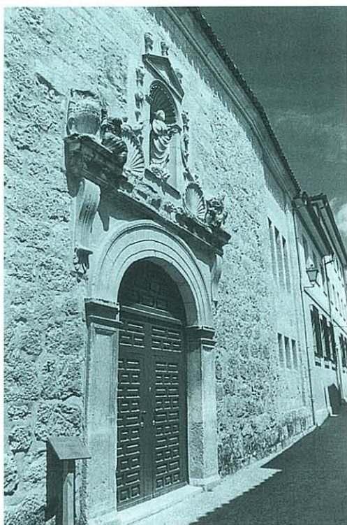
11. Fachada de la capilla del convento de las Concepcionistas Franciscanas de Torrelaguna. (Foto B. Castaño)
