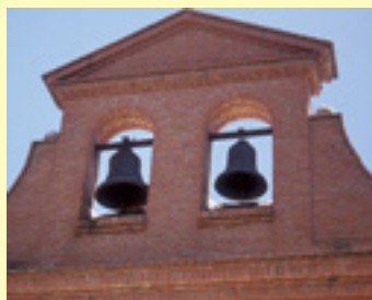
Espadaña de la iglesia
