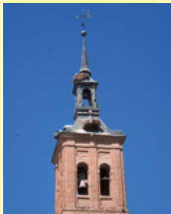
Chapitel de la torre de la iglesia
