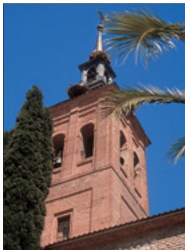
Detalle de la Torre
