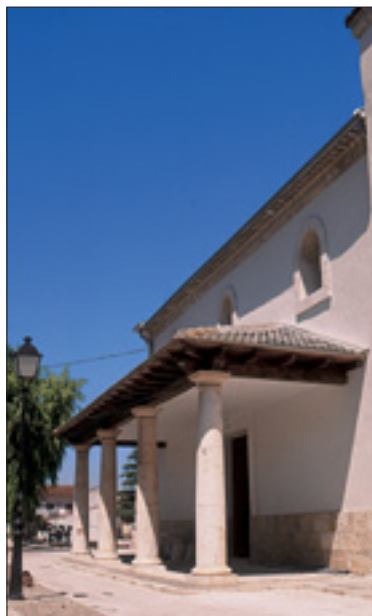
Pórtico de la iglesia
