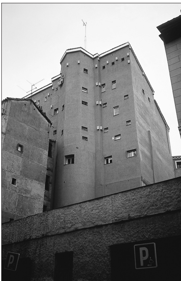
Torreón de la muralla islámica situado en la C/ de la Escalinata. Finales del S. IX
