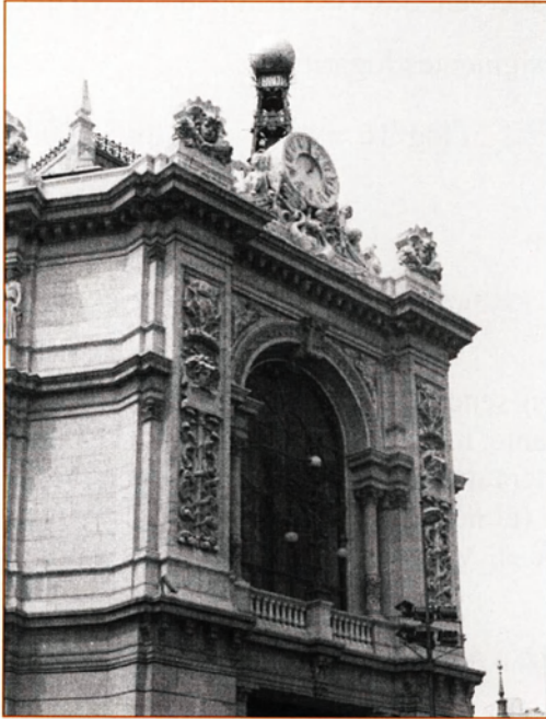
Detalle de la fachada del Banco de España en la plaza de Cibeles en Madrid.
