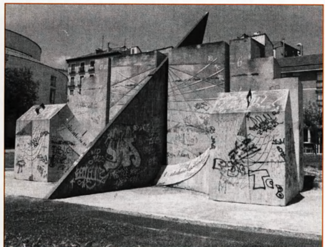
Reloj de sol cerca de la Puerta de Toledo en Madrid. Está visiblemente deteriorado.
