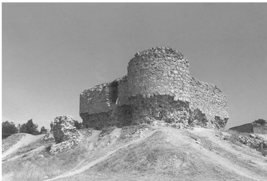
2.- Perspectiva de uno de los cubos del castillo de la Alameda. Estado exterior.
