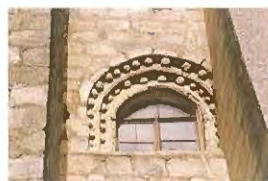
Los óculos del muro oeste antes de la intervención
