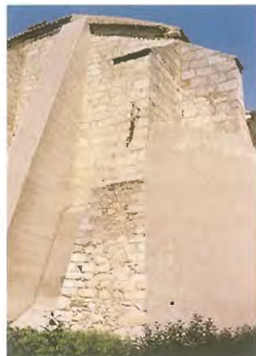
El muro de mediodía de la iglesia antes de la intervención
