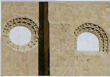
Los óculos del muro oeste después de la intervención
