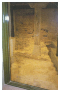
Lienzo y cubo de la muralla cristiana, integrado en el edificio de la Cava Baja, 10
