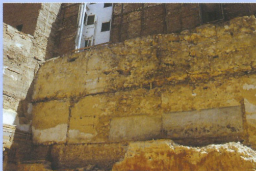
La muralla de Cava Baja, 30, durante la excavación arqueológica
