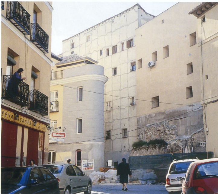
Muralla cristiana junto al nuevo edificio de calle de los Mancebos, 3.
