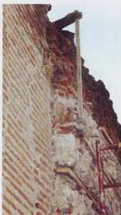
El zócalo de la sacristía se restauró con sillares de 15 cm de espesor y las cornisas se reconstruyeron con trazado y ladrillo similares a los existentes, empleando flejes de acero anclados al zuncho de coronación para asegurar su estabilidad.
