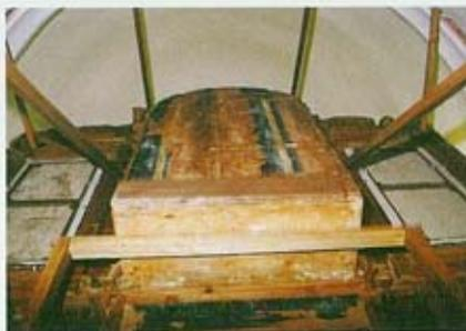
Las nuevas piezas se montaron según la ordenación original y todo el conjunto, perfectamente ajustado y nivelado, se alzó sobre una nueva estructura portante de madera diseñada a tal efecto.
