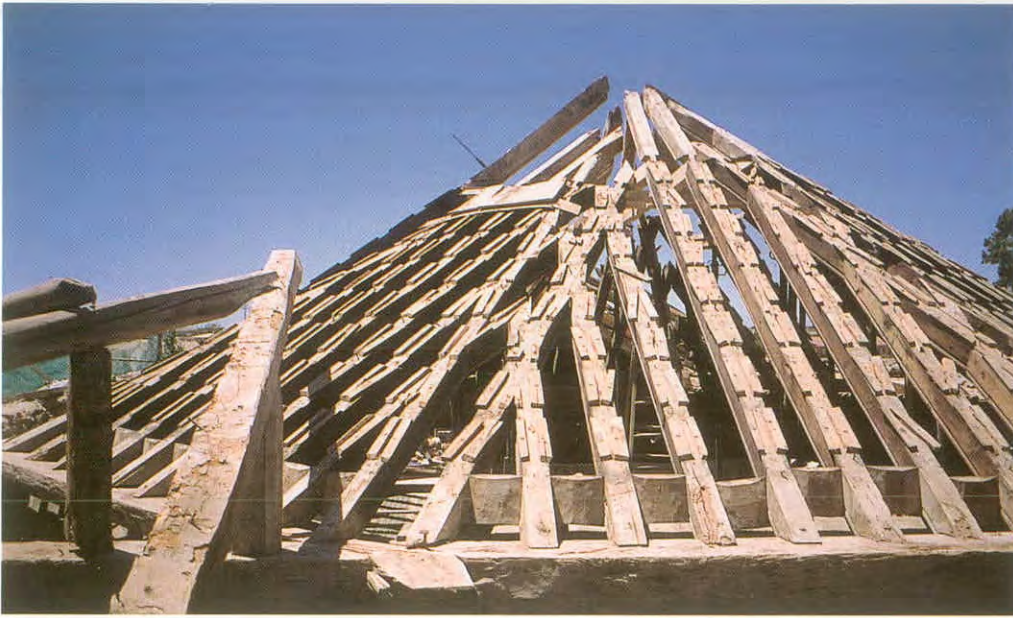
Cubierta del ábside durante la restauración
