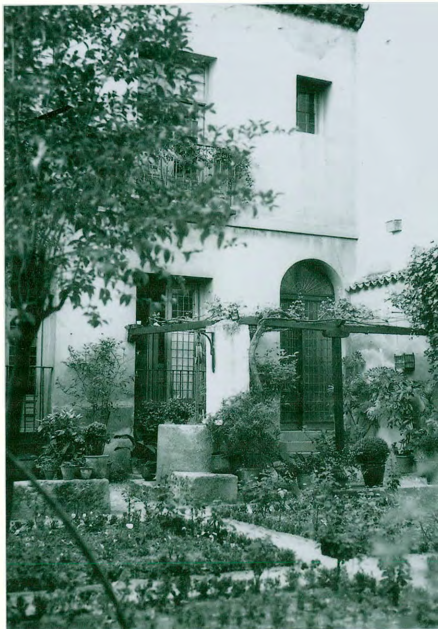
Jardín y buerto de la casa de Lope de Vega antes de la última restauración.
