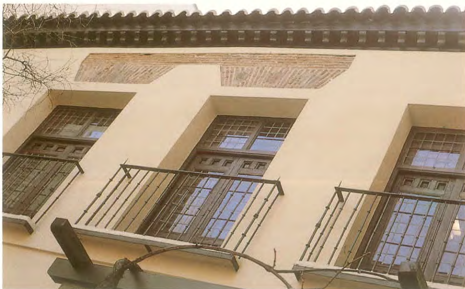
Disposición del ladrillo en el paramento del jardín.
