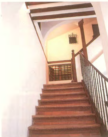
Tercer tramo de escalera. Subida a planta abubardillada.
