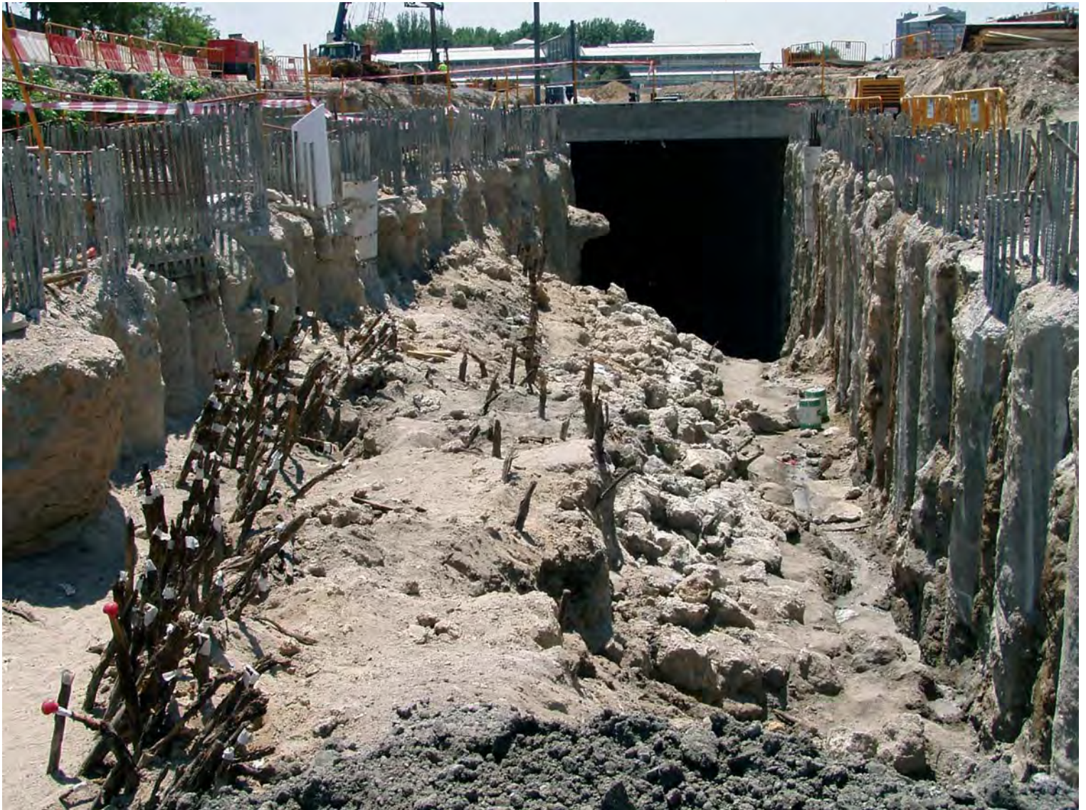
Vista general del tramo del Real Canal del Manzanares exhumado durante la realización de la rampa de acceso de la tuneladora en el parque de la Arganzuela.
