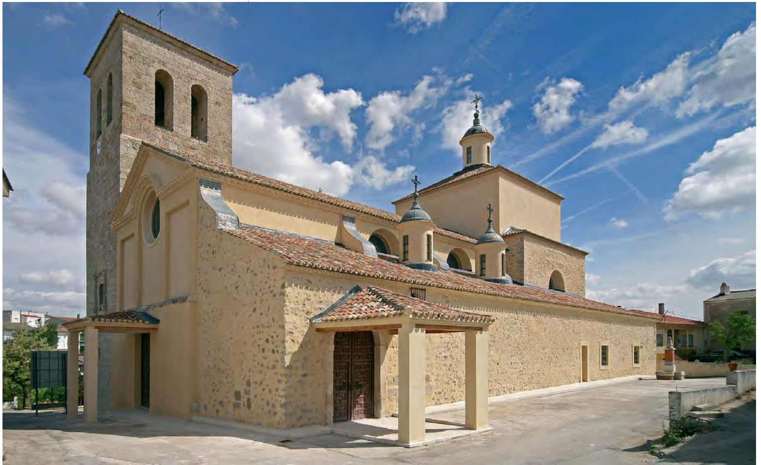
Vista general tras la restauración.
