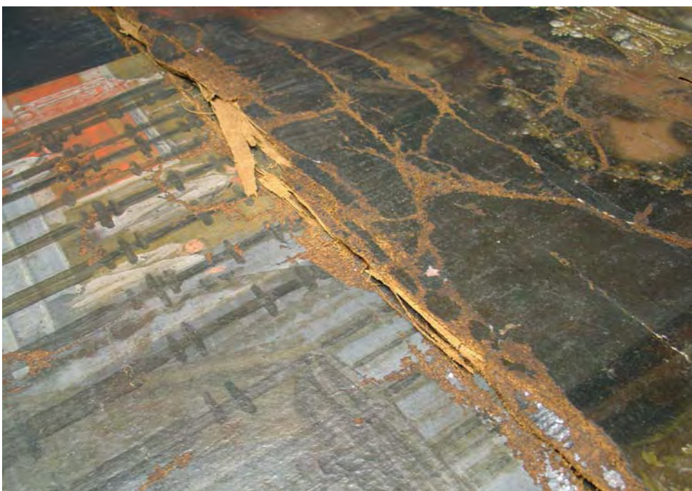
Estado de la obra tras el robo.
