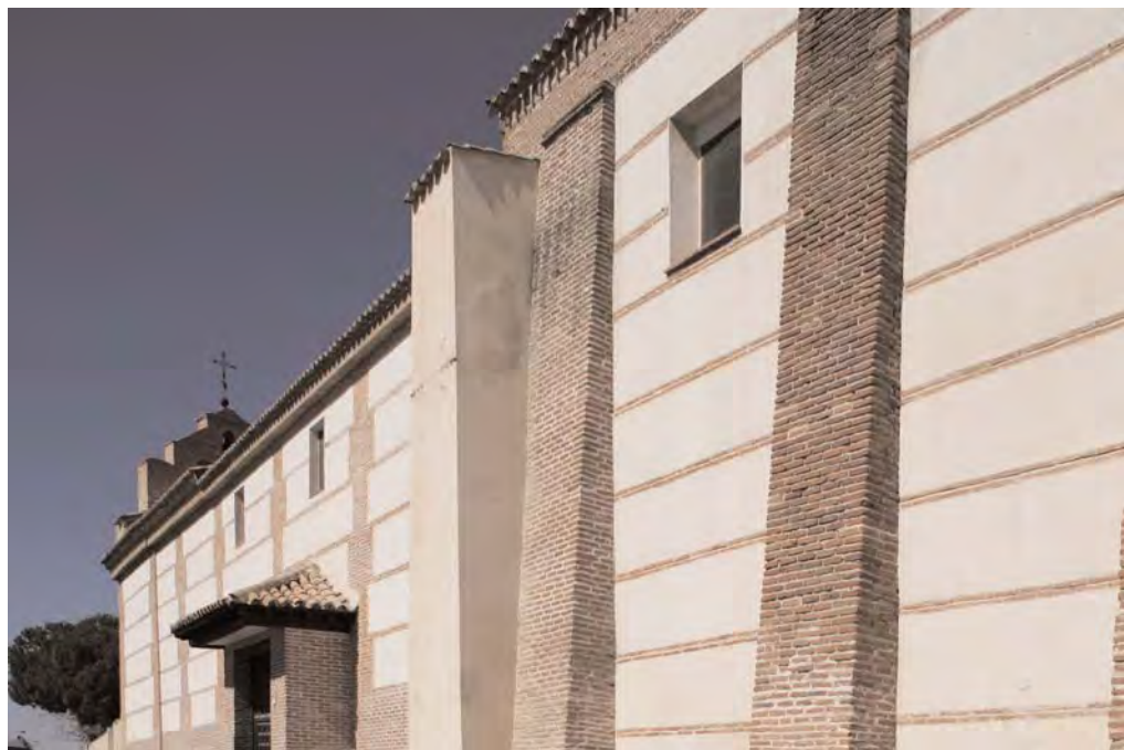
Fachada del convento tras su restauración.
