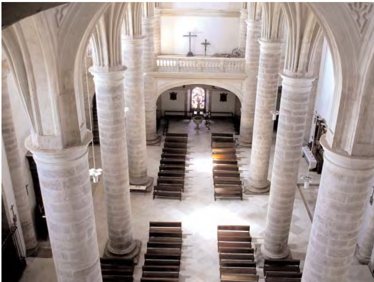
Vista interior de la Iglesia desde la cabecera
