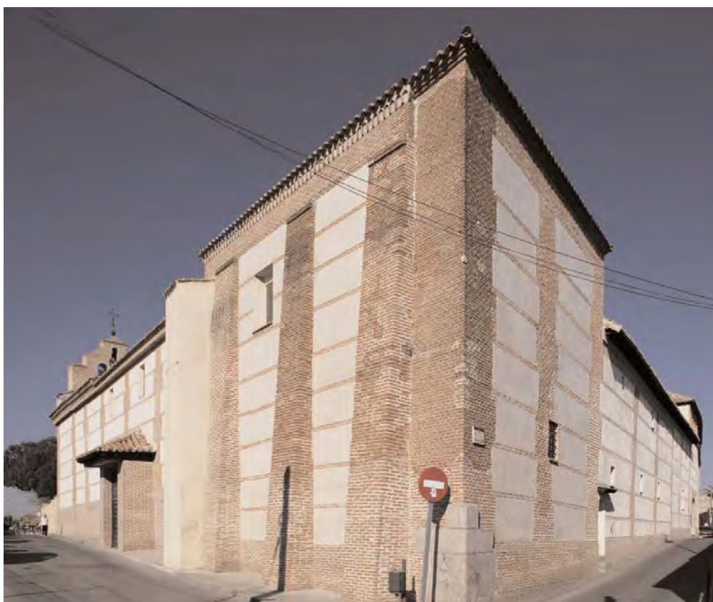
Fachada del convento tras su restauración
