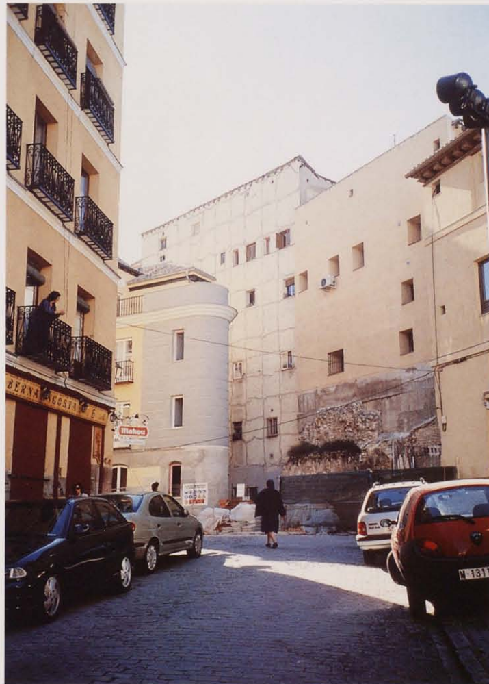
Muralla cristiana junto al nuevo edificio de calle de los Mancebos, 3
