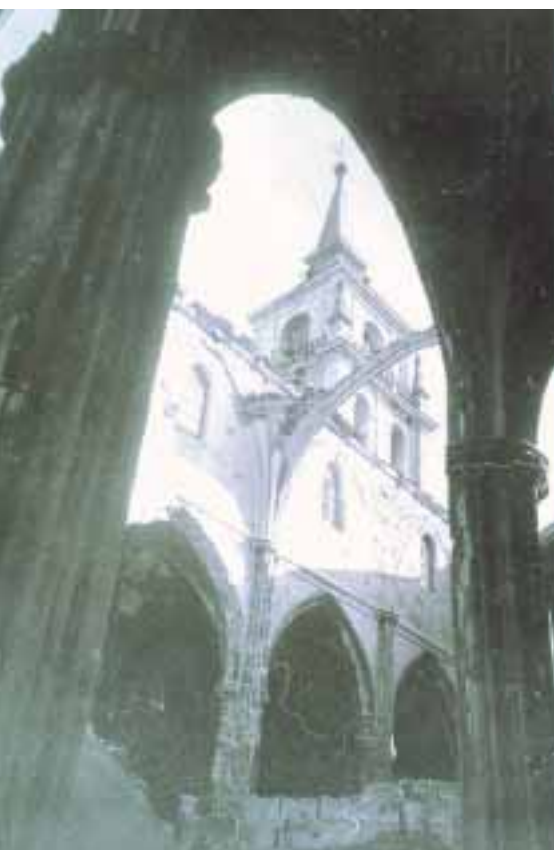
■ Derrumbes en la iglesia Magistral tras los bombardeos de 1937.
