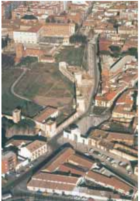
■ Vista aérea de la entrada al centro histórico de Alcalá por el oeste.
