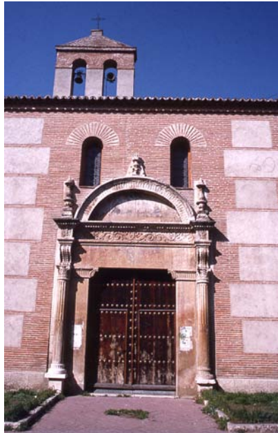
Fachada del Monasterio de Santa Catalina de Alcalá de Henares.
