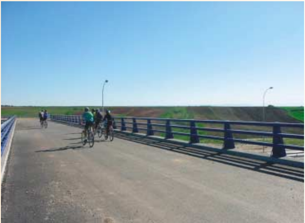
PUENTE SOBRE LA M-50.
