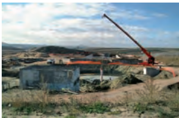
Figura 3. Construcción de una Estación Depuradora de Aguas Residuales en la Comunidad de Madrid.
