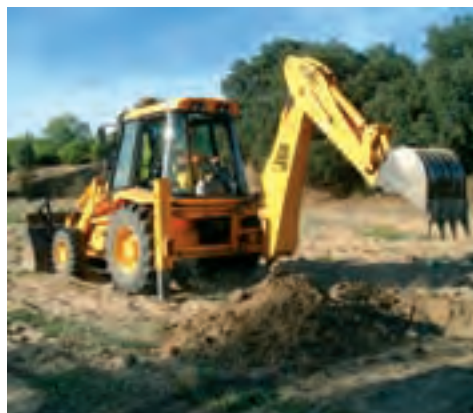
Figura 2. Fase de catas arqueológicas mecánicas para uno de los colectores.
