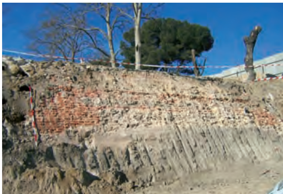
Figura 27. Línea 5: perfil con sección de alcantarillado.
