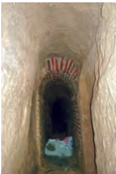
Figura 1. Líneas 1 y 4: viaje de agua (tramo con ladrillo macizo).
