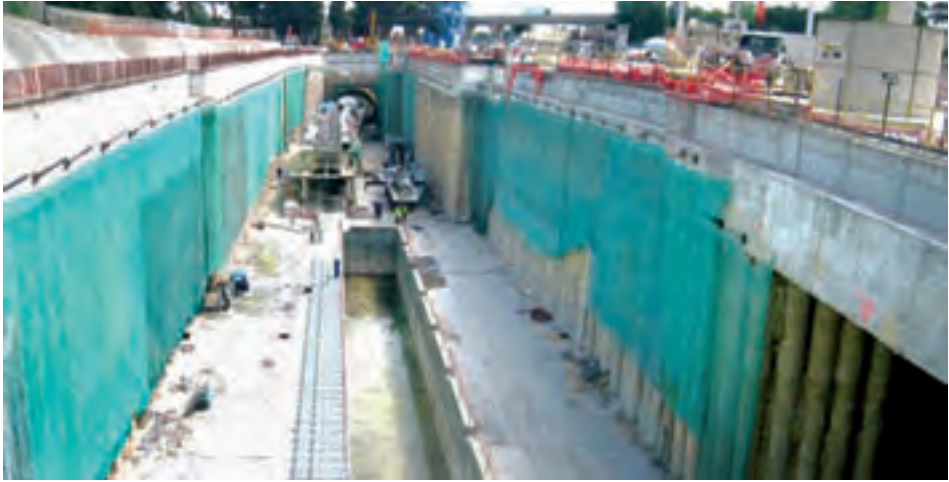
Figura 24. Línea 5: pozo de ataque.
