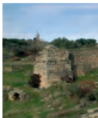
Figura 7. Vista general del cubo escalonado, del cárcavo en su cara oriental, y de la cacera sobre un muro de mampostería pertenecientes a El Molinillo (Cadalso de los Vidrios, Madrid).
