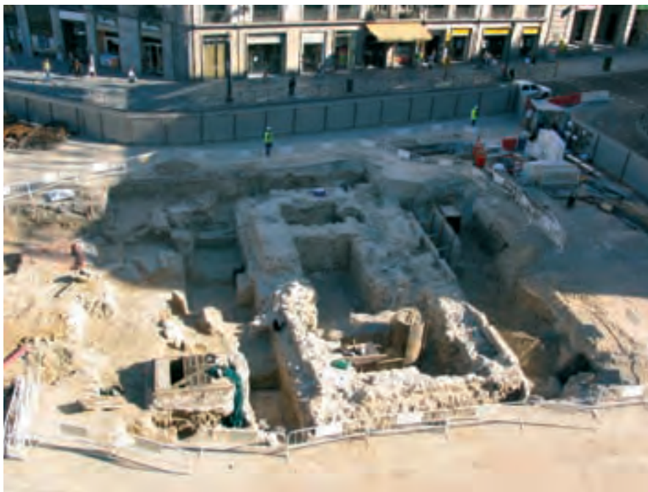
Vista aérea de los cimientos pertenecientes a la iglesia del Hospital del Buen Suceso, siglo XV al siglo XIX (Puerta del Sol-Madrid), aparecidas durante las obras de Metro/Cercanías. (Foto Pilar Mena).
