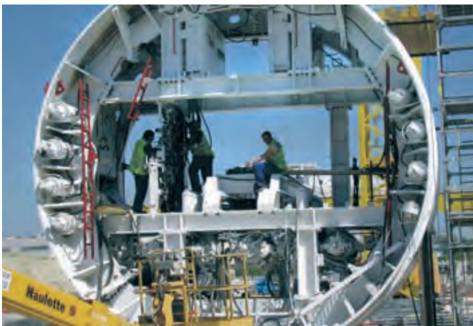
Figura 38. Línea 7 (tramos II, III y IV). Método constructivo con tunelador.
