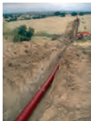
Figura 4. Zanqueo para el Emisario de Sevilla la Nueva.
