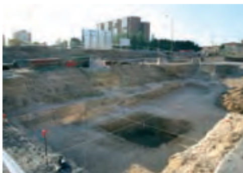
Figura 13. Excavación en la estación "12 de octubre" (línea 3).
