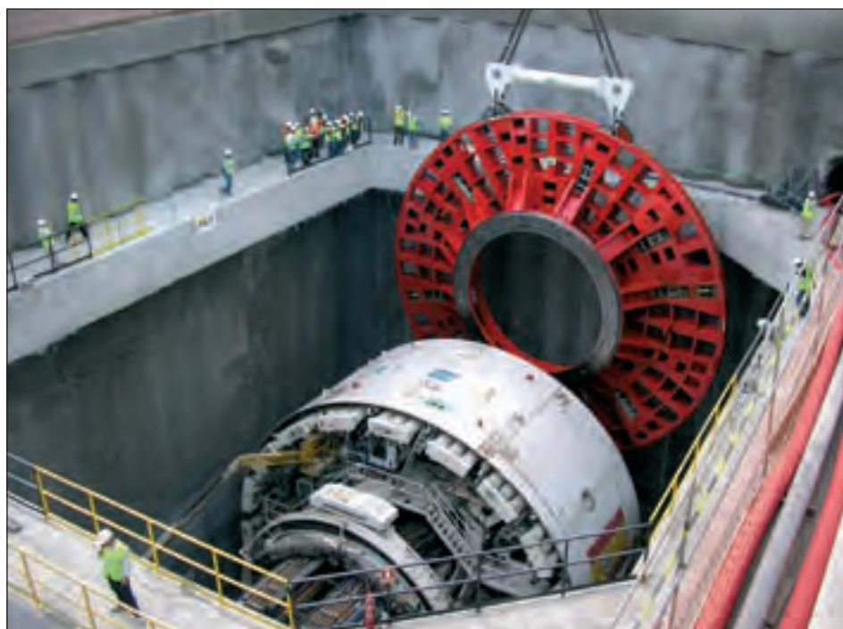
Figura 13. Tuneladora en el by-pass sur.
