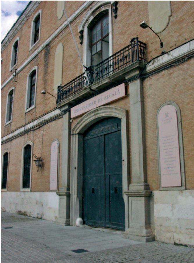
Cuartel del Príncipe de Asturias, construido sobre el solar donde estuvo ubicado el convento de San Diego hasta su demolición en 1858.
