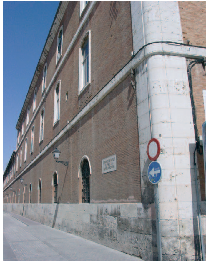
Fachada del cuartel del Príncipe, vista desde la esquina de la plaza de San Diego o de la Universidad.
