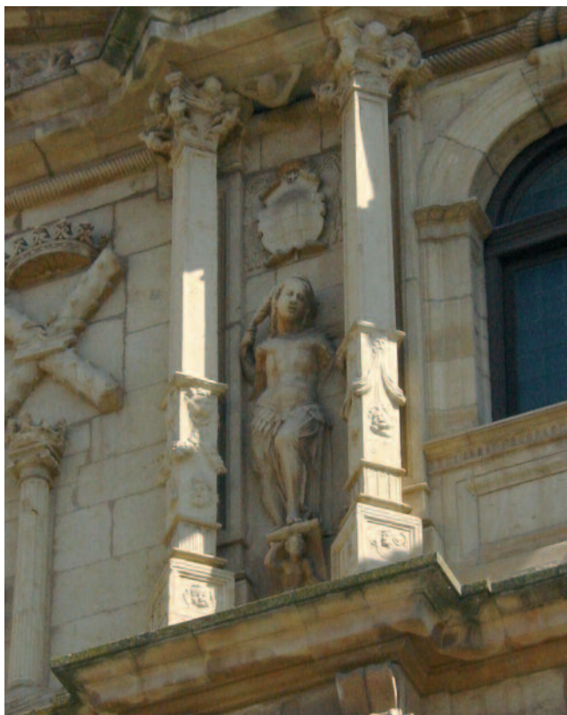
Detalle de la fachada del colegio mayor de San Ildefonso.
