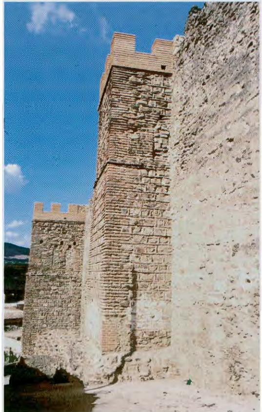
Detalle de las torres del sector occidental del recinto amurallado (Archivo Dirección General de Patrimonio Histórico)
