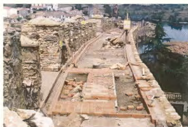
Diferentes fases en el proceso de rehabilitación del pavimento del adarve (Archivo Dirección General de Patrimonio Histórico)
