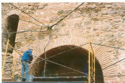
Detalle de los trabajos de restauración en la Torre del Reloj. (Archivo Dirección General de Patrimonio Histórico)
