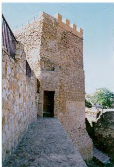
Vista de una torre restaurada (Archivo Dirección General de Patrimonio Histórico)
