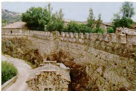
Superior Detalle de la muralla en la que se aprecian las distintas técnicas y materiales empleados en su construcción (Foto: Vicente González Pachón)
