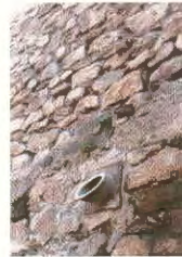
Detalle del desagüe instalado en la muralla. (Archivo Dirección General de Patrimonio Histórico)
