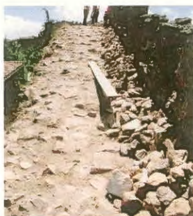
Fase inicial y final en los trabajos de rehabilitación del adarve (Archivo Dirección General de Patrimonio Histórico)
