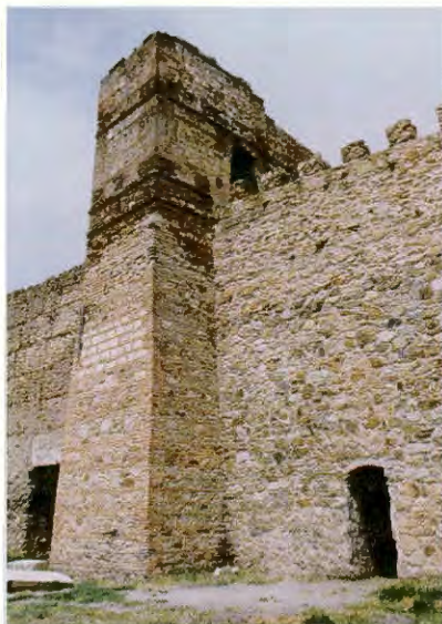
Detalle de las torres del muro sur y castillo de los Mendoza (Foto: GEOCISA. Geotecnia y Cimientos S.A.)
