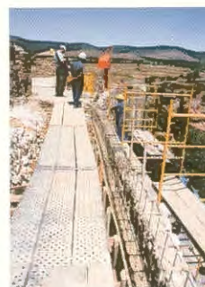
Trabajos de consolidación y acondicionamiento del adarve para facilitar el acceso de visitantes. (Archivo Dirección General de Patrimonio Histórico)
