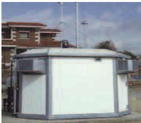
Figura 1-2 Diseño exterior de las estaciones nuevas instaladas. Nueva estación de Control ubicada en Chapinería (Zona Oeste).
