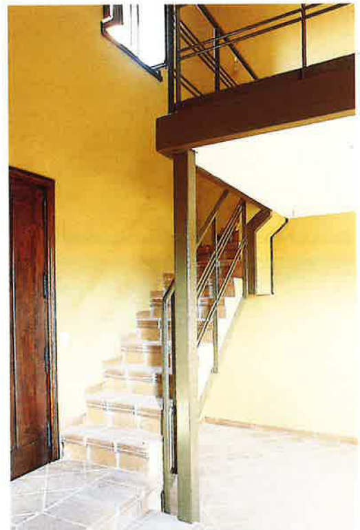
Escalera de los Alojamientos de la calle Pozas.
