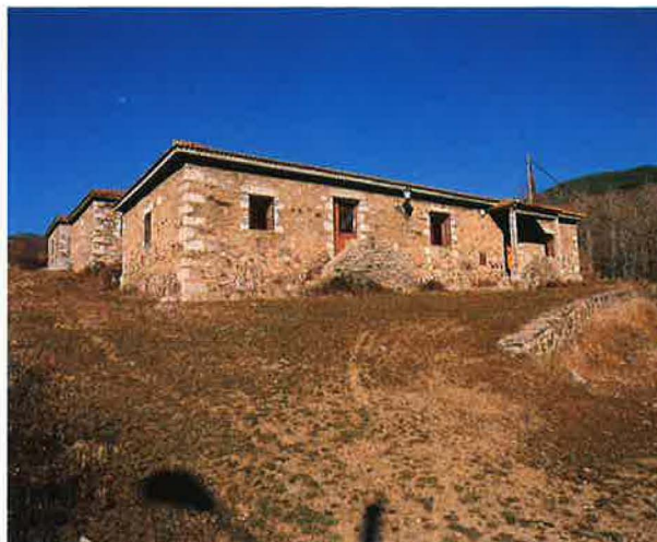
Antiguo albergue de los obreros de Obras Públicas, recuperado también para la red de Alojamientos turísticos en Puebla de la Sierra.
