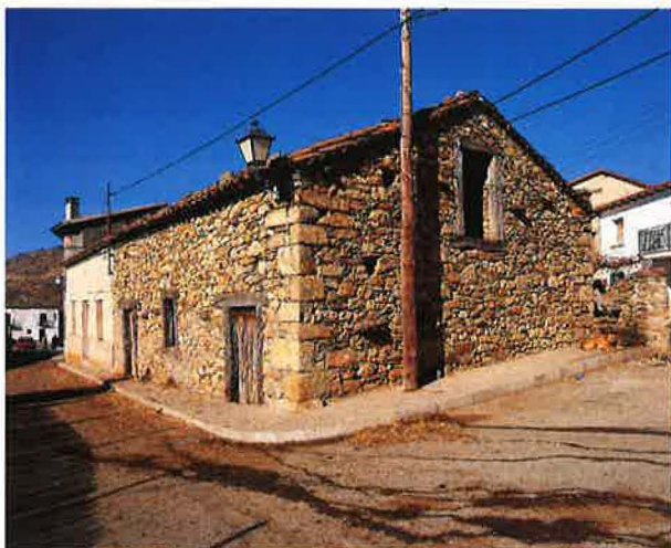
Antigua fragua de Prádena, rehabilitada y convertida hoy en Alojamiento turístico.
