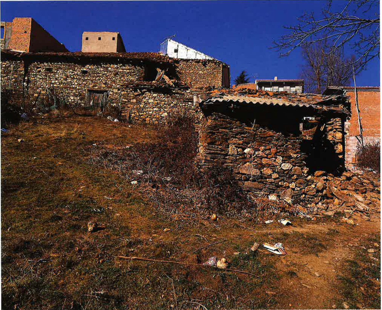
Una muestra del abandono y de las agresiones arquitectónicas de los tiempos sin normativa. Hoy, este edificio alberga unos Alojamientos turísticos en Montejo.
