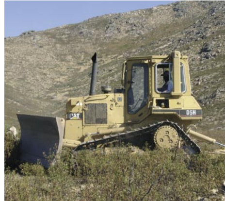
Pala empujadora de cadenas para realizar tareas de desbroce y subsolado
