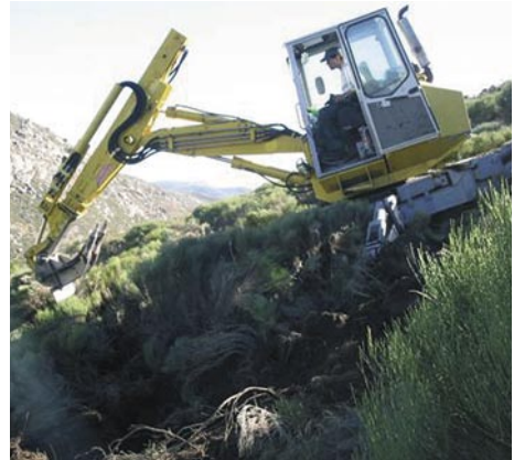
Apertura mecanizada de hoyos de plantación con retroaraña
