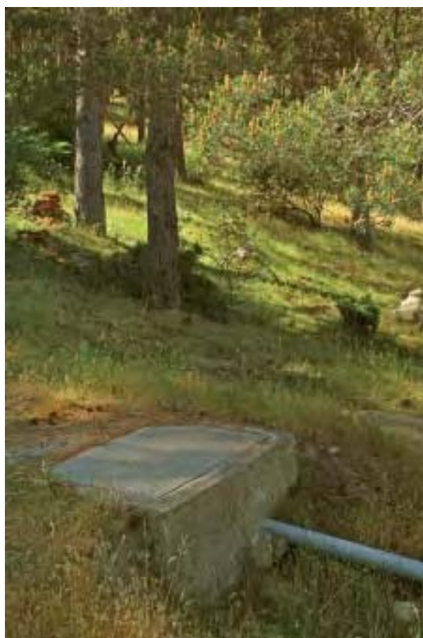
Toma de agua del manantial, situado en la ladera de Cabeza de la Braña, que alimenta las tres fuentes mencionadas
