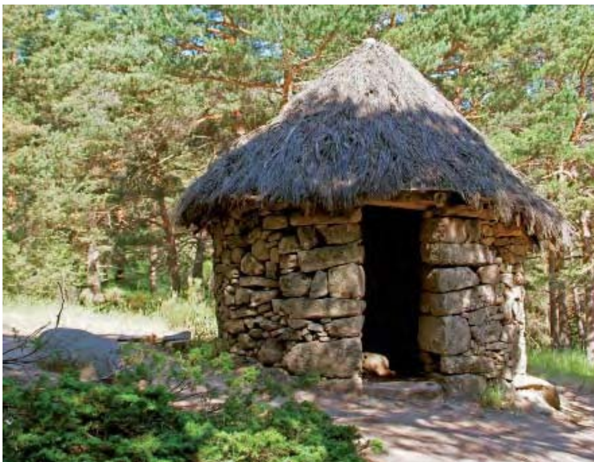
Chozo construido por el grupo de Agentes Forestales de la Comarca II en el año 2007, sobre uno derruido
