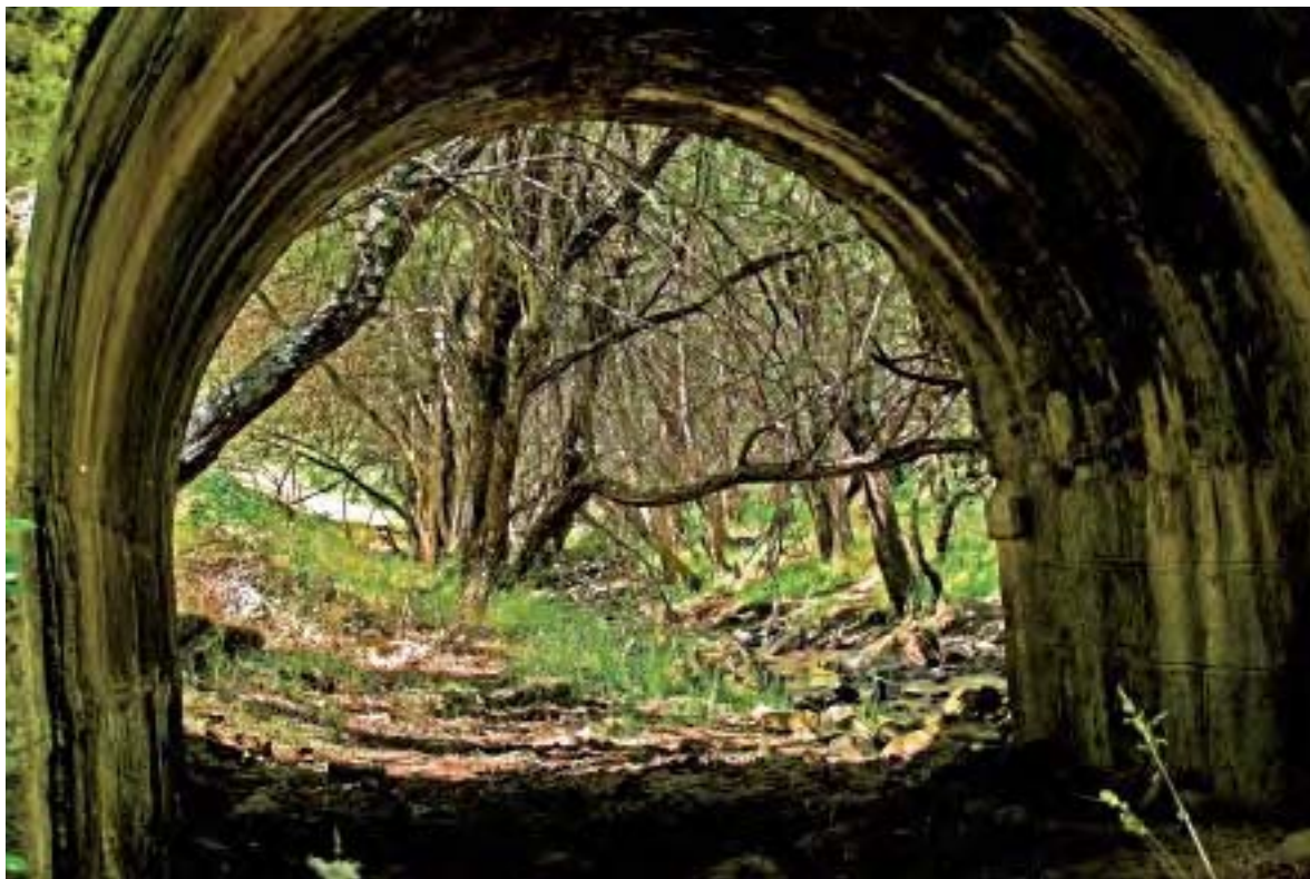
Puente sobre el Arroyo de Canencia
