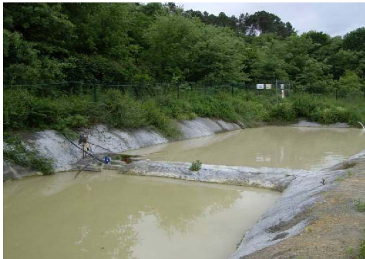
Figura 86. Balsas acondicionadas para el vertido de aguas sucias.
