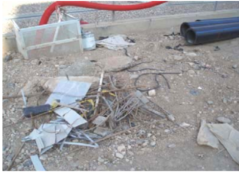
Figura 69. Residuos de construcción depositados sin control sobre suelo natural
