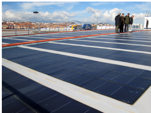
Figura 27. Panel Instalado en Cubierta de nave
