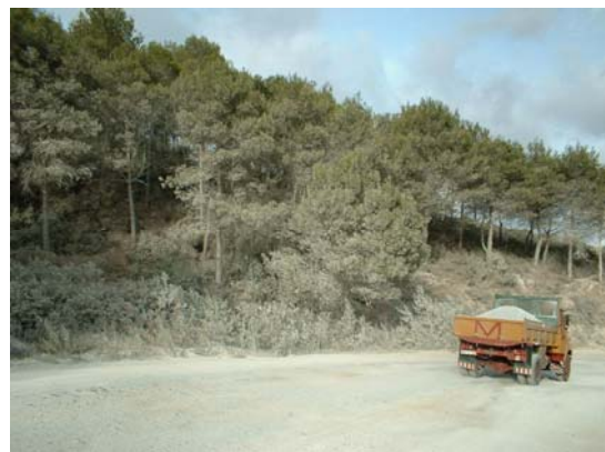
Figura 74. Emisiones de polvo y ruido en una obra, efectos sobre la vegetación
