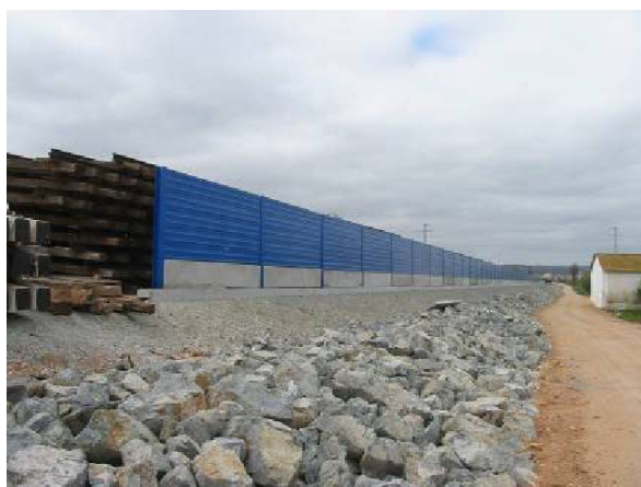
Figura 75. Apantallamiento artificial absorbente
