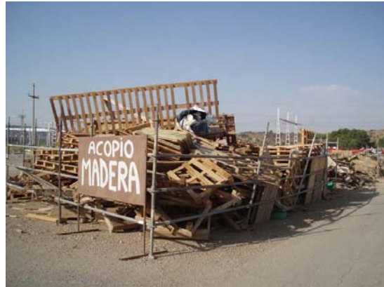
Figura 65. Zona destinada al acopio de madera
