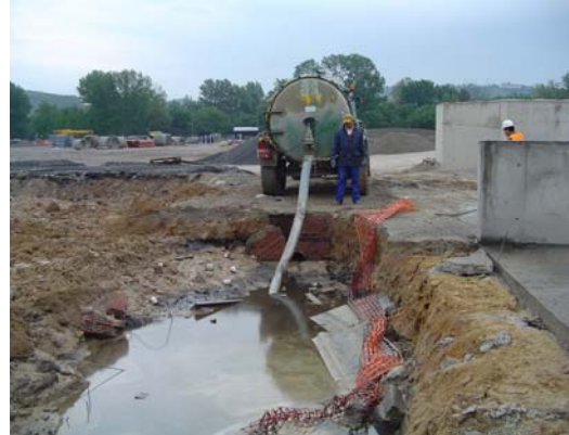
Figura 85. Recogida de aguas durante excavación
