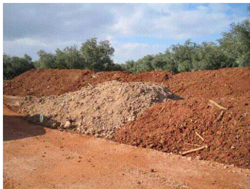
Figura 80. Acopio de tierra vegetal
