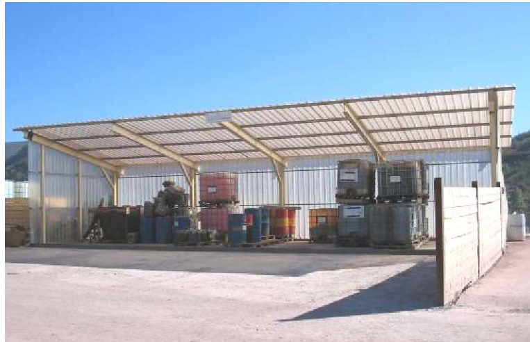
Figura 63. Punto Limpio en obra
