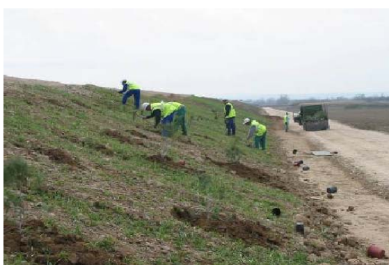
Figura 90. Revegetación manual de un talud.
