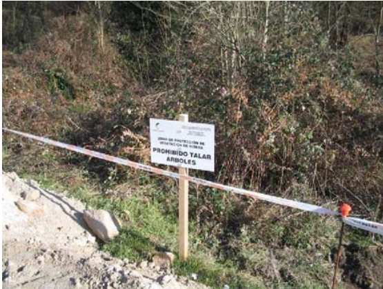
Figura 88. Jalonamiento y prohibición de talas.
