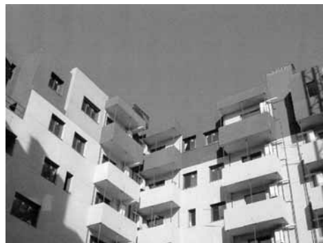
Vista del patio interior.
