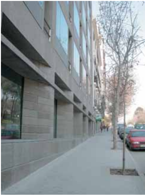
Vista general del acceso principal.
