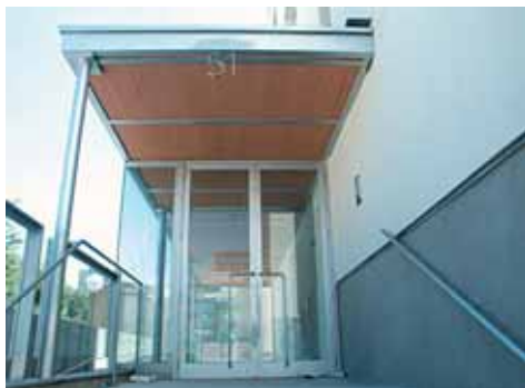
Vista del portal de acceso.
