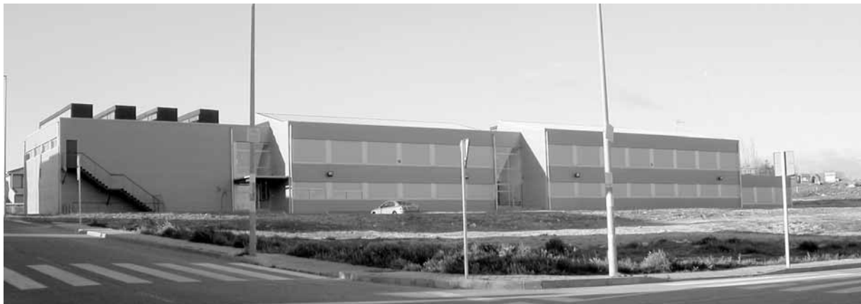
Vista fachada N.
