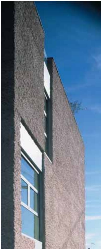
Detalle de la fachada O.
