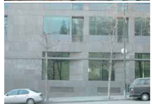
Vista del zócalo en fachada.
