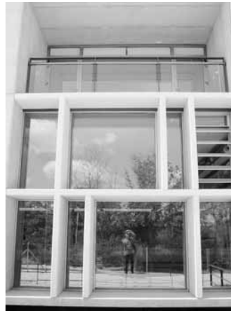
Vista de la fachada E.
