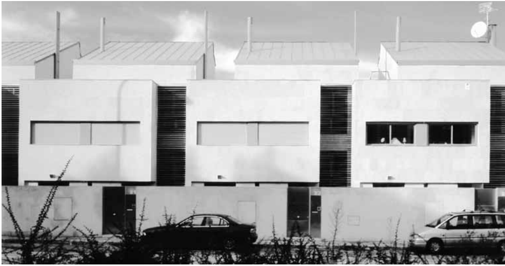
Vista general SE.
