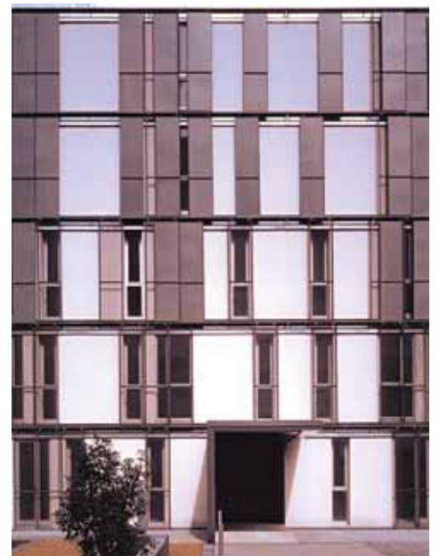
Detalle de fachada Edificio B.
