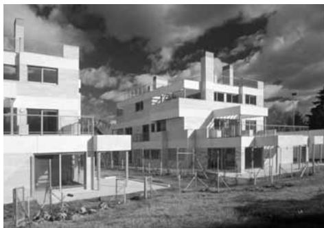
Vista O de los bloques 2 y 3.
