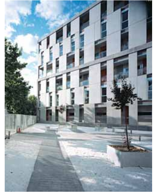
Vista de los paneles de fachada.
