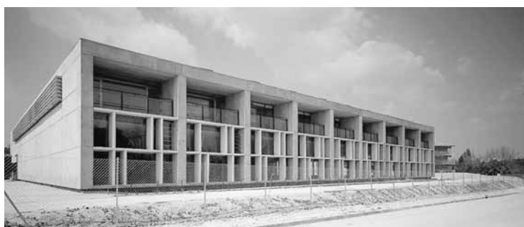
Vista de la fachada E.
