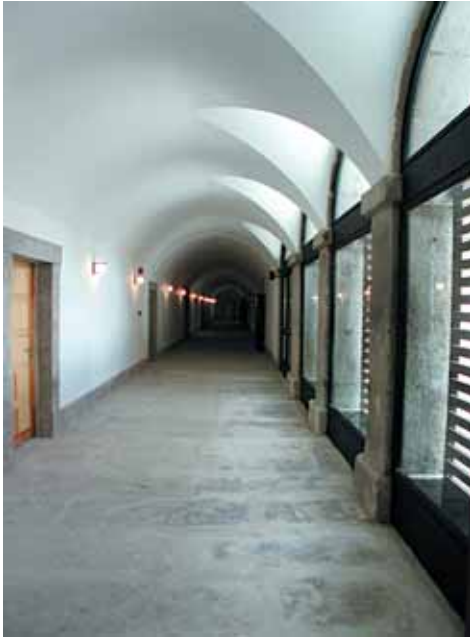
Planta primera. Vista interior de la galería de acceso.
