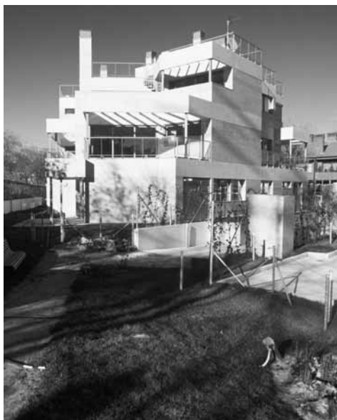
Vista S. Bloque 1.
