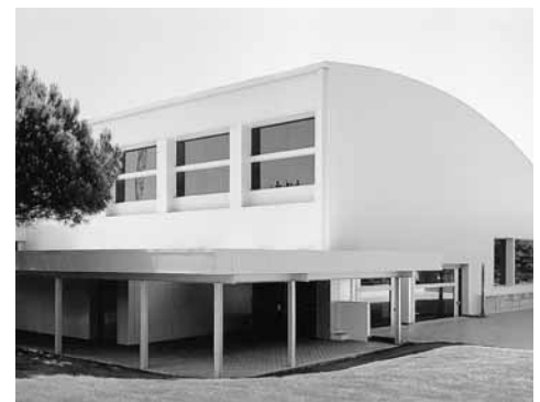
Vista del acceso.
