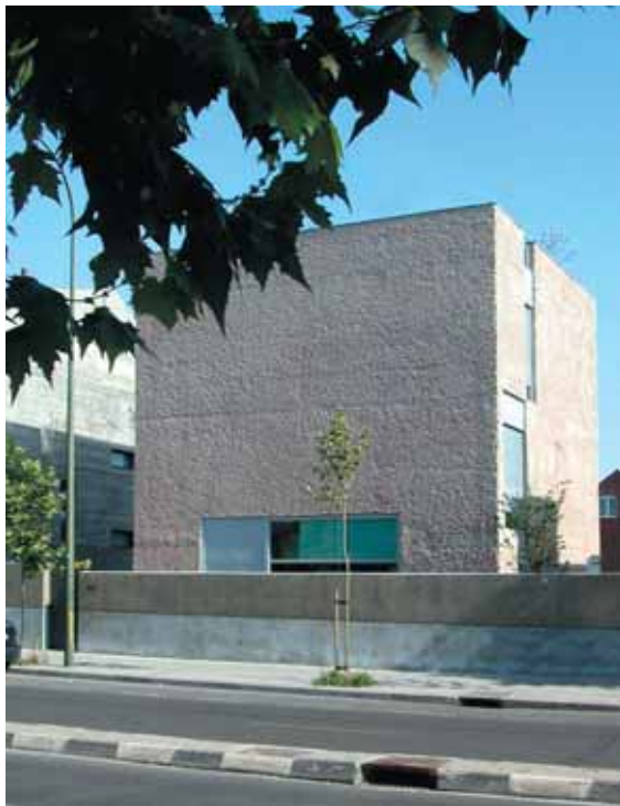
Vista fachada N.
