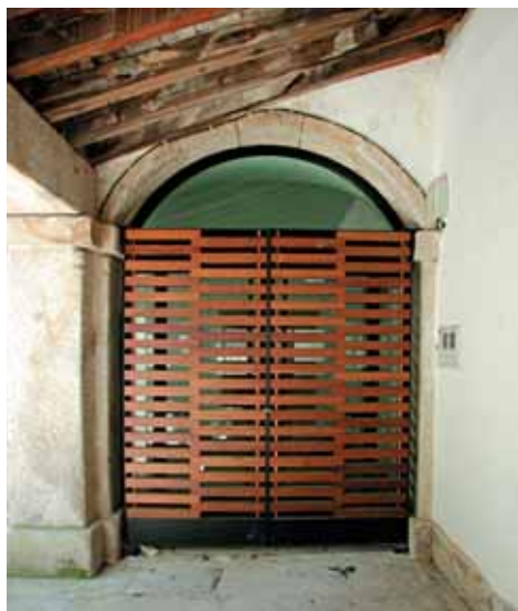
Detalle del cierre de los huecos de la galería interior.
