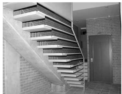
Vista interior del núcleo de escaleras.
