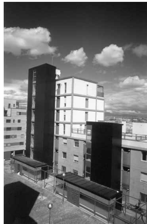
Vista general SE de la fachada interior.
