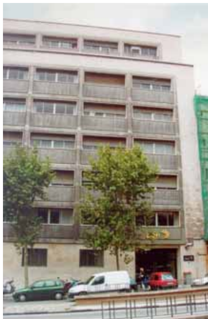
Estado original de la fachada a la calle Alfonso XII.
