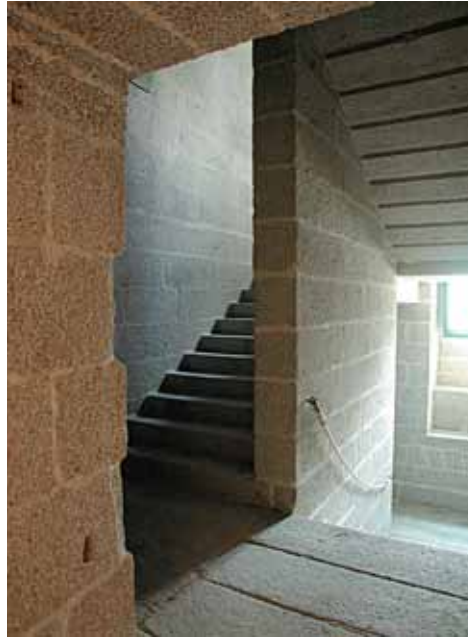
Escalera en la planta primera.
