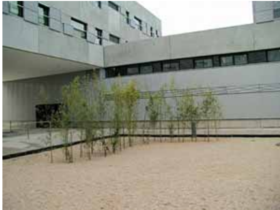
Vista del patio interior.
