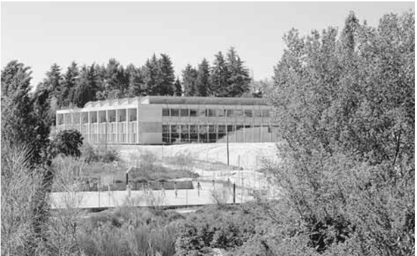
Vista general NE.
