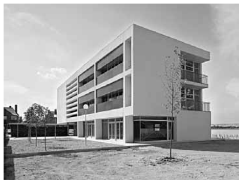
Vista general SE.
