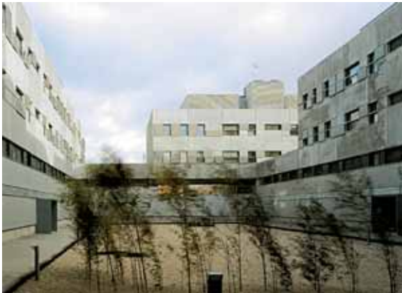
Vista del patio interior.
