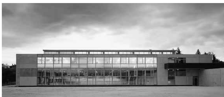
Vista de la fachada N.
