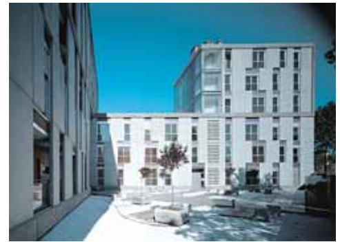
Vista fachada E.
