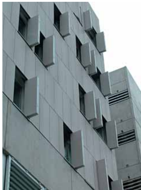
Detalle fachada O.
