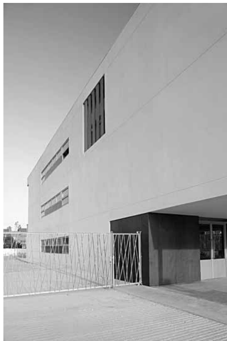
Vista fachada N.
