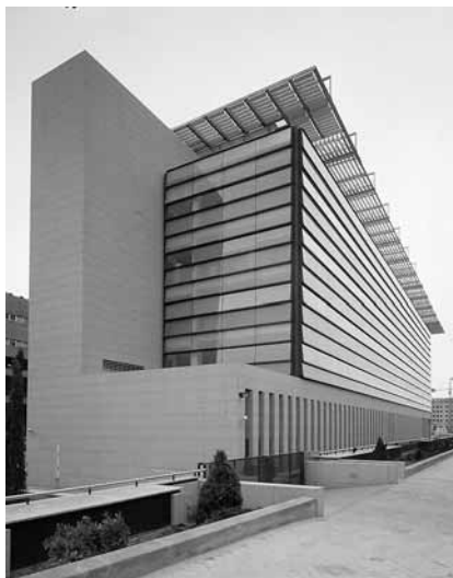
Vista general NE.
