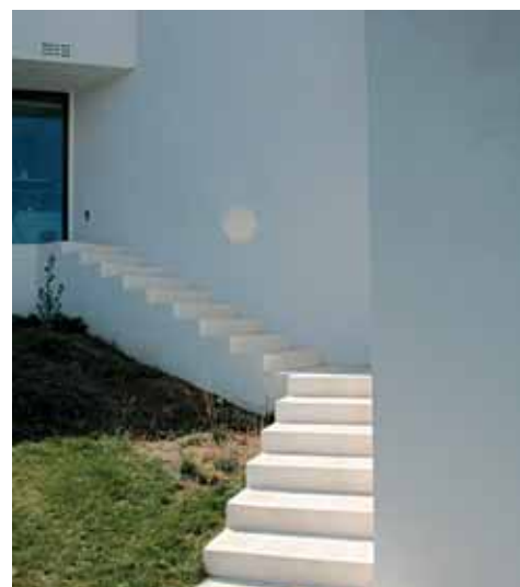
Vista de unos de los accesos secundarios.
