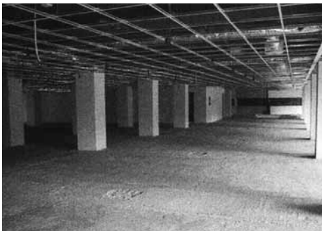
Fases de la obra.
