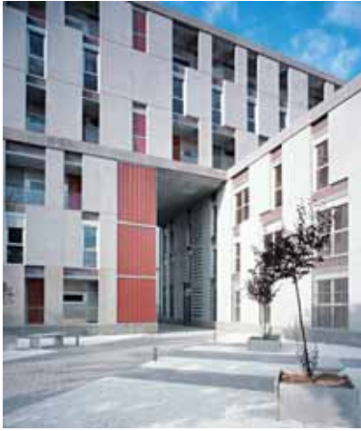
Vista de la fachada N.
