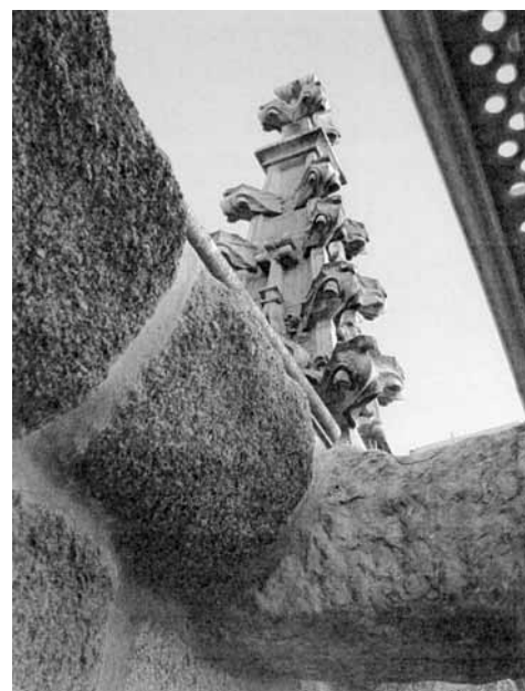
Detalle de la cornisa del chapitel restaurada.
