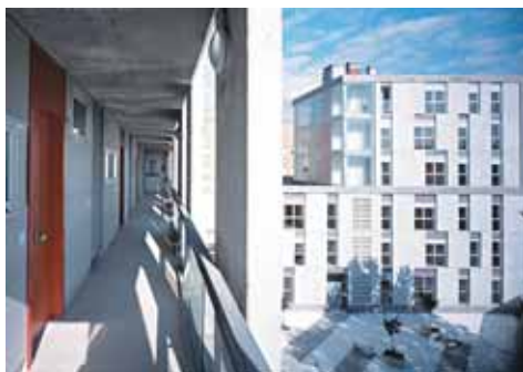
Vista desde las galerías de la fachada N.
