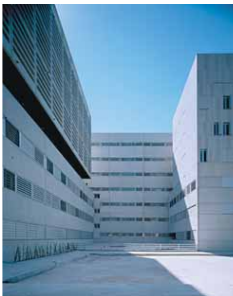
Vista general del patio.
