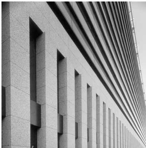
Detalle de la fachada N.
