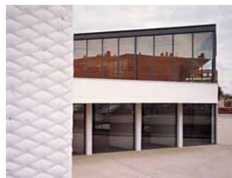
Vista del acceso.
