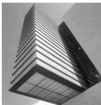
Vista exterior de la caja de escaleras.
