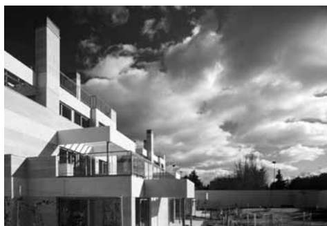
Vista NO del patio común.
