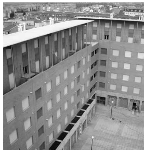
Detalle de fachada.
