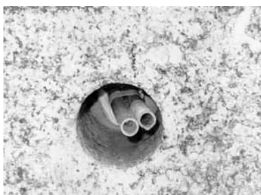
Detalle de taladro y tubos de inyección.
