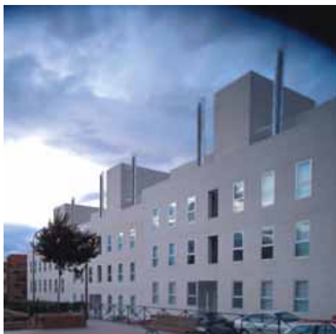
Vista de los tramos escalonados en fachada principal.
