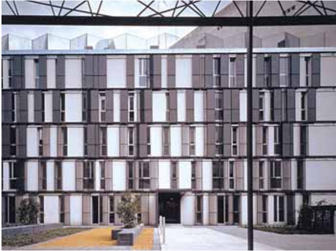
Fachada O del Edificio B.
