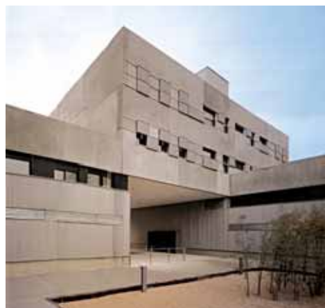
Detalle del encuentro entre bloques.
