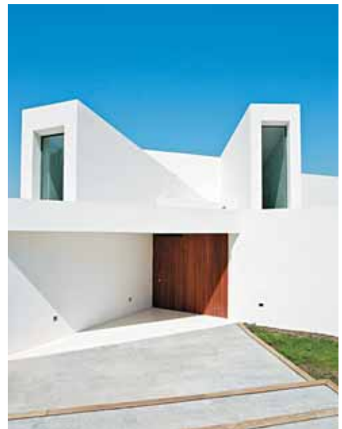
Vista NE del acceso principal.
