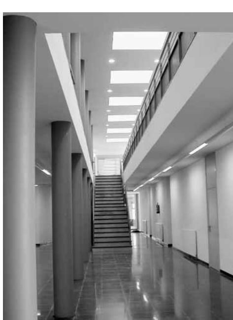
Vista del hueco de una de las escalera del distribuidor y lucernarios en cubierta.
