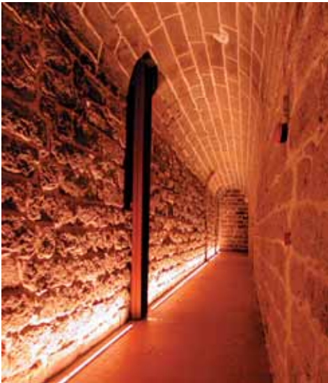
Galería de trasdos de la planta baja.
