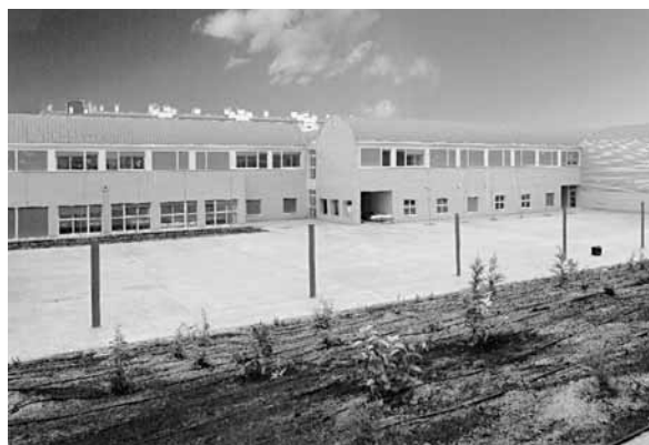
Vista general SE.
