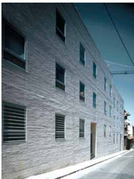
Vista de los tramos escalonados en fachada principal.
