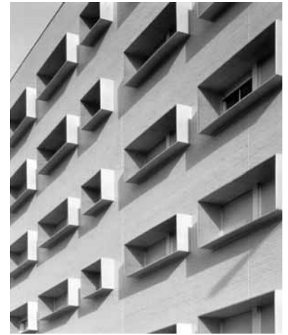
Detalle de la fachada N.
