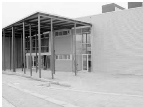
Vista de la marquesina de acceso.
