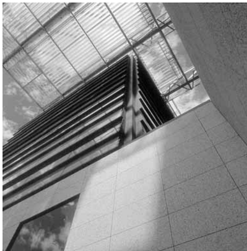
Vista inferior de la marquesina.
