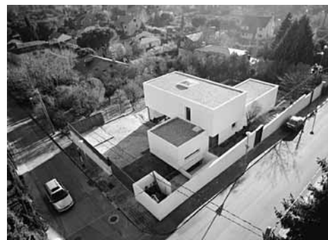
Vista del emplazamiento.
