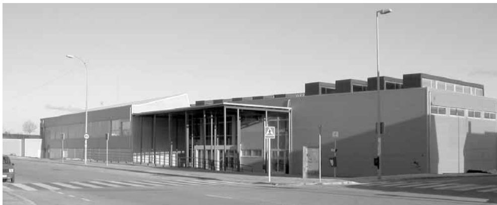
Vista general SE.
