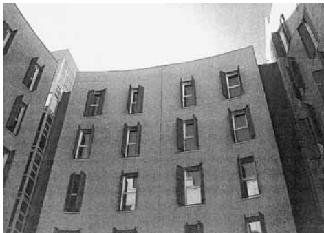
Vista de la fachada al patio interior.
