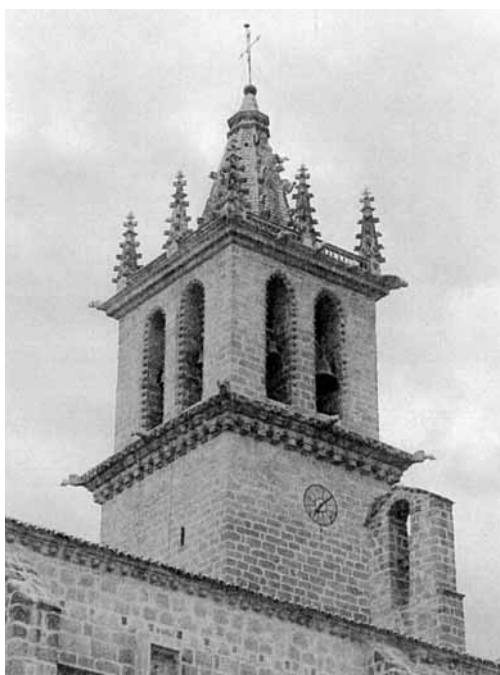
Vista NE de la torre restaurada.
