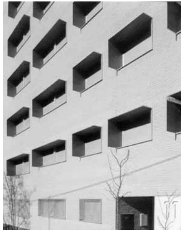
Detalle de la fachada S.
