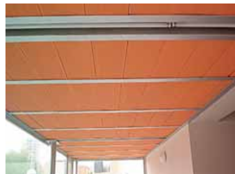
Detalle del acabado de techo en portales.
