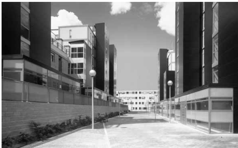
Vista del patio interior.
