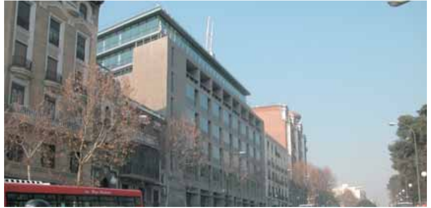
Vista general de la fachada E.
