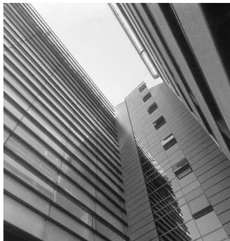
Vista del espacio entre los volúmenes principales.
