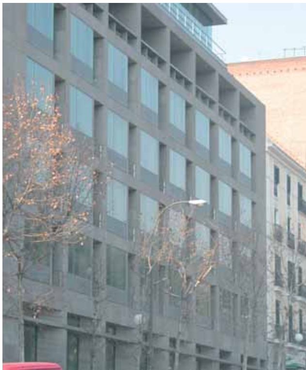
Estado final de la fachada a la calle Alfonso XII.
