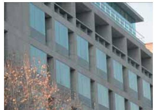
Vista de la fachada a la calle Alfonso XII.
