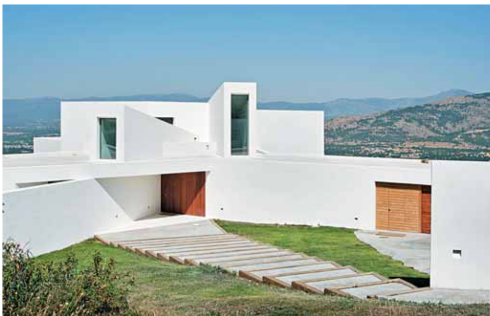
Vista general NE.
