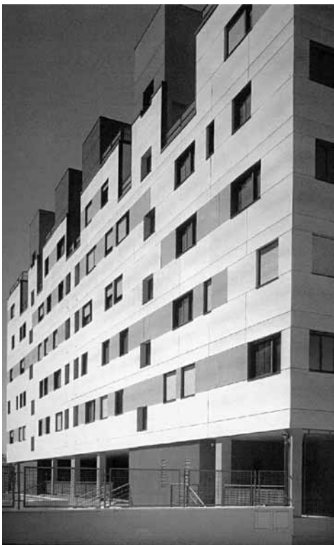
Vista de la fachada E.
