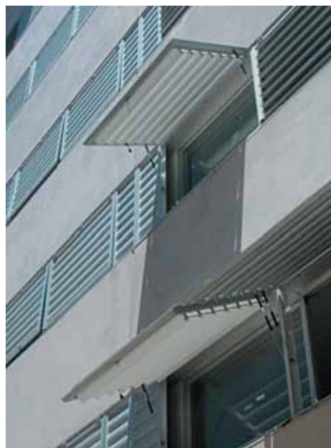
Detalle fachada S.
