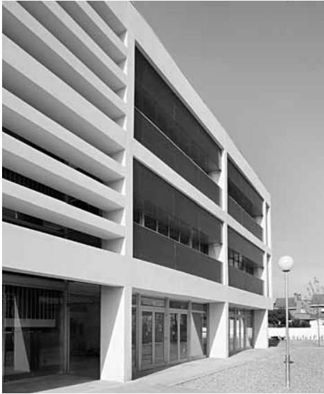
Detalle de la fachada S.
