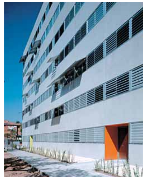
Vista fachada S.
