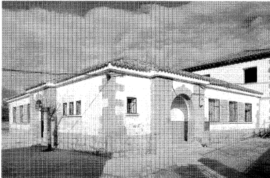
Escuelas. Fot. Actividades y Servicios Fotográficos, S.A.
