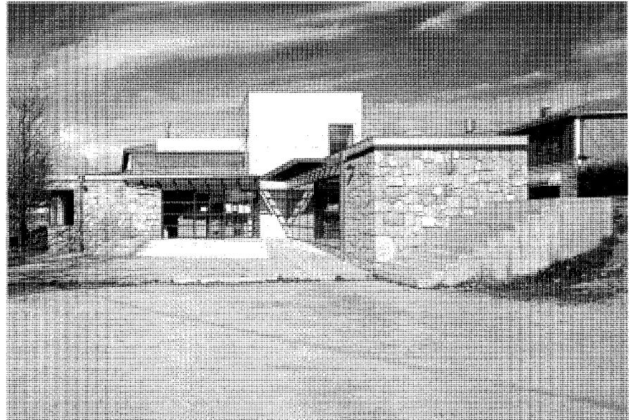
Acceso principal. Fot. Miguel Angel Vega Delgado.
