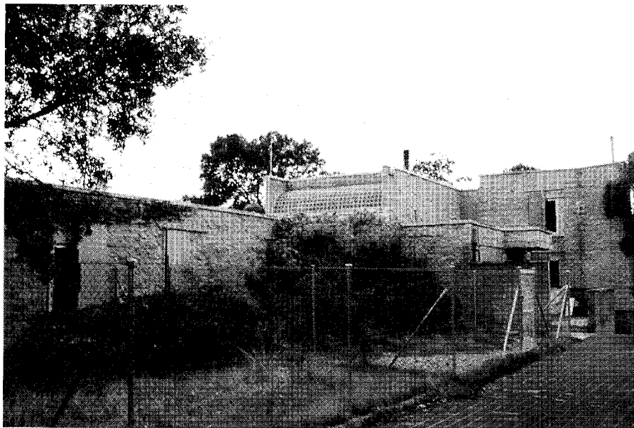
Fachada Este. Fot. Pilar Martín-Serrano
