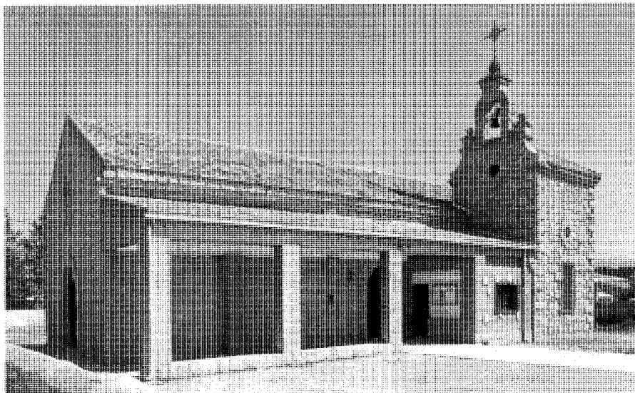
Iglesia de la Colonia de Los Negrales. Fot. José Rodríguez Ablanedo.
