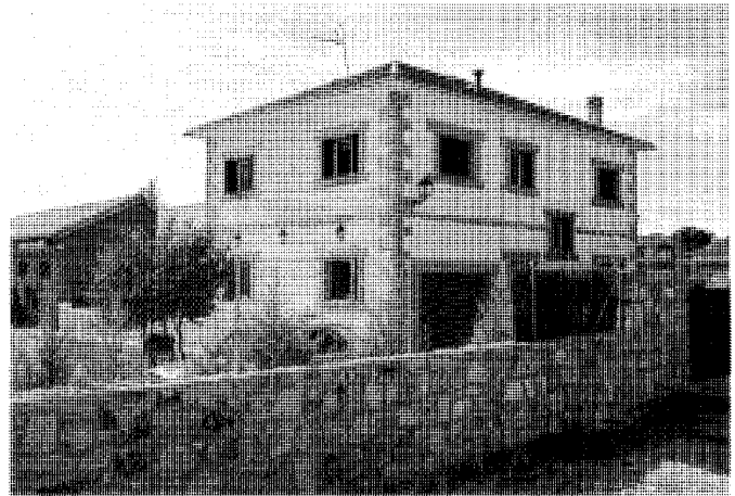
Vivienda típica de los años cincuenta. Fot. José Rodríguez Ablanedo.
