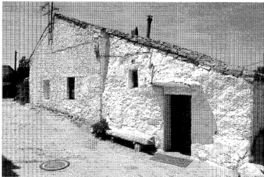
Vivienda de gran simplicidad en la calle de la Fragua, junto a la antigua carretera de Moralzarzal. Fot. José Rodríguez Ablanedo.
