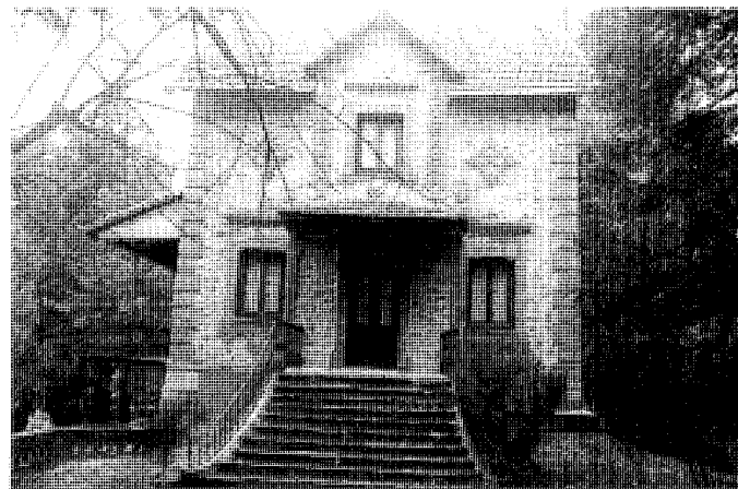
Puerta de acceso. Fot. Natalia Torreblanca.
