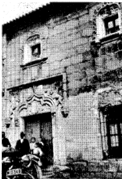
Fachada de la Casa del Cura. Arquitectura civil española de los siglos I al XVIII.
