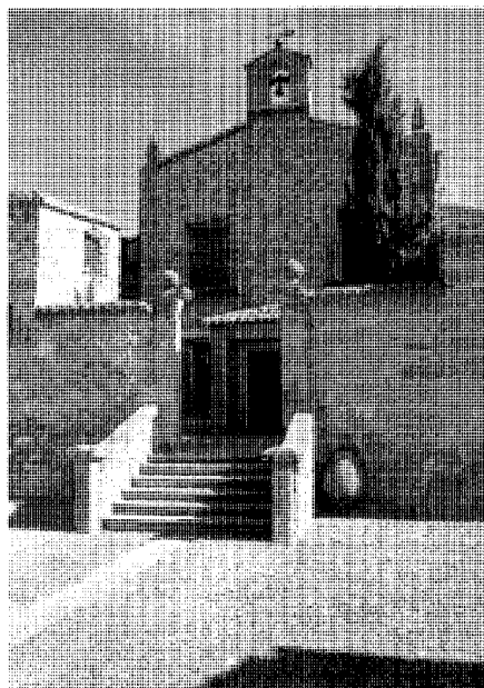
Fachada al patio. Fot. Alberto Tellería.
