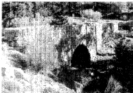
Puente del Descalzo. Fot. Natalia Torreblanca.
