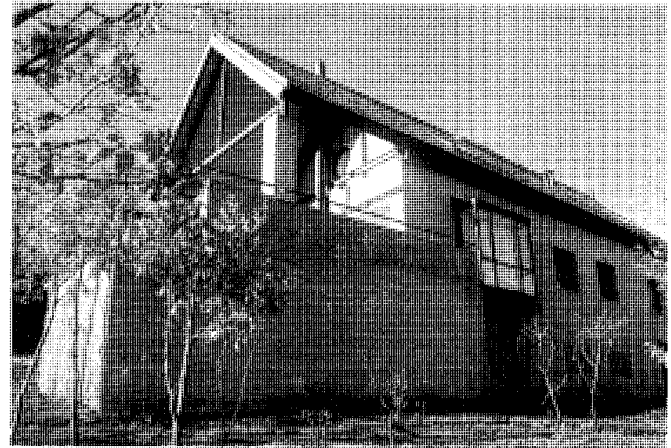
Vivienda en la Colonia de Ilos Prados. Arquitecto: Miguel Martín Escanciano. Fot. Natalia Torreblanca.
