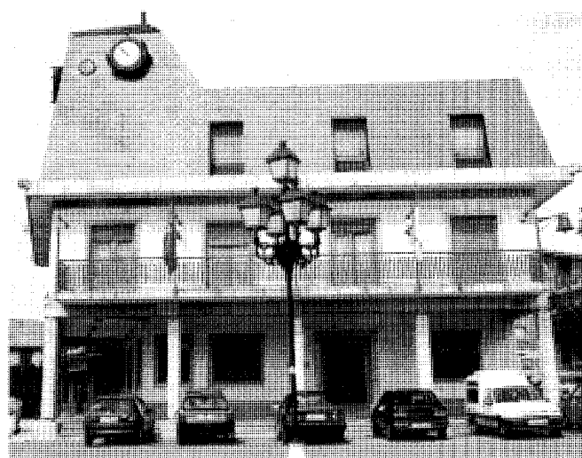
Nuevo Ayuntamiento. Fot. Pilar Martín-Serrano.
