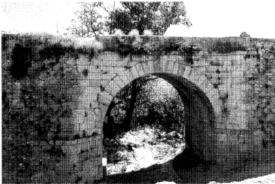
Frente aguas abajo. Fot. Pilar Martín-Serrano.
