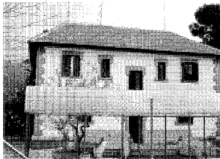
Colegio público de Los Negrales. Fot. Pilar Martín-Serrano.
