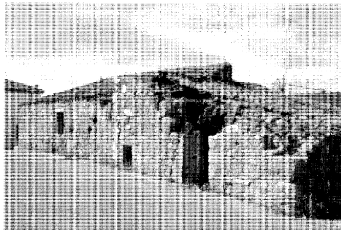
Ruinas de pajares en la calle Madrid. Fot. José Rodríguez Ablanedo.
