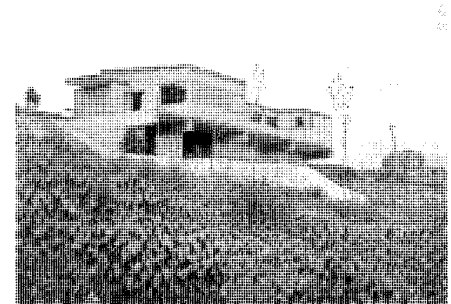
Vista de conjunto.
