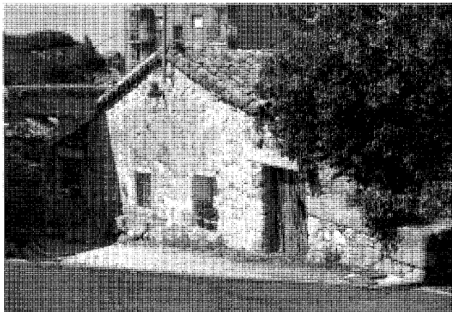
Casón de la avenida de José Antonio, 8 c/v calle Anacleto López. Fot. José Rodríguez Ablanedo.
