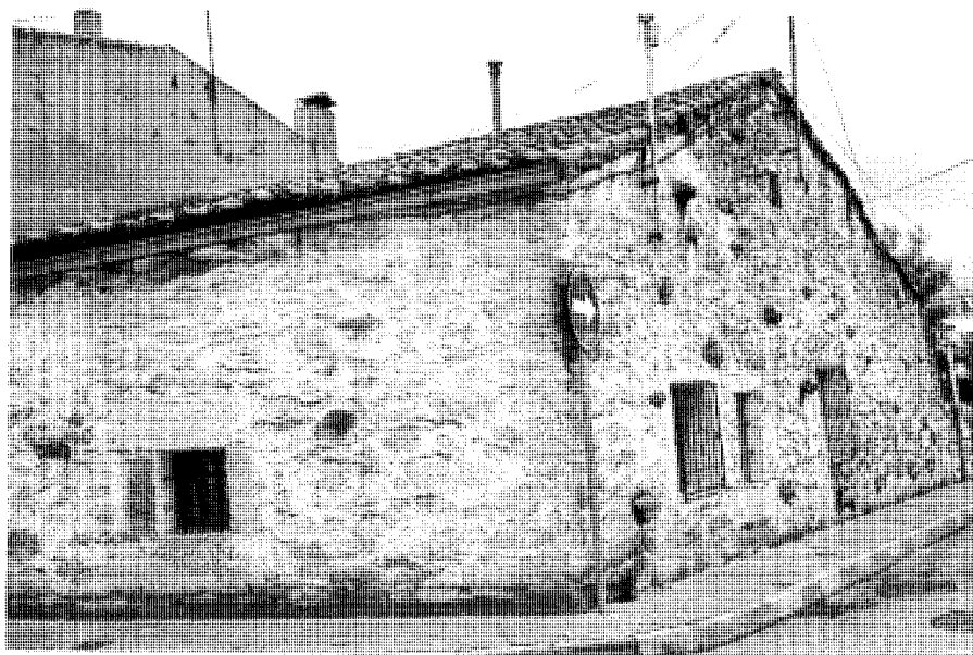
Vivienda en la calle Rosales c/v a la del Barrio de Arriba. Fot. Pilar Martín-Serrano.
