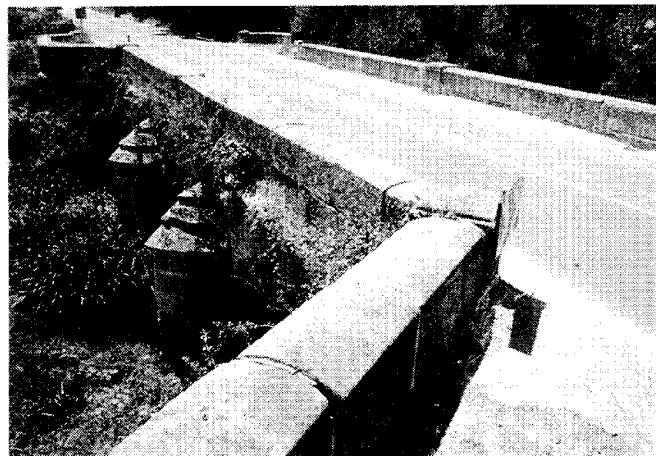
Detalle de uno de los ensachamientos en tambor. Inventario del medio rural de la Comunidad de Madrid.
