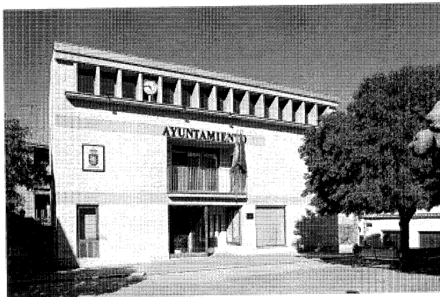
Vista general del edificio. Fot. Actividades y Servicios Fotográficos, S.A.
