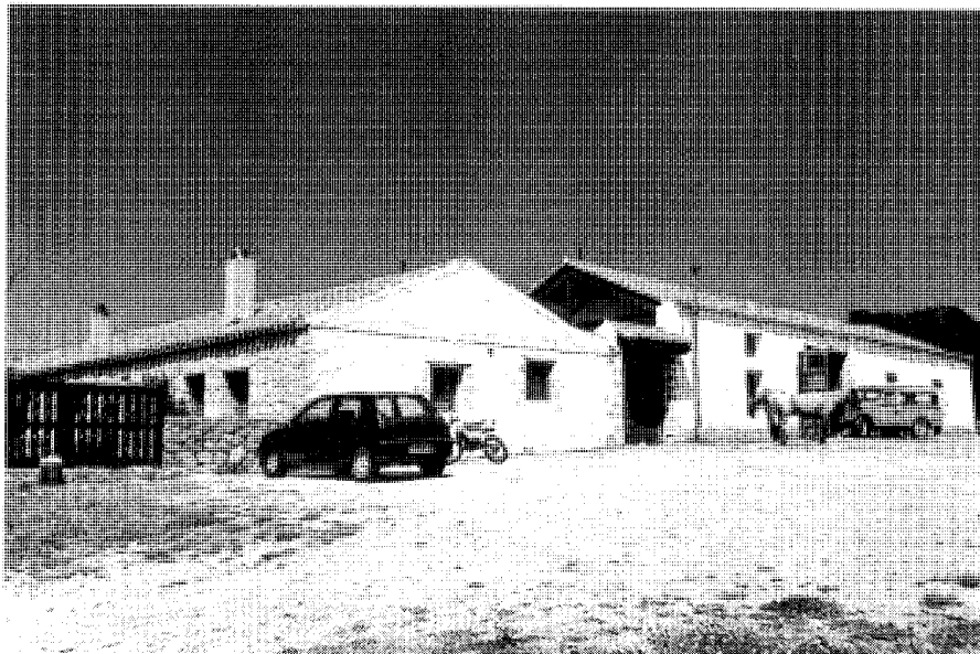
Finca de Media Aldea. Casa de guardas y almacenes. Fot. Alberto Sanz.
