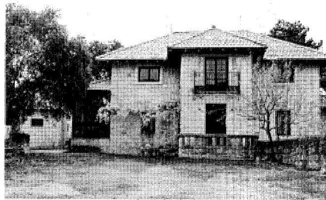
Pabellón auxiliar. Fot. Pilar Martín-Serrano.
