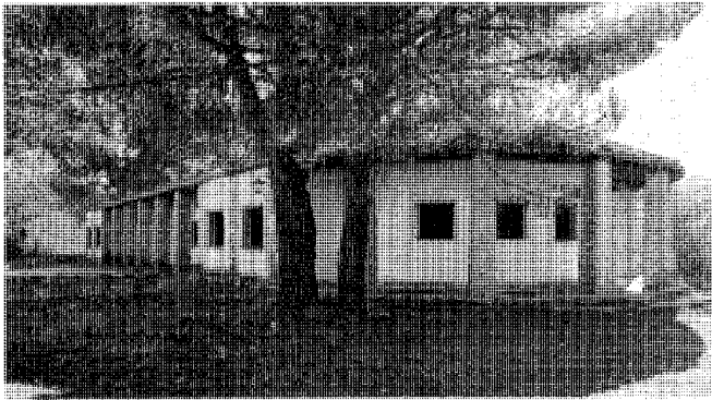
Edificio de Servicios Generales. Fot. Actividades y Servicios Fotográficos, S.A.
