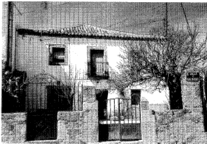
Vivienda en la calle de San Miguel, nºs 2 y 4. Fot. Alberto Sanz.
