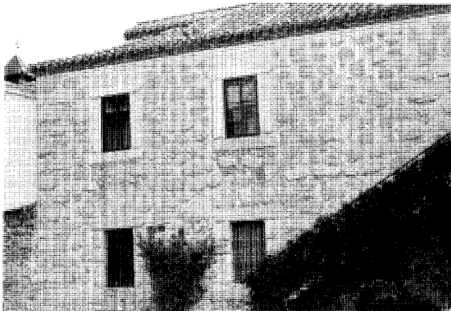
Vivienda urbana en la calle de la Audiencia. Fot. Pilar Martín-Serrano .
