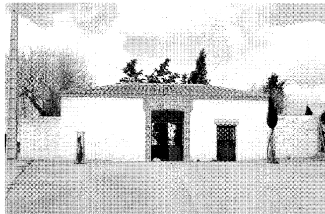
Cementerio. Fot. Actividades y Servicios Fotográficos, S.A.
