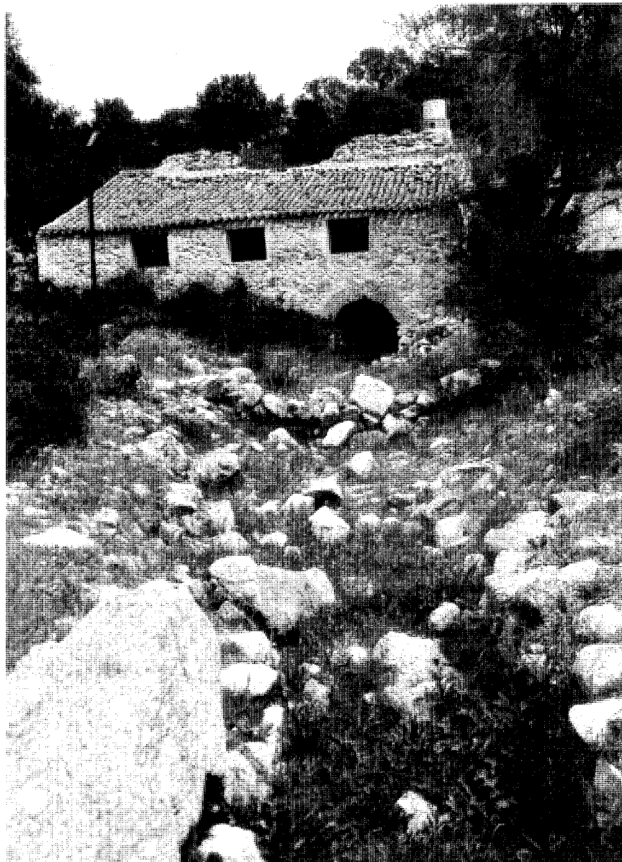
Molino de Navacerrada. Vista general. Fot. Alberto Sanz.
