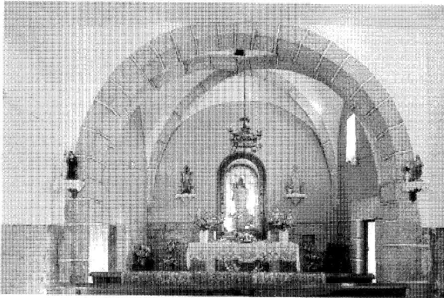
Ermita de San Miguel. Bóveda de crucería del presbiterio. Fot. Actividades y Servicios Fotográficos, S.A.
