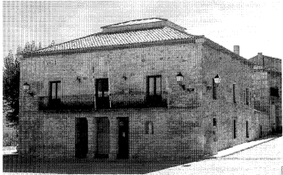
Vista frontal. Fto. Actividades y Servicios Fotográficos S.A.
