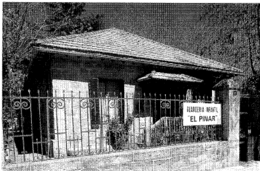
Calle Real n ° 31. Fot. José Rodríguez Ablanedo.
