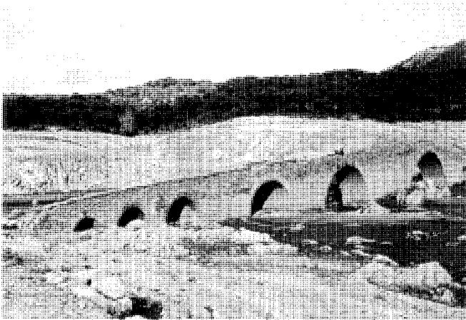
Vista general aguas abajo. Fot. Alberto Sanz.
