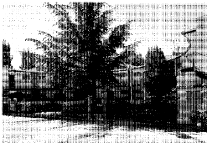
Fachada al jardín de los apartamentos en el "Chavela Club", 1964. Arquitecto: Guillermo Cabezas Conde. Fot: Actividades y Servicios Fotográficos S.A.
