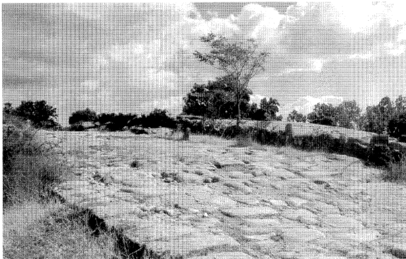
Tramo meridional. Detalle del enlosado. Fot: Actividades y Servicios Fotográficos S.A.
