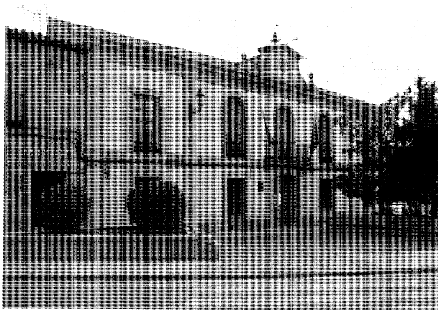
Ayuntamiento. Fot. José Rodríguez Ablanedo.
