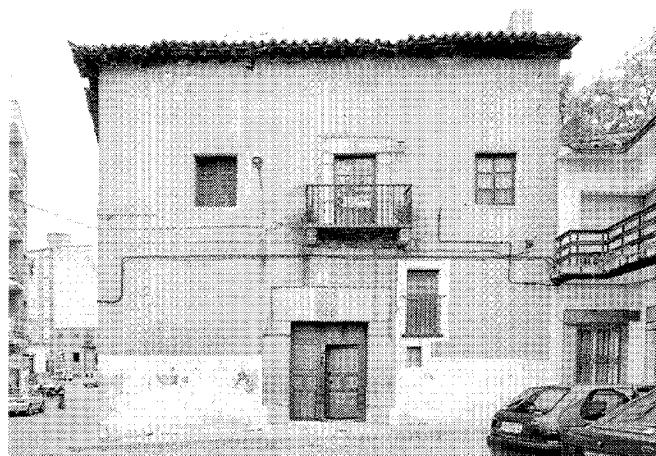
Vivienda en calle Ramón y Cajal, nº 24 c/v pza. del Rucero y calle Dr. Romero. Fot: Actividades y Servicios Fotográficos S.A.
