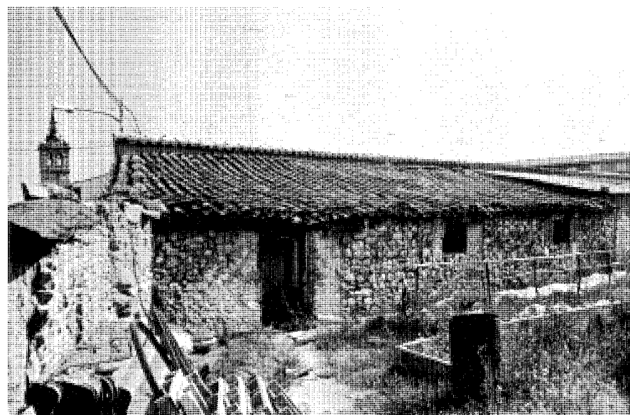
Dependencia en carretera del Palomar. Fot. Virginia Torres.
