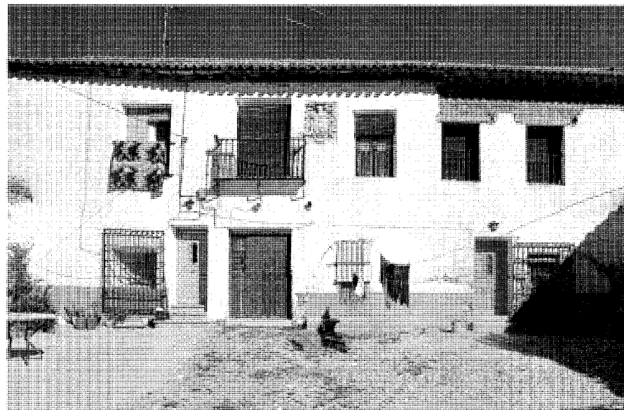
Fachada principal de la Casa del Señor. Fot: Actividades y Servicios Fotográficos S.A.
