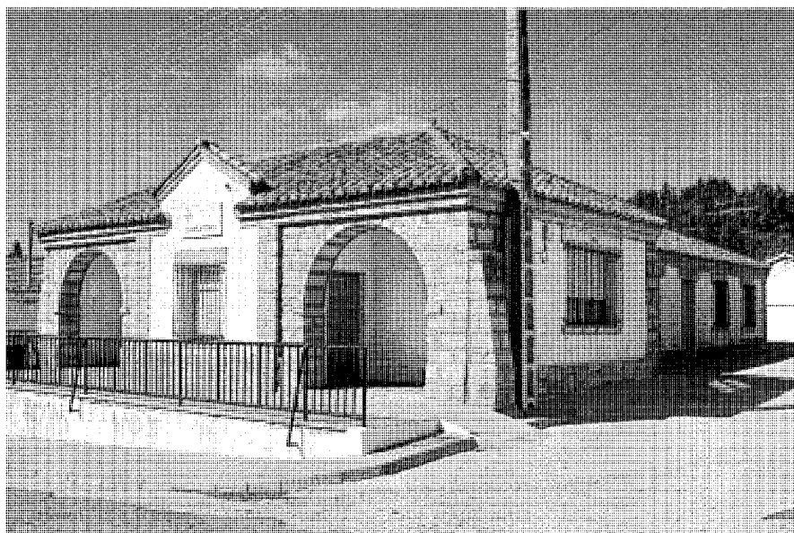
Consultorio (Antigua Clínica Municipal), en calle Antonio Machado, 39. Bautista. Fot. Actividades y Servicios Fotográficos S.A.
