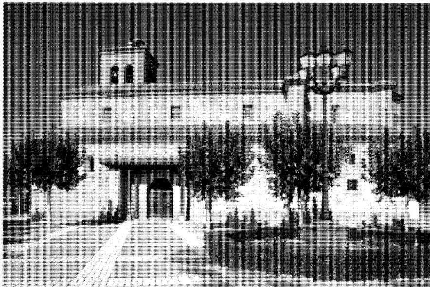
Fachada sur. Fot. Actividades y Servicios Fotográficos S.A.
