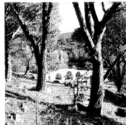
Entorno del puente romano. Foto DGAV.
