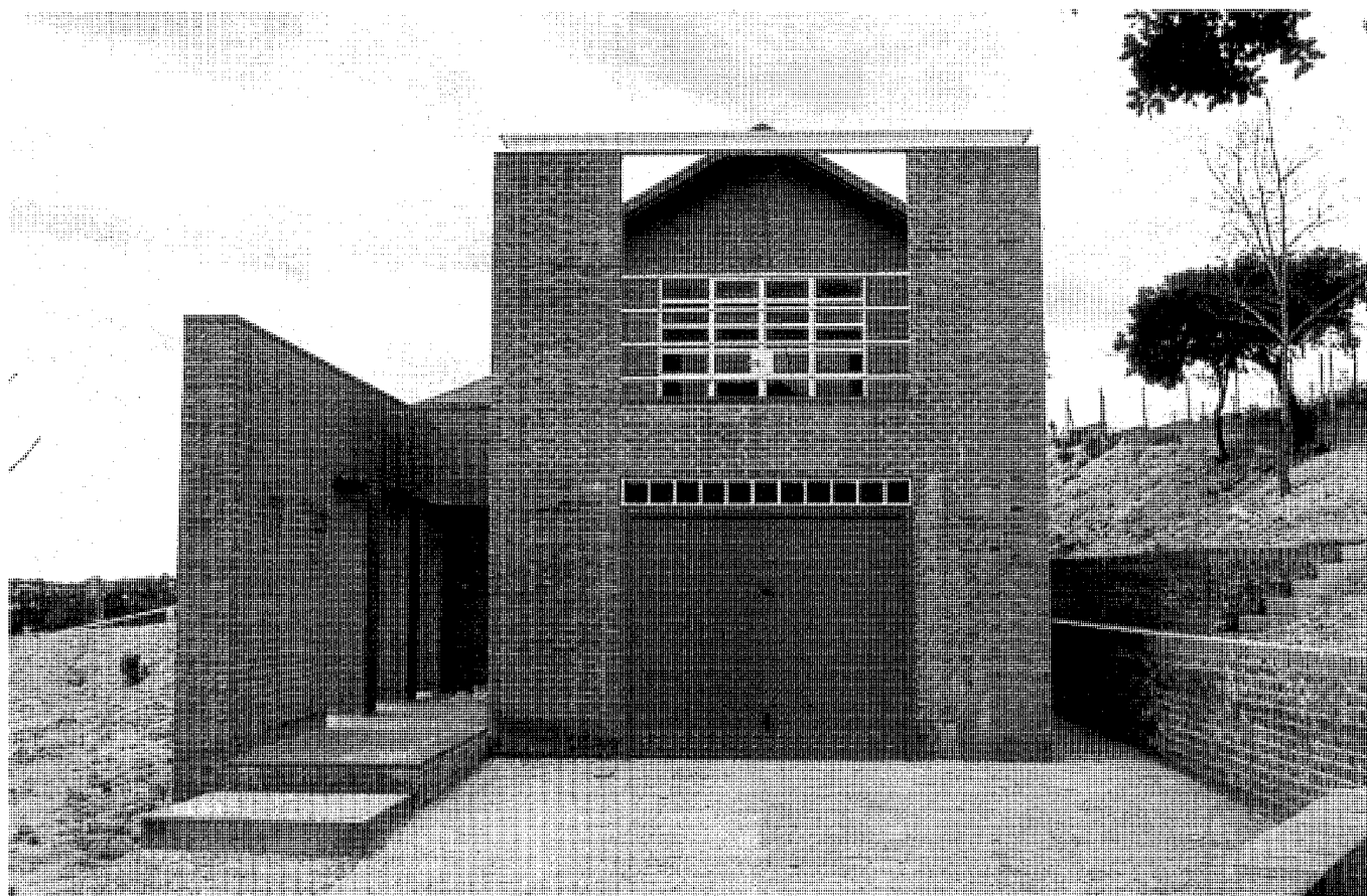
Vista Fachada norte. Foto cedida por el autor.
