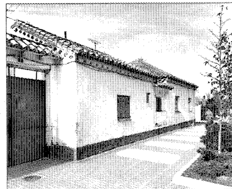
Viviendas de labrador. Estado actual.
