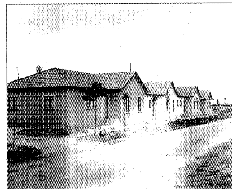
Viviendas prefabricadas de renta reducida. A.G.A. Regiones Devastadas.
