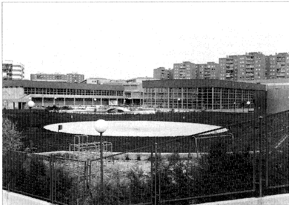
Piscina cubierta y pista polideportiva.
