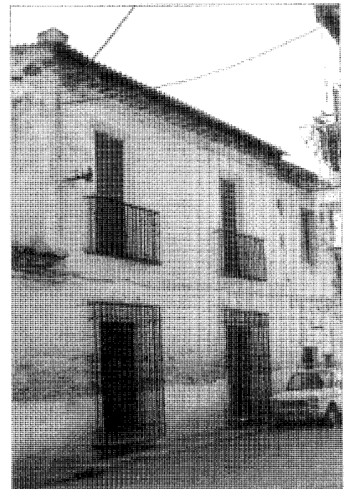
Fachada. Calle Nueva.
