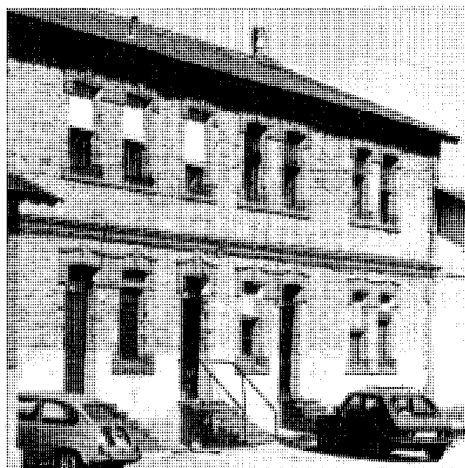
Fachada principal a la Plaza de una de las dos agrupaciones de bloques de una y dos plantas.
