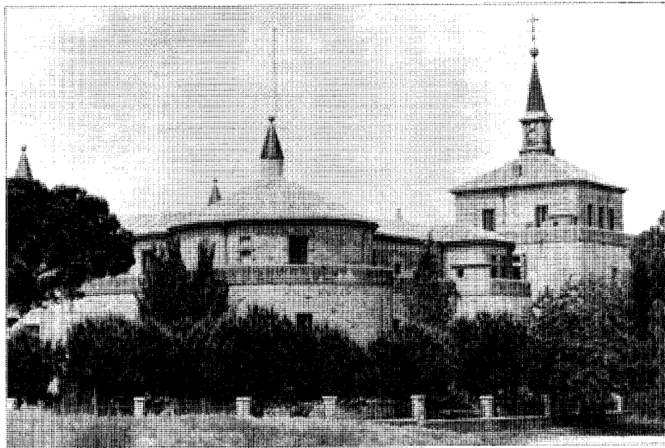
Exterior con la torre del homenaje al fondo.
