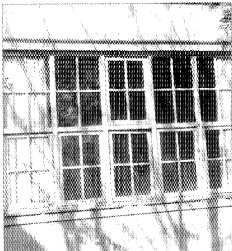
Detalle de la fachada de la Galería de Hombres.
