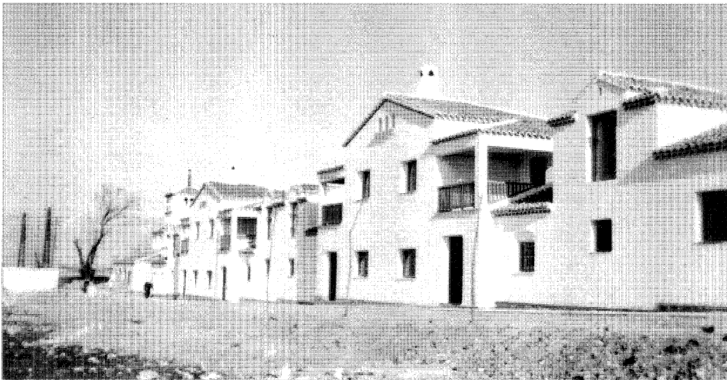
Viviendas de renta reducida en la carretera de La Coruña (derribadas). A.G.A. Regiones Devastadas.
