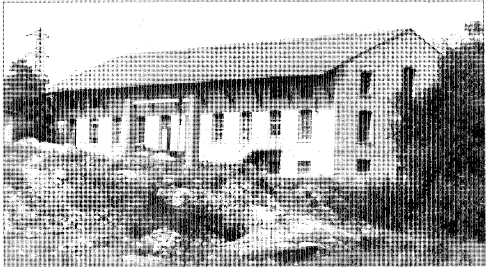
Central elevadora del canal de Santillana.
