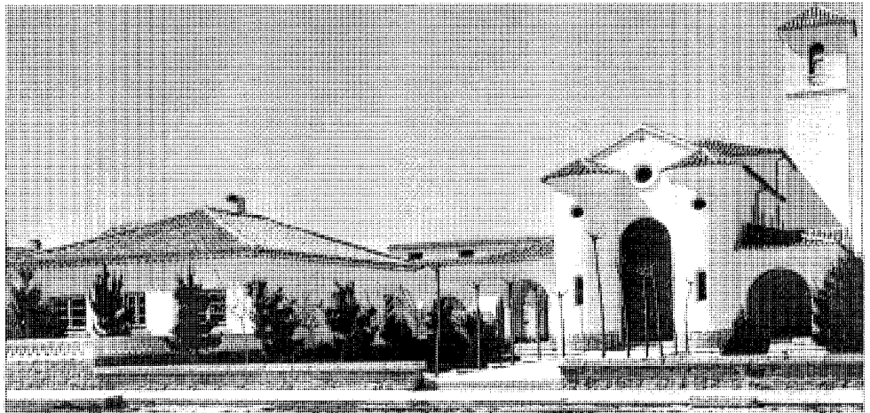
Fachada principal. A.G.A. Regiones Devastadas.
