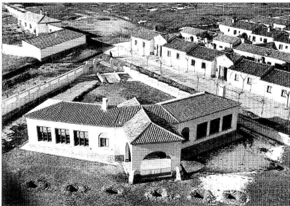
Fachada posterior. Estado original. A.G.A. Regiones Devastadas.
