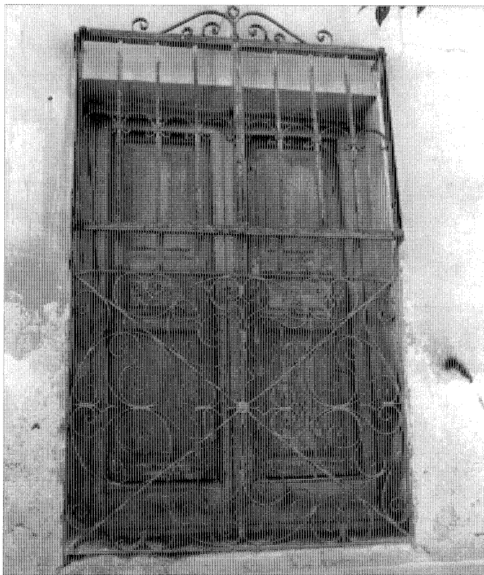
Vivienda. Plaza Canto Redondo, 6. Detalle ventana.
