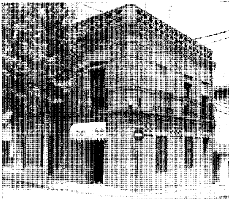
Vista general desde la confluencia de las calles Eras y Núñez Arenas.
