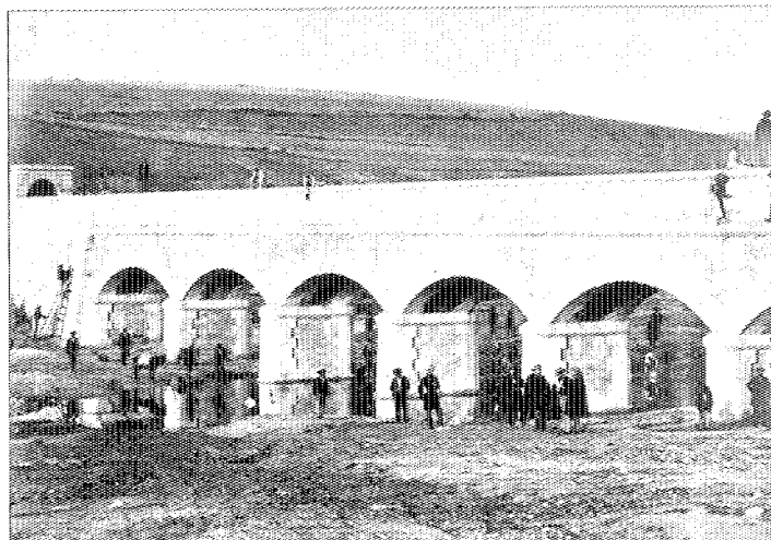
Puente acueducto de la Parrilla. Clifford. Canal de Isabel II.
