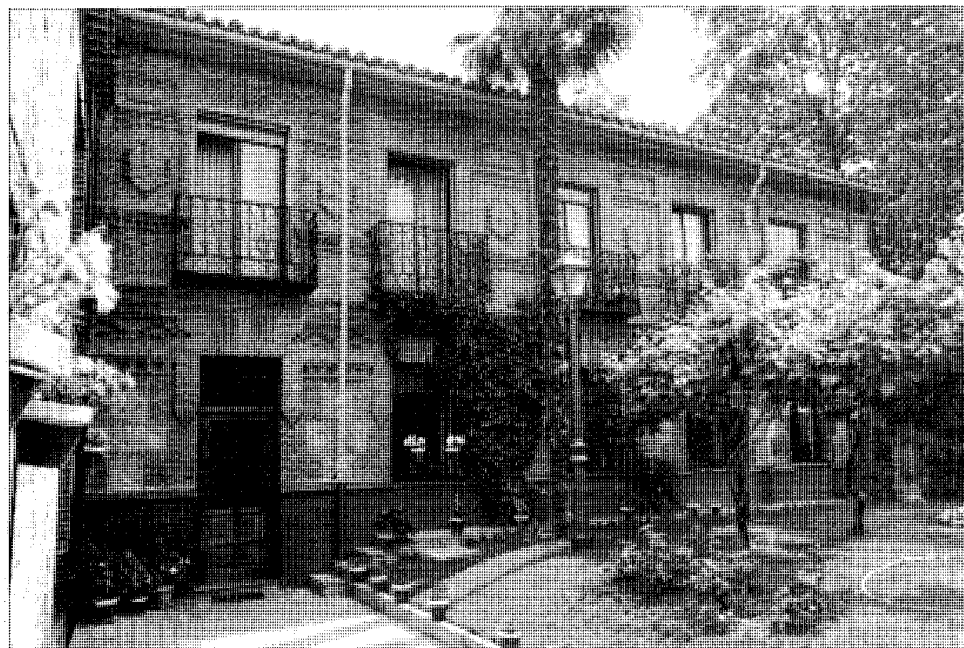
Edificio principal con jardín antepuesto. Estado actual.
