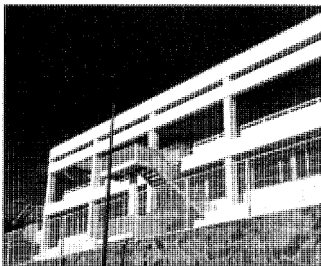
Detalle de fachada y escalera de incendios.
