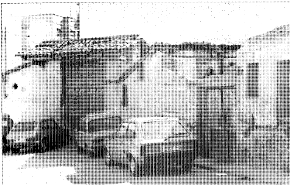
Detalle de accesos a viviendas rurales.
