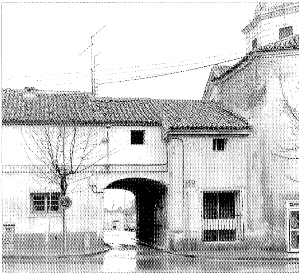
Casona adosada a la Iglesia de la Natividad.
