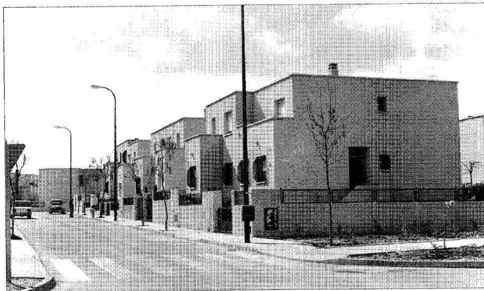
Cooperativa Rosa de Luxemburgo. Vista de conjunto. M. López Tolosa y F. González de la Blanca. 1981.
