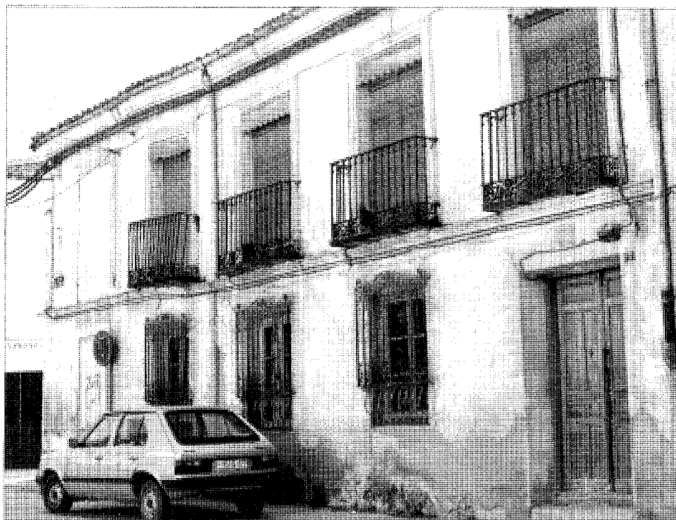
Vivienda. Calle Monjas, 3.
