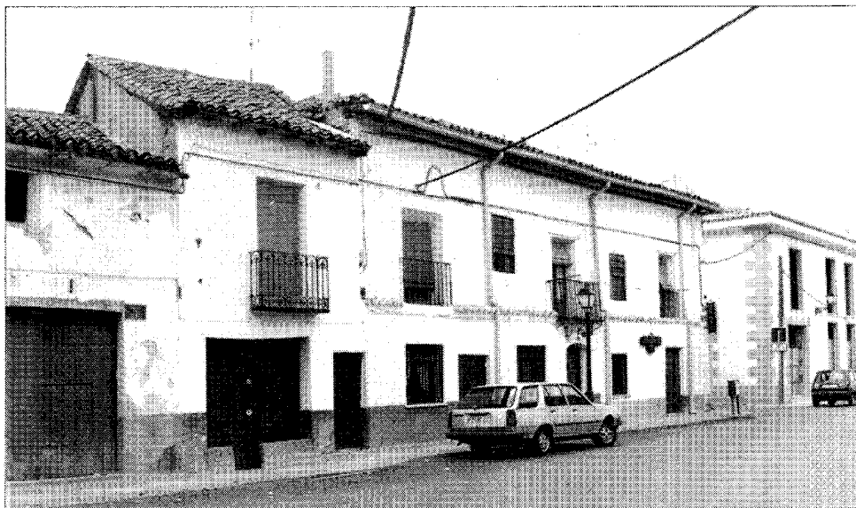
Calle del Puente, 2 y 4. Vista general.
