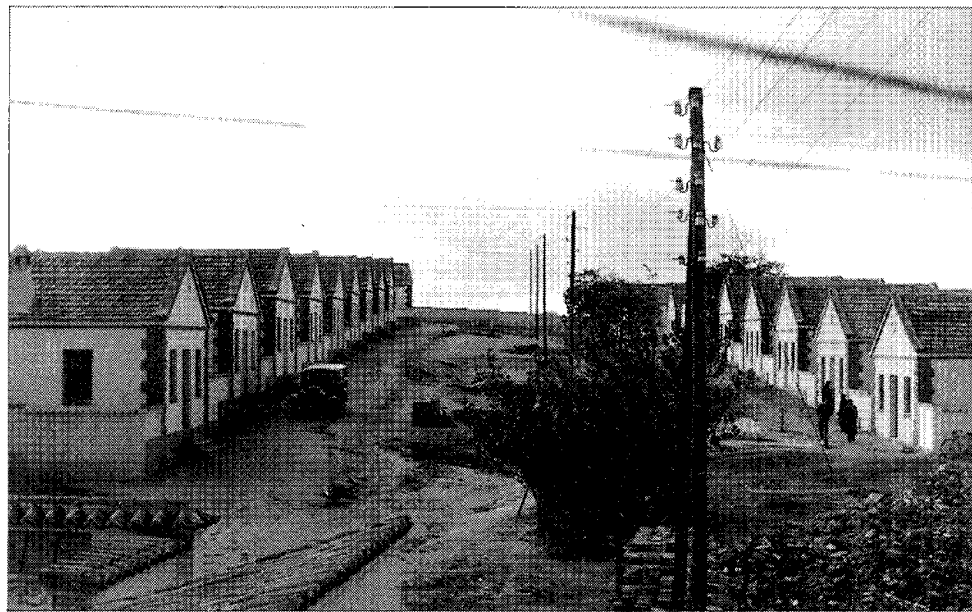
Detalle de las fachadas traseras. Estado tras la reconstrucción. A.G.A. Regiones Devastadas.
