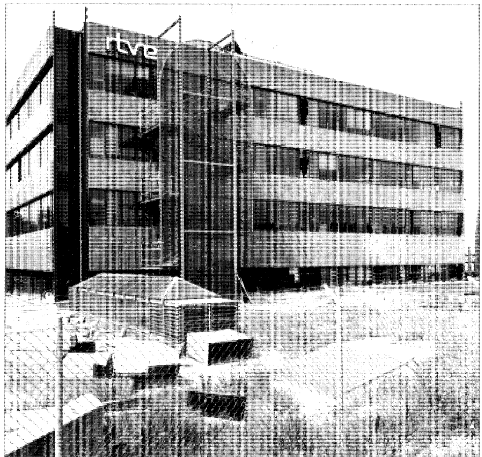
Vista del edificio.
