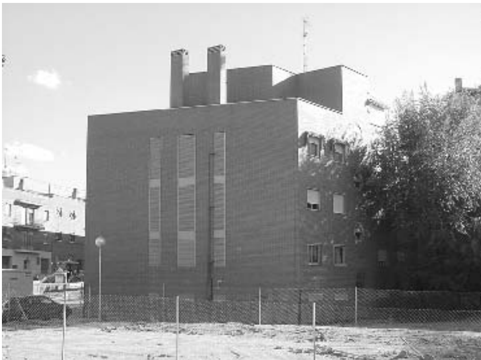
Vista general del edificio.
