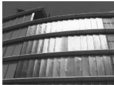
Vista de fachada ciega transventilada.
