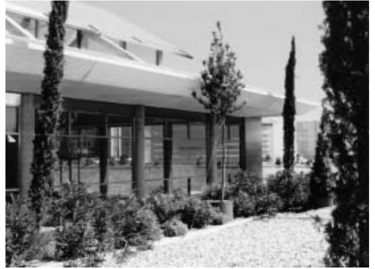
Marquesinas y terrazas de protección solar.
