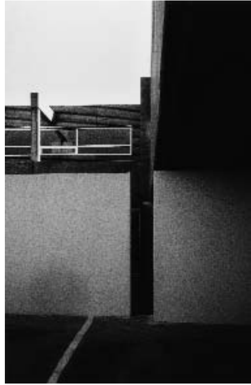
Detalle muro separador aparcamiento-acceso
