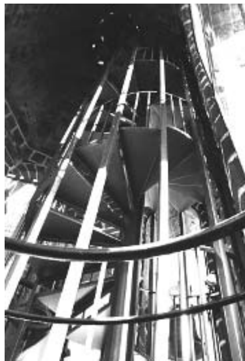
Vista general de la escalera.
