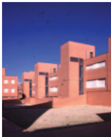
Vista S del patio interior.
