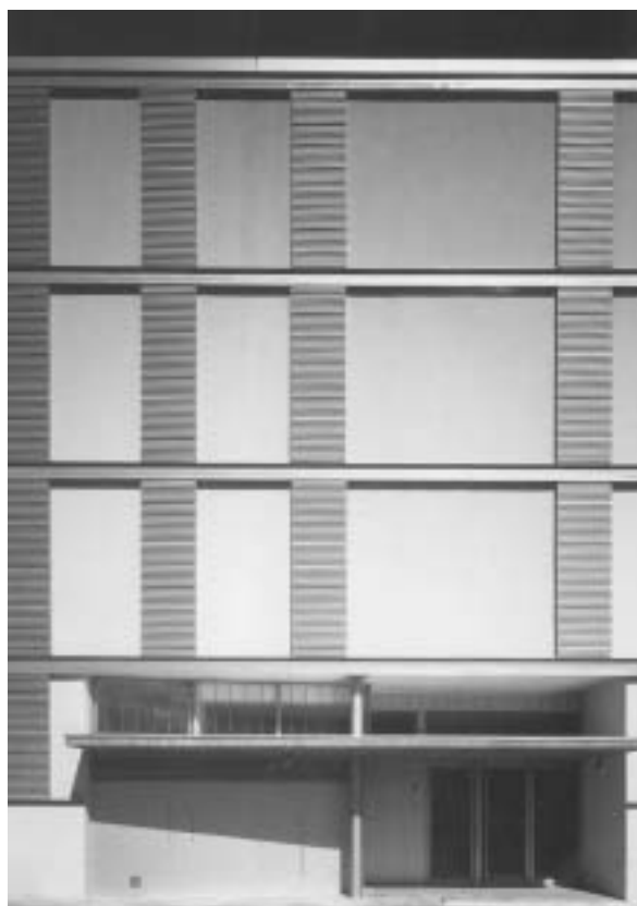
Vista O del portal.
