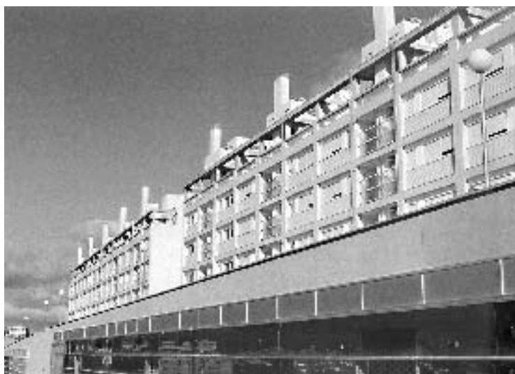
Vista S desde la calle.
