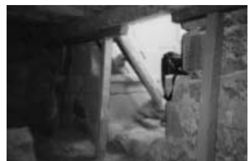
Escalera de acceso a reloj en hueco de ventana.
