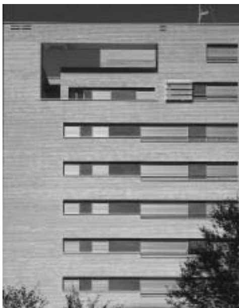
Vista de los huecos en fachadas.
