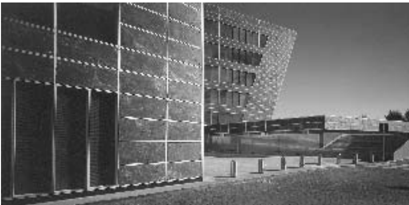
Vista del acceso general al edificio.
