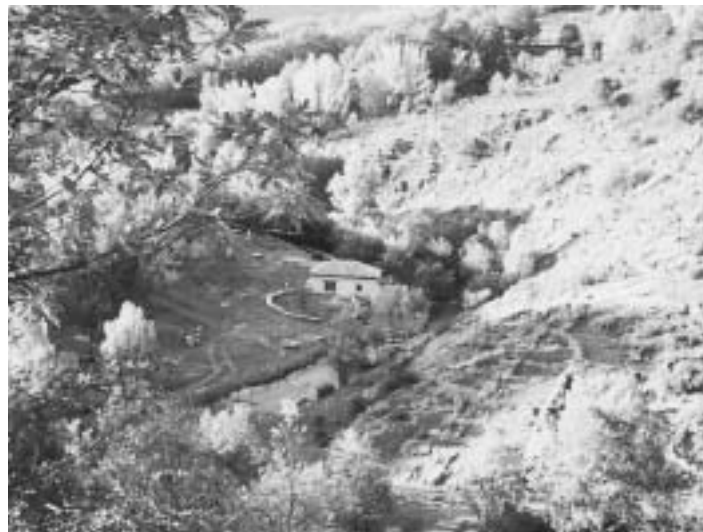
Vista general del molino y su entorno.
