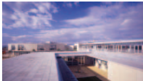
Vista desde la cubierta del pabellón cuadrado.
