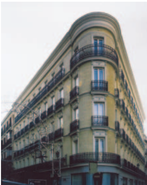
Vista principal del edificio
