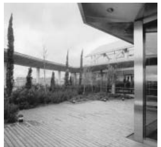
Vista de terraza aislante ajardinada.
