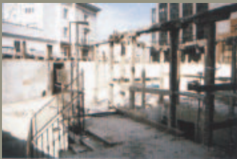
Rehabilitación del Hotel Preciados. Premio a los oficios 2003
