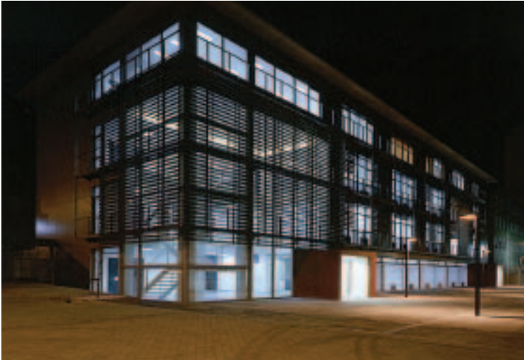
Vista SO del edificio administrativo.
