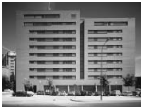
Vista de la fachada principal.
