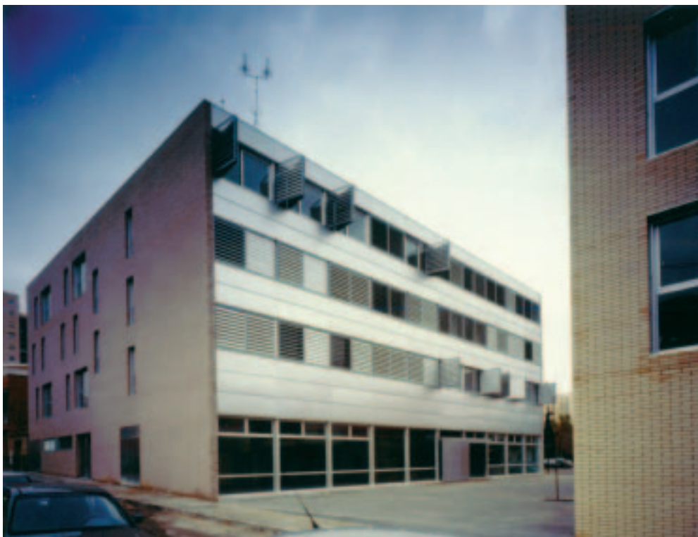
Vista SE del edificio.
