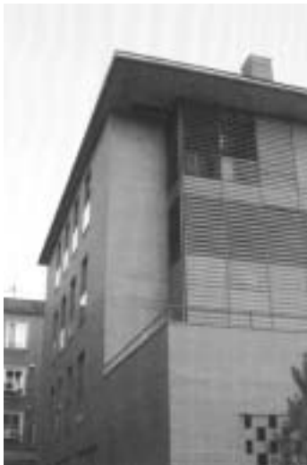
Detalle fachada a M-30.
