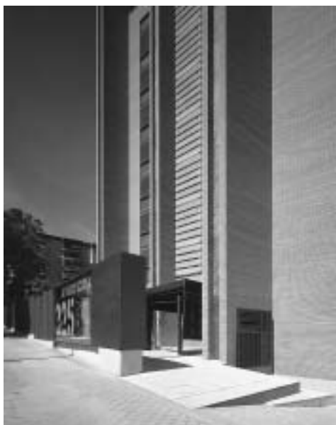
Vista del acceso al edificio.
