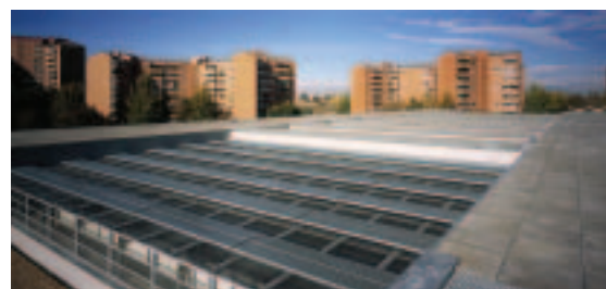
Vista de los lucernarios de cubierta.
