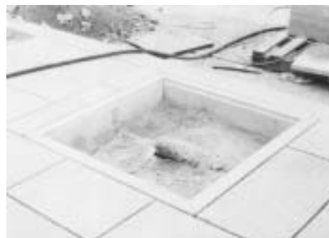
Detalle de alcorque y solado de granito.
