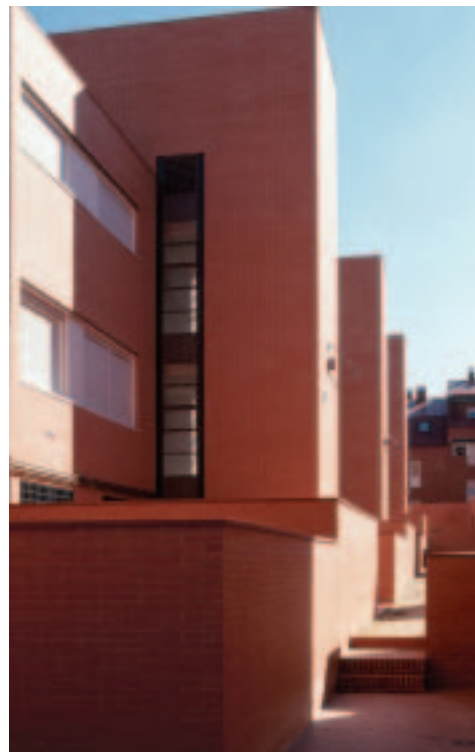
Vista desde el acceso por la Calle Pinos Baja.
