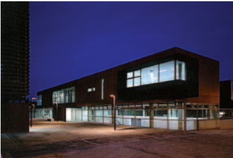
Vista NO del centro de la 3ª edad.
