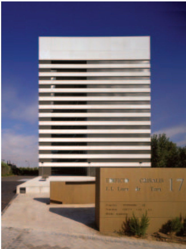
Vista fachada sur
