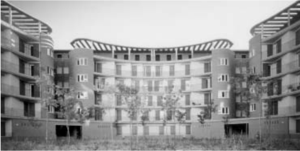
Vista general del patio de manzana.
