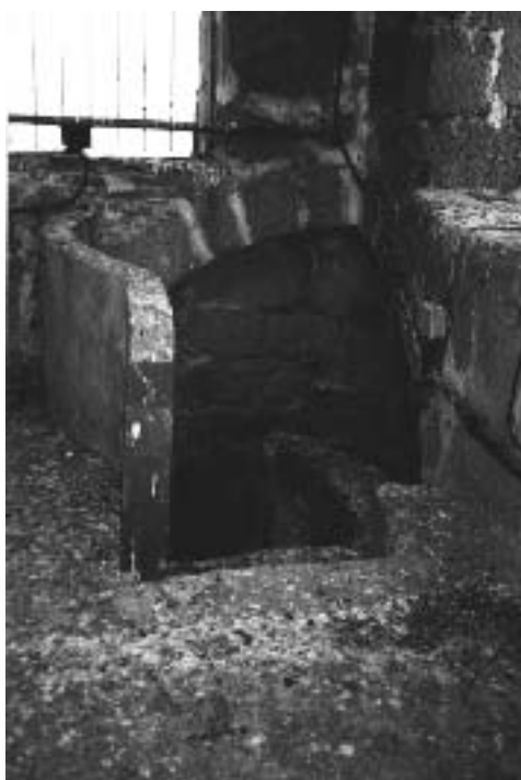
Vista de las escaleras de piedra antes de las obras.
