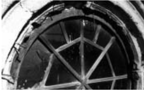
Detalle del rosetón durante las obras.
