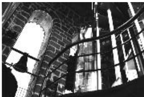
Vista de la barandilla después de las obras.
