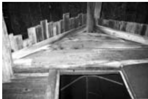
Detalle de la caseta del reloj. Estado inicial.
