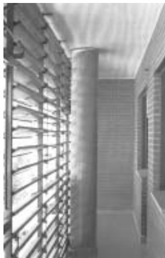
Vista interior de la galería.
