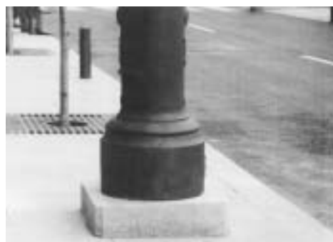
Detalle de la basa de granito para apoyo de la farola.
