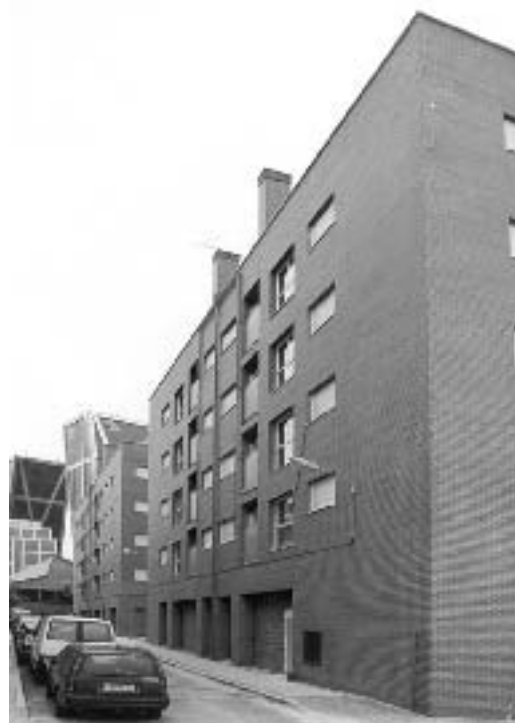
Vista de la fachada N.
