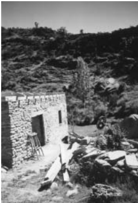
Vista del molino en fase de las obras.
