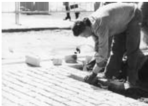
Colocación de adoquines de granito gris en la Plaza de la Villa.
