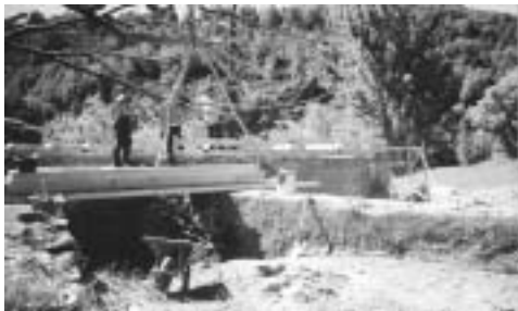
Obras en el caz del molino.
