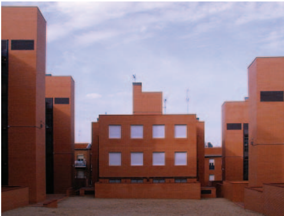
Vista SE del patio interior.
