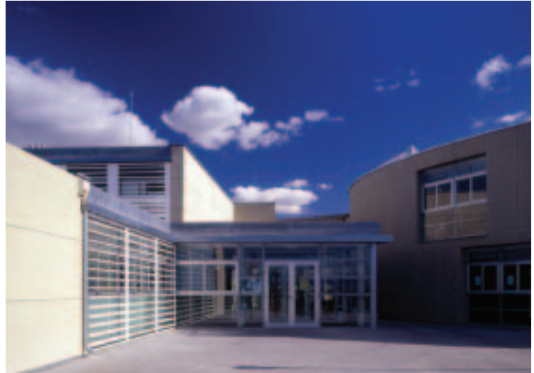
Vista del acceso.
