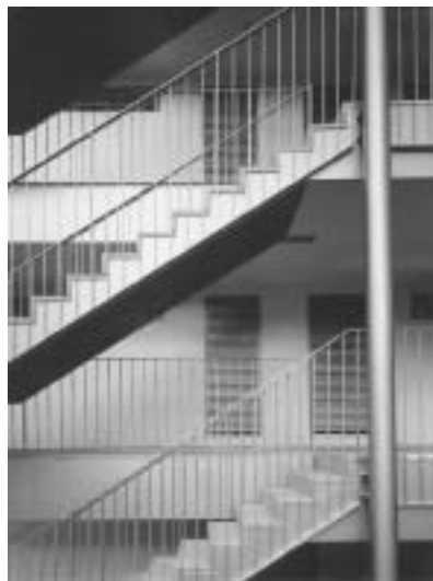
Vista de la escalera desde el patio.
