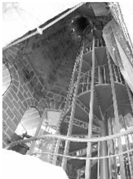
Vista del interior del capitel después de las obras.
