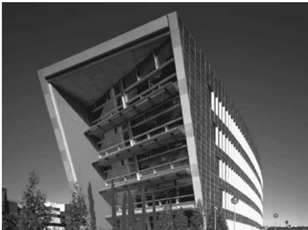
Vista fachada S.
