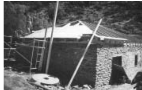
Rehabilitación de la cubierta.
