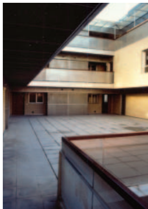
Vista del patio interior
