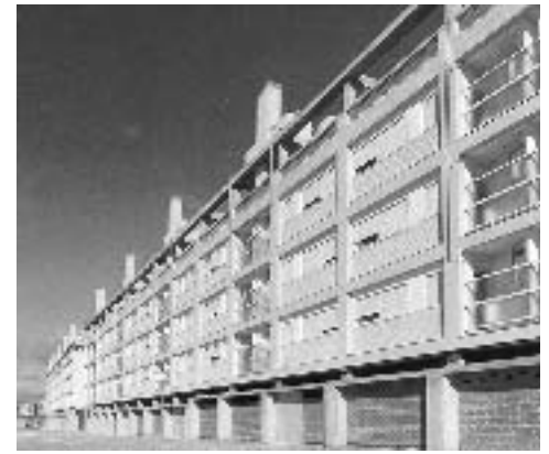
Vista S desde la entreplanta.
