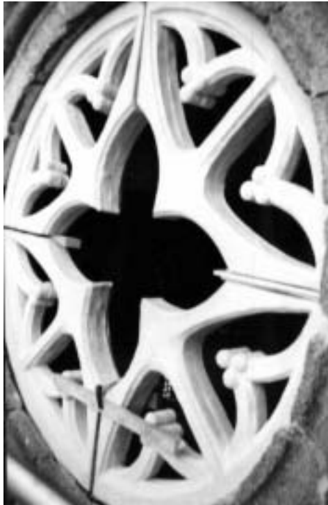
Vista del rosetón después de la restauración.
