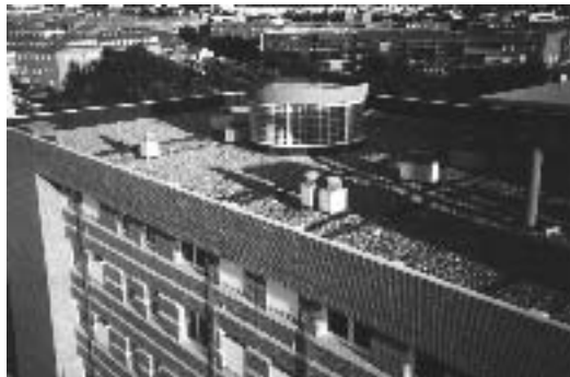
Vista general de cubiertas.
