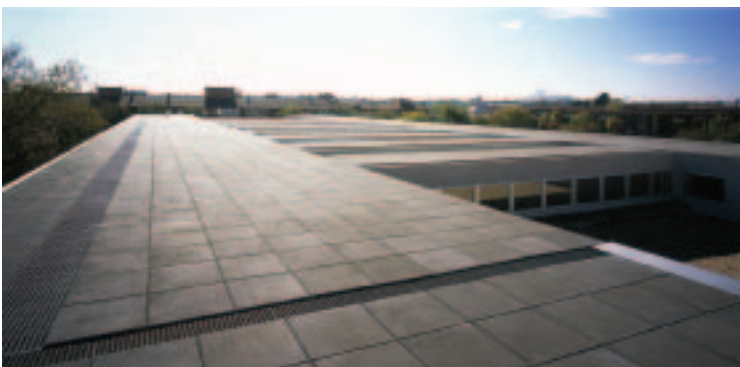
Vista de la cubierta de la sala de lectura
