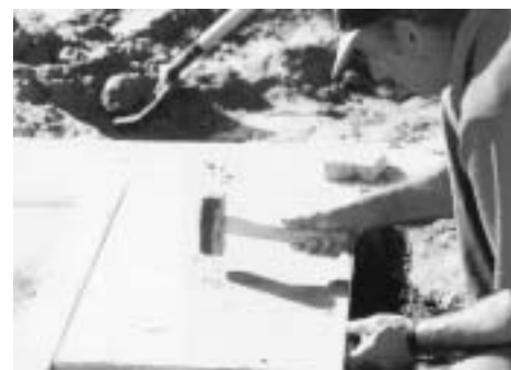
Colocación de losas de granito y banda perimetral del alcorque.
