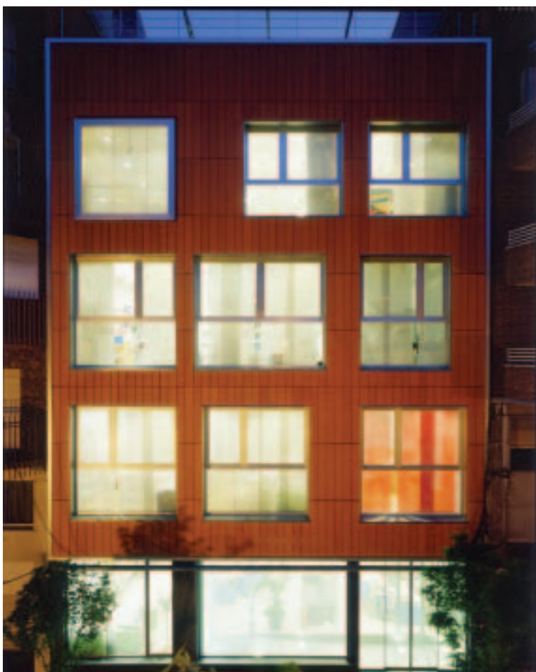
Vista principal del edificio
