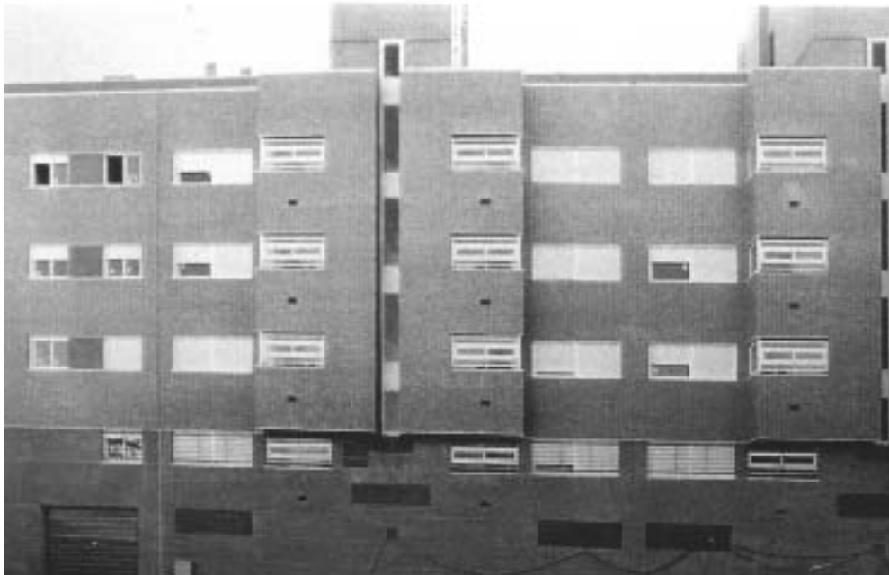
Vista general del edificio.
