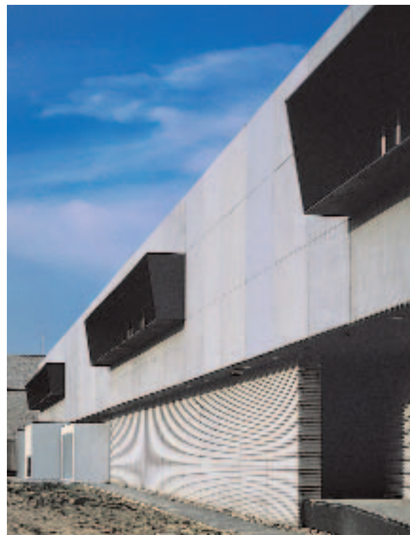
Huecos en fachada sur
