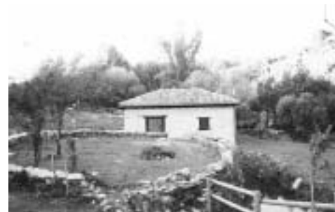
Vista general del molino, huerto, muro de contención y caz. Estado final.
