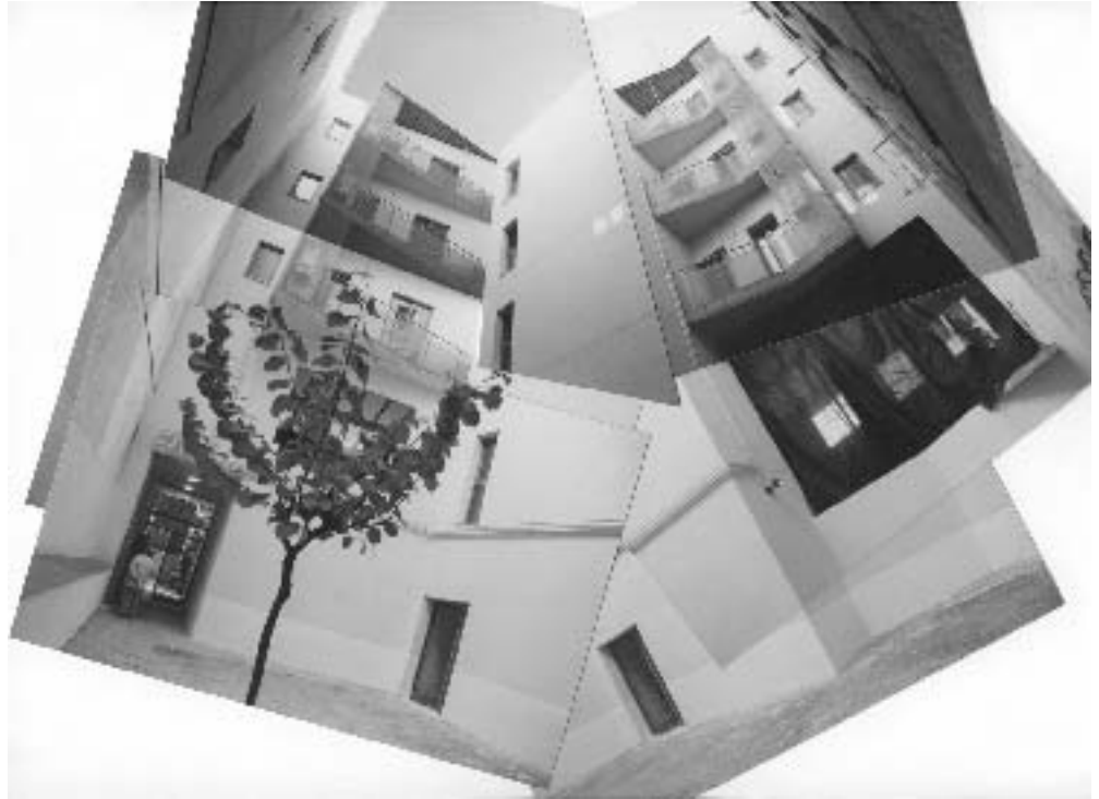
Vista del patio interior.
