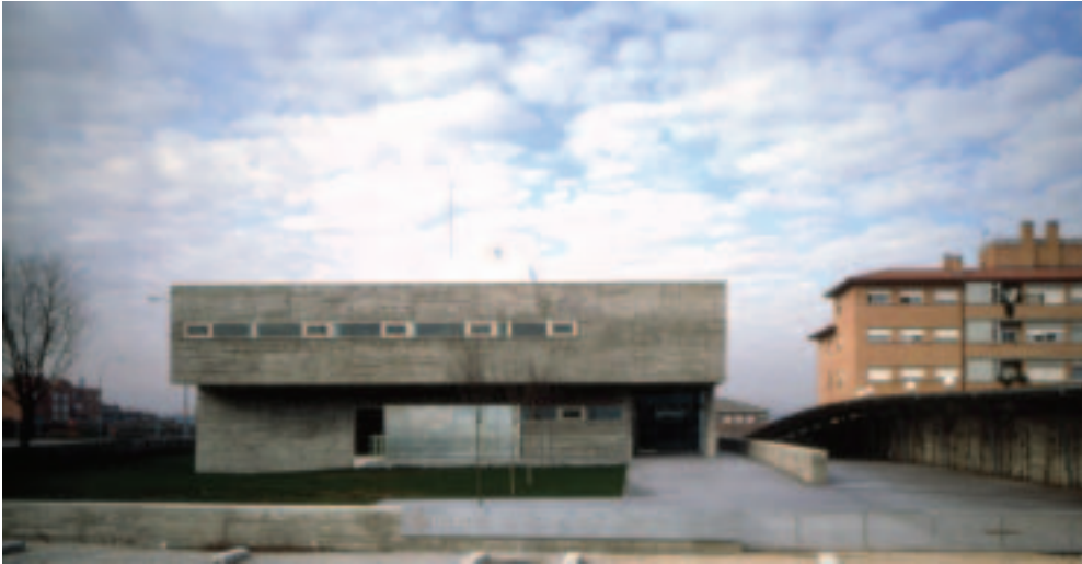
Vista del acceso
