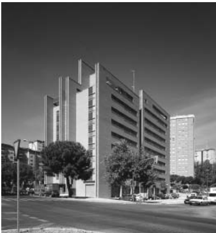
Vista general del edificio.
