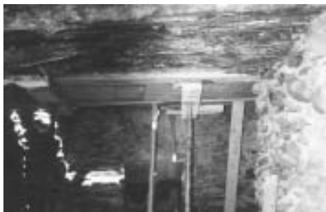
Desarrollo de las obras. Vista del interior del molino.
