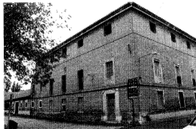
Vista del edificio antes de la reforma hacia la c/ Príncipe c/v Gobernador. Foto M. Lasso de la Vega.
