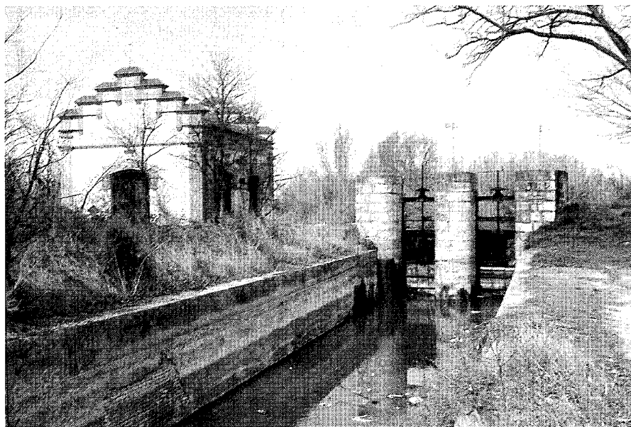
Toma del canal junto a la presa del Embocador. Foto Actividades y Servicios Fotográficos, 2003.
