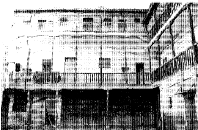
Vista del patio de la casa del Marqués de Bedmar antes de su reconstrucción, c/ Rey, 35. Foto M. Lasso de la Vega.
