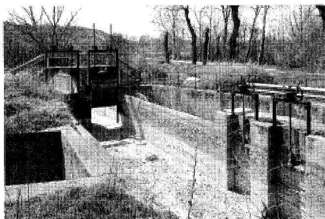
Aliviadero de Valdelascasas. Foto Actividades y Servicios Fotográficos, 2003.
