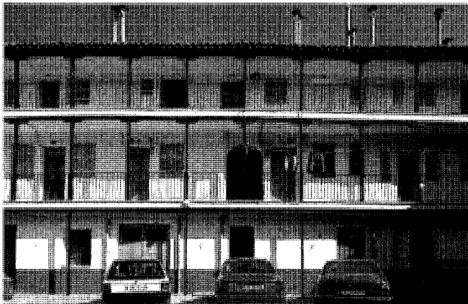
Vista del patio de la casa c/ Carrera de Andalucía, 73.
