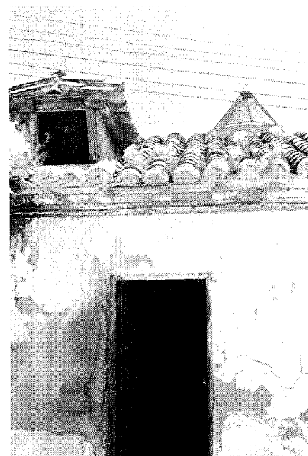
Detalle exterior de cubierta y lucernario. Foto María Cristina García, 2001
