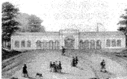
Fachada de la Estación de ferrocarril en 1851. El gran arco central permitía que los ferrocarriles siguiesen por unas vías desmontables hasta Palacio. Dibujo: J. Mieg.
