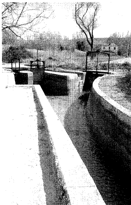
"La Glorieta". Confluencia del canal de la Azuda, caz Chico y caz de la Cola Baja. Foto Actividades y Servicios Fotográficos, 2003.
