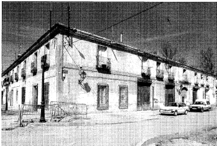
Vista de la fachada principal del palacio hacia la c/ Capitán.
