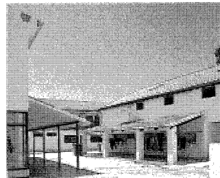
Centro de Integración Social de la Comunidad de Madrid. Vista desde el patio. Actividades y Servicios Fotográficos , 2003.
