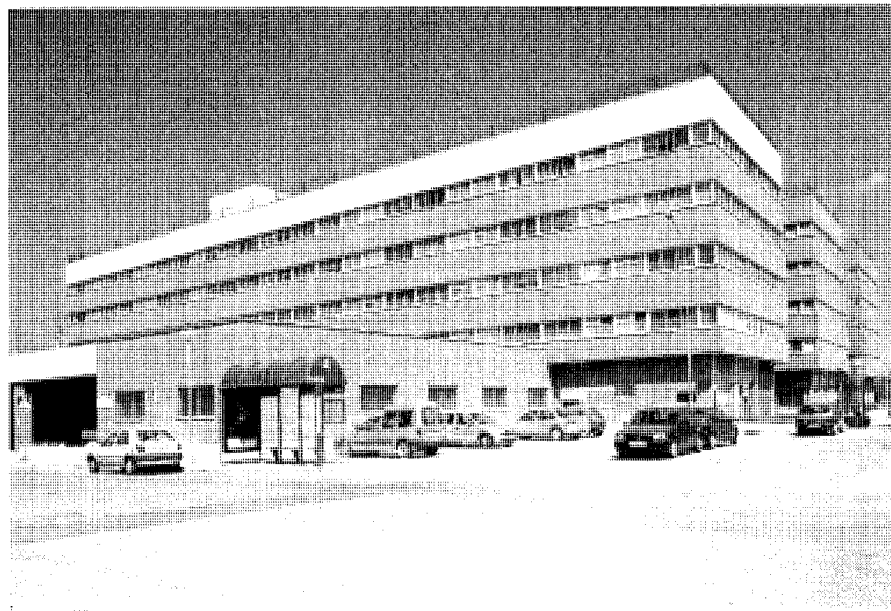
Vista general de la residencia por su fachada principal. Foto Actividades y Servicios Fotográficos, 2003.
