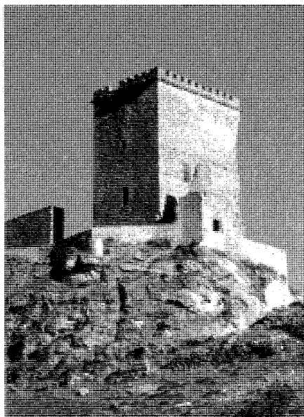
Restos de la antigua fortaleza de Uclés. Castillos y fortalezas de Castilla-La Mancha, 1989.
