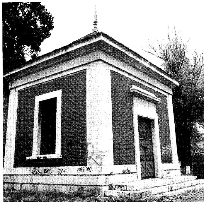
Pabellón de control, 1946. Foto María Cristina García, 2001.
