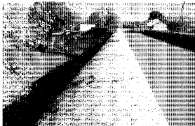
Pretil con el muro de contención y la casa del pontazguero al fondo. Foto Vicente Patón.
