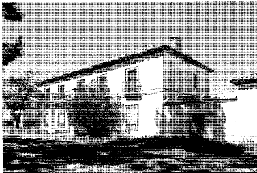
Vista general del edificio principal. Actividades y Servicios Fotográficos, 2003.
