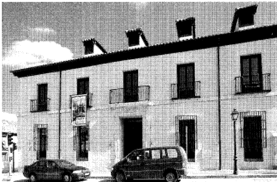
Vista actual de la Casa del Gobernador desde la c/ Almíbar.
