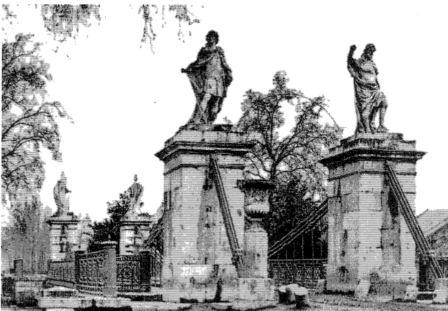
El Puente Colgado a finales del siglo XIX.
