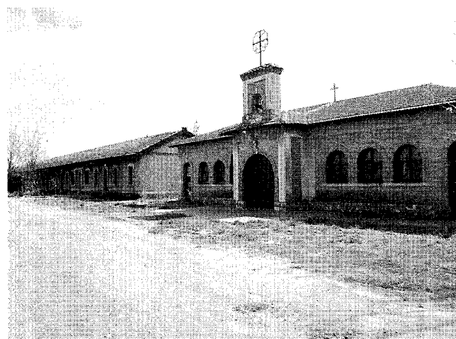
Vistas parciales del poblado ferroviario: viviendas, escuela y capilla. Foto Actividades y Servicios Fotográficos, 2003
