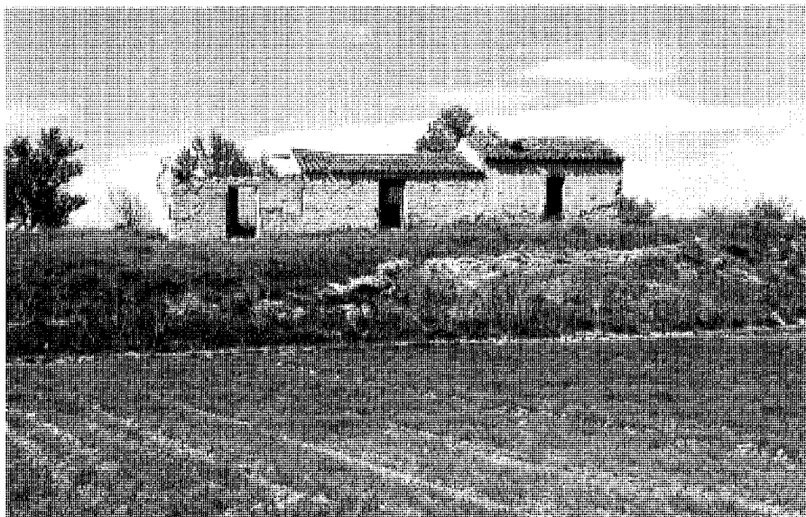
Casillas arruinadas por el término del real Cortijo. Foto Actividades y Servicios Fotográficos.
