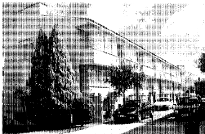
Viviendas adosadas. Alineación de fachadas en una unidad de bloque. Foto cedida por los autores.
