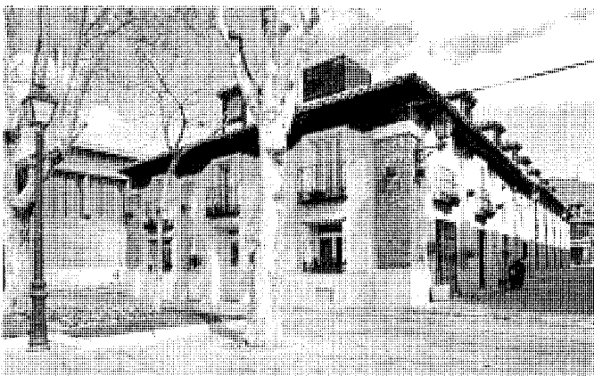
Vista del conjunto antes de la reforma de 1980. SH.COAM.
