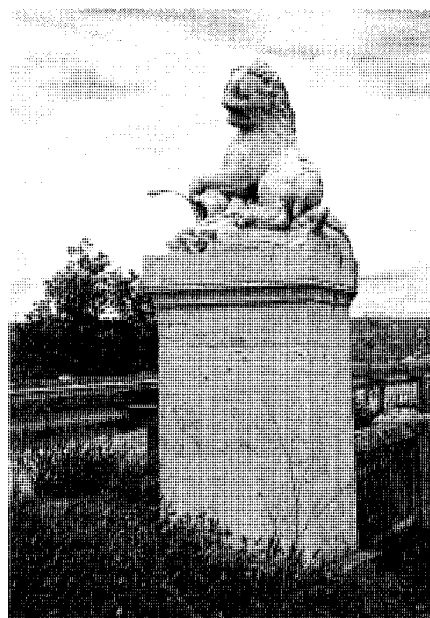
Uno de los leones que señalan los extremos del puente. Foto Actividades y Servicios Fotográficos, 2003.
