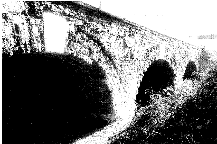
Puente del Pico-Tajo. Vista de conjunto. Foto María Cristina García, 2001.
