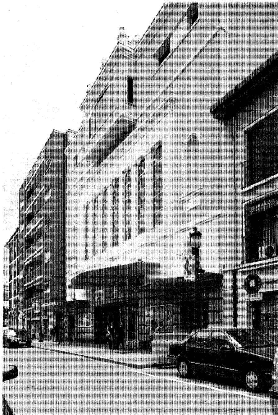
Vista general de la fachada a la calle. Foto Actividades y Servicios Fotográficos , 2003.
