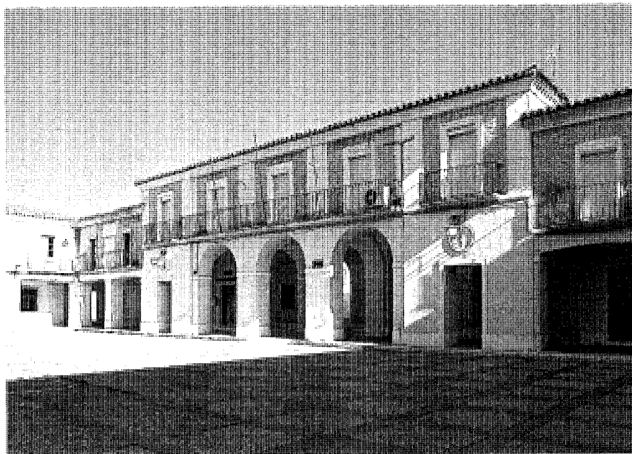
Edificio del Ayuntamiento pedáneo en la plaza mayor. Foto Actividades y Servicios Fotográficos.
