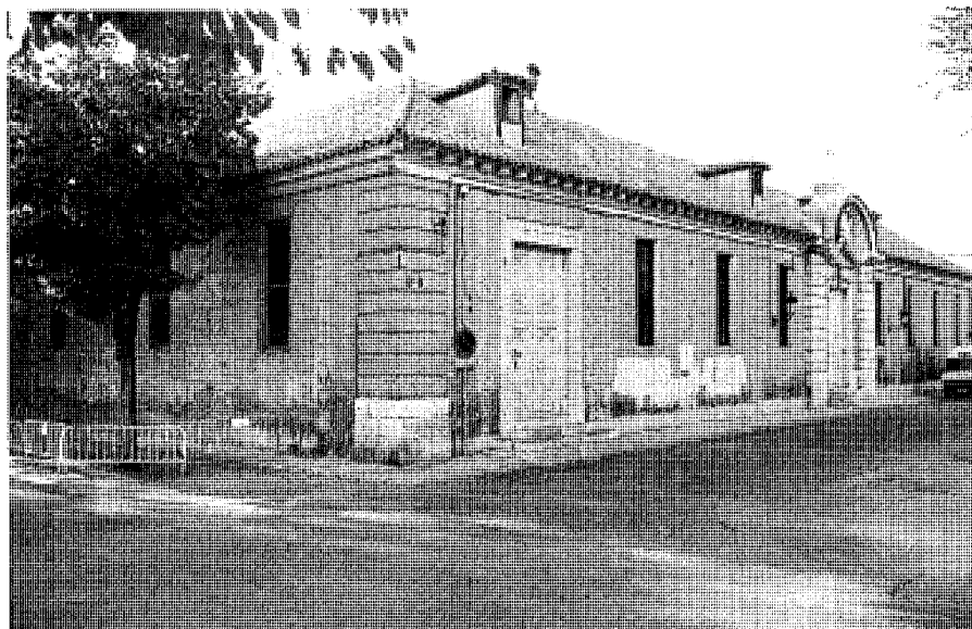
Fachada principal vista desde el sureste. Foto Vicente Patón.
