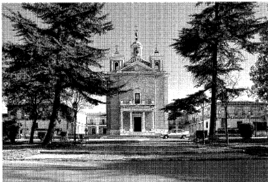
Acceso al Cortijo, con la capilla centrando la plaza mayor. Foto Actividades y Servicios Fotográficos.
