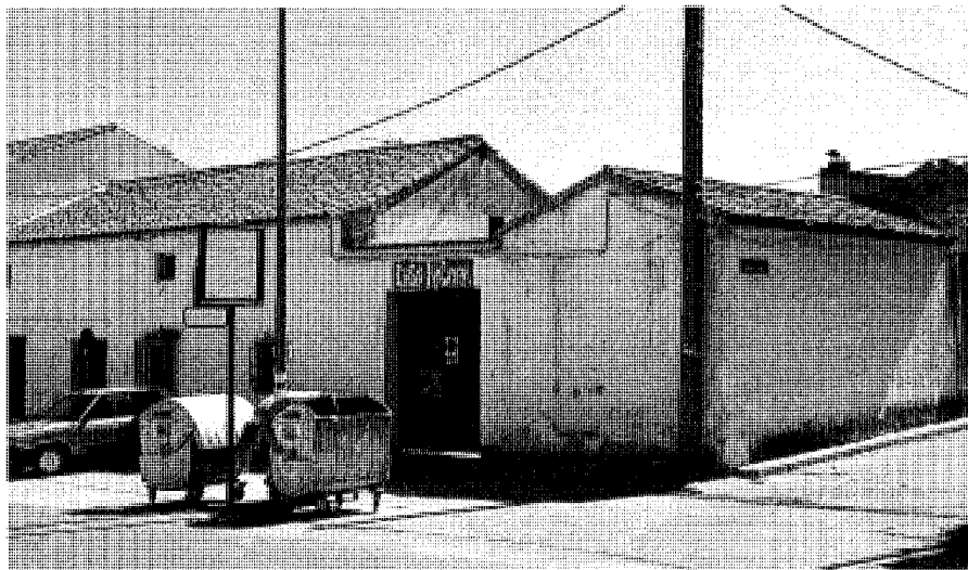
Antigua casa acomodada de la avenida de Madrid c/v calle Toribio Orgaz, recientemente derribada. Fátima García Lledó, 1998.
