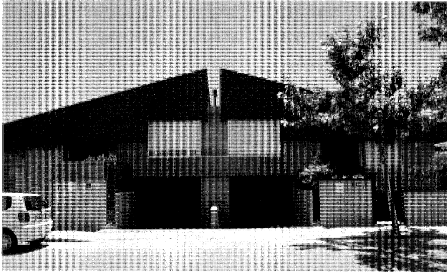
Viviendas pareadas "Las Azaleas". Luis de la Puente, Juan Manuel Echevarría y José Luis Soler, 1993-1994. José Rodríguez Ablanedo, 2000
