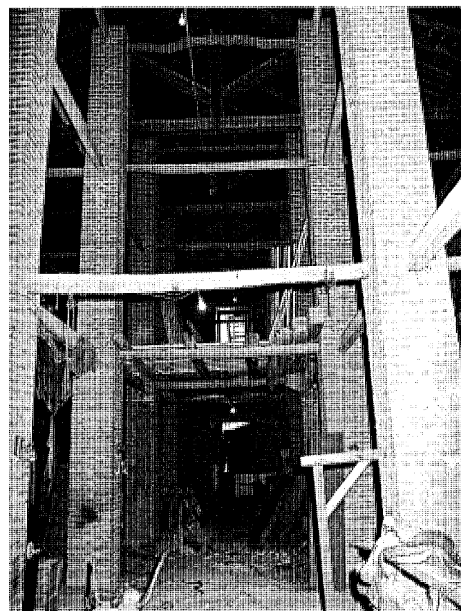
Vista general del almacén y detalle de la estructura interior. Jose Ablanedo, 2000
