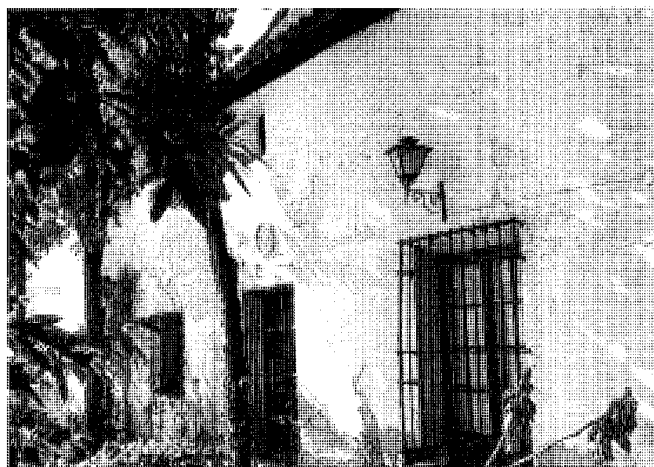
Antiguo convento franciscano. Fachada al jardín. Foto Pilar Martí-Serrano
