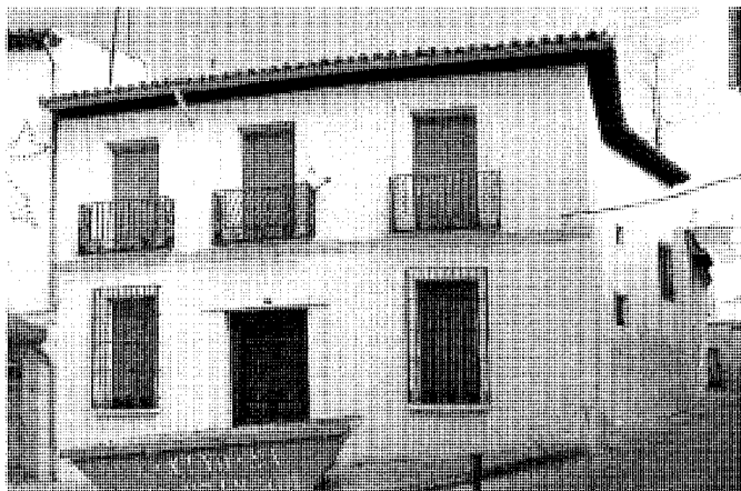
Vivienda en calle de los Silos, 7.
