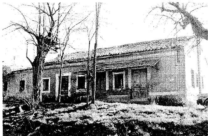
Conjunto agropecuario en Carretera de Campo Real, 6-12, La Poveda. Proyecto de derribo, arquitecto José Luis Sobrón Suanzes, 1980. Archivo COAM.
