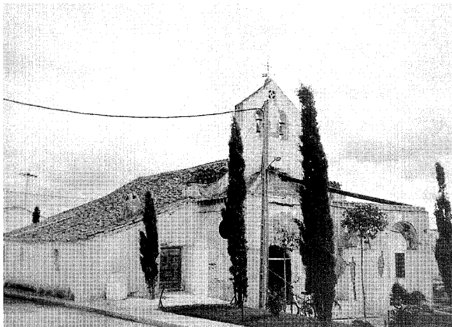
Vista general de la ermita en 1986, antes de su restauración. Información, clasificación y normativa para los cascos antiguos de la zona suroeste del ámbito de la Comunidad Autónoma de Madrid.
