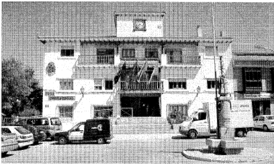
Ayuntamiento y pórtico central de la primitiva Casa de Cultura. José Rodríguez Ablanedo, 2000.
