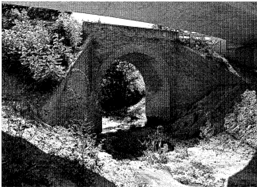
Puente del Sotillo a la entrada del núcleo urbano. José Ablanado, 2000.
