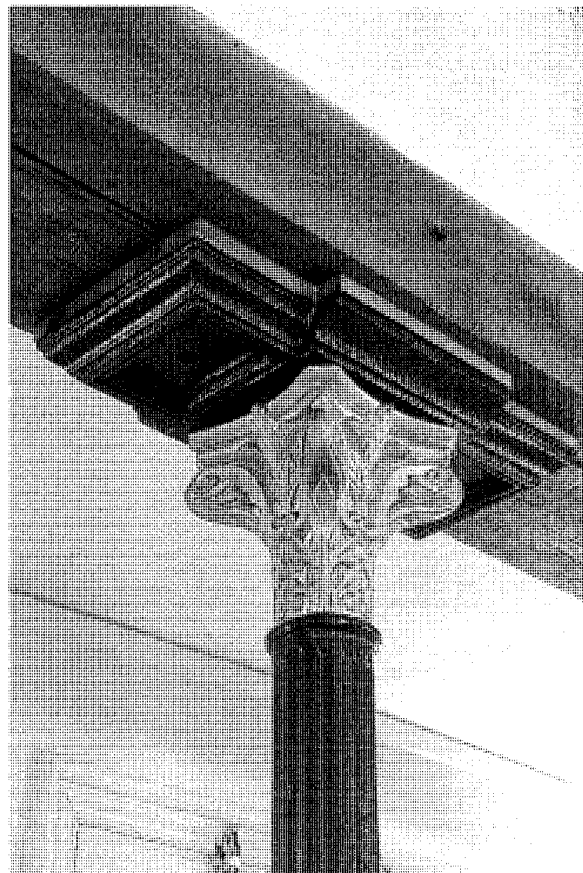
Detalle de columna.
