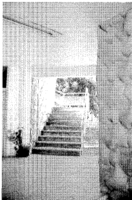
Vestíbulo y escalera exterior.
