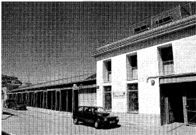
Nueva fachada a la calle Padre Benito Menni.
