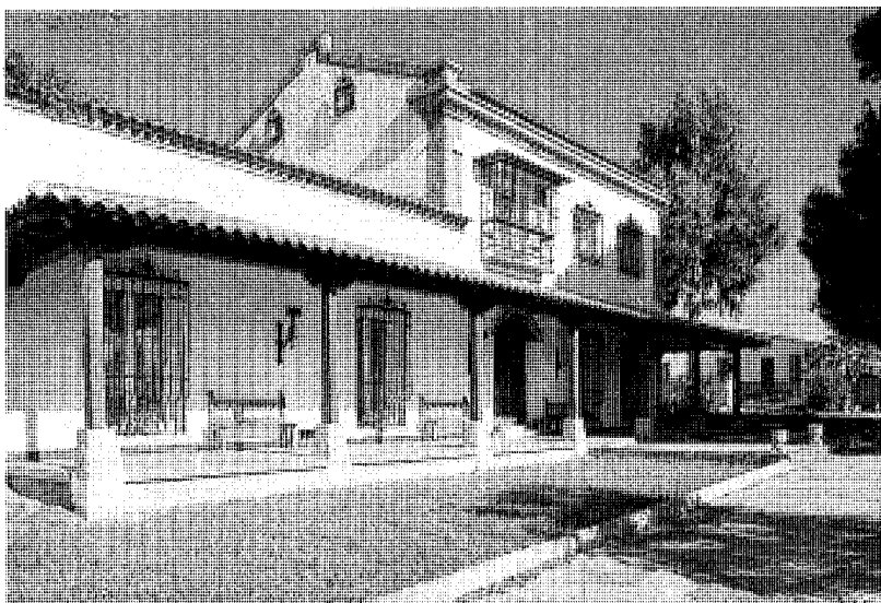
La Torrecilla . Vista general. Foto José Ablanado
