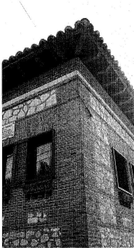
Detalle de fachada y alero. Jose Ablanedo, 2000
