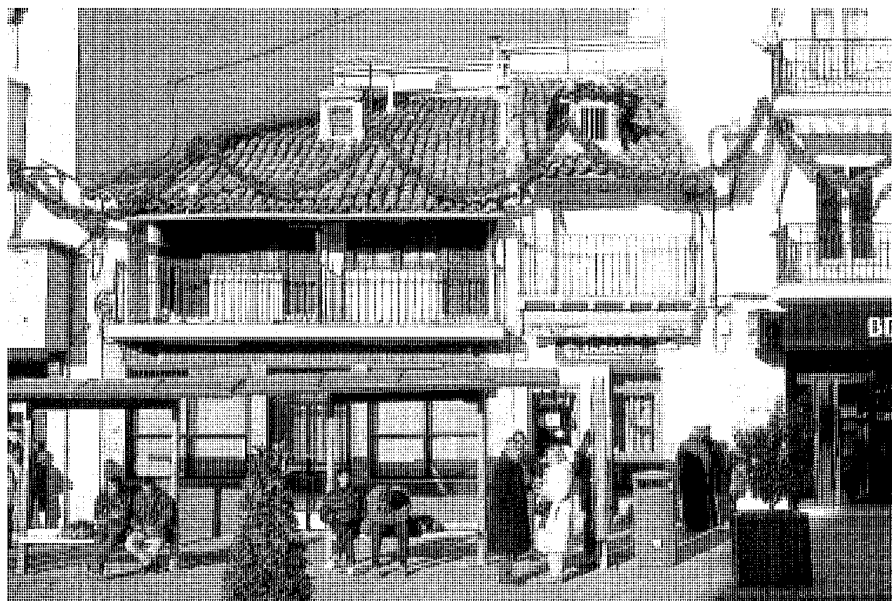
Vivienda en plaza de la Constitución, 4
