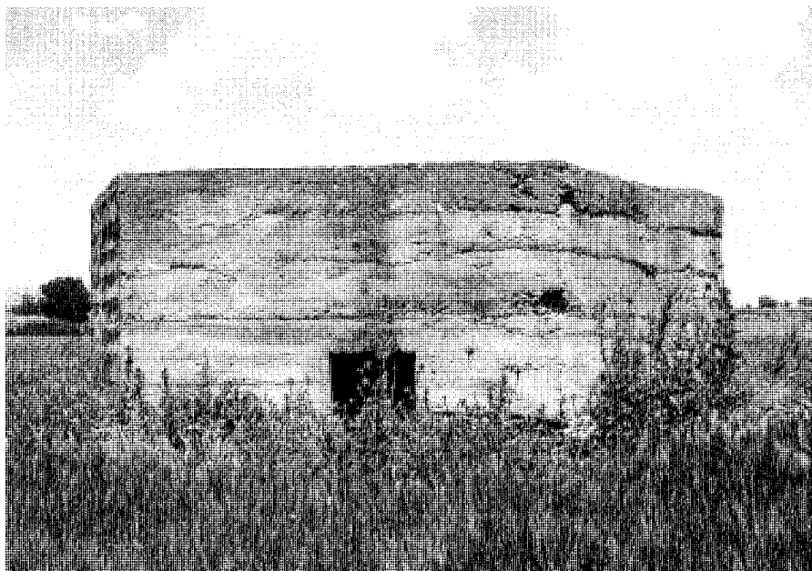
Fortín junto al cordel de las cárceles.
