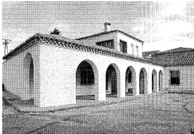
Porche. Fot.: José Ablanedo
