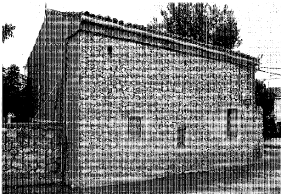
Vivienda en la calle de Cuatro Caminos, 4. Foto Actividades y Servicios Fotográficos, S.A.
