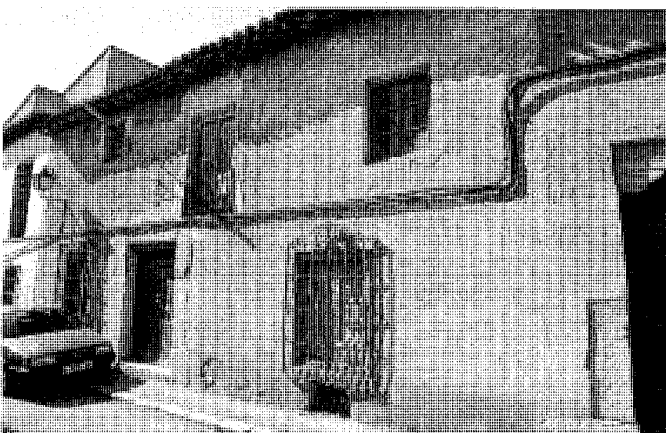
Calle del Arco, 3 y 5
