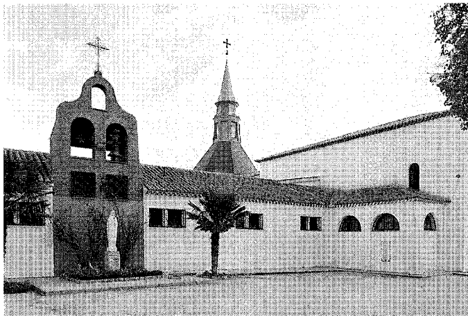
Fachada principal. Fot.: José Ablanedo
