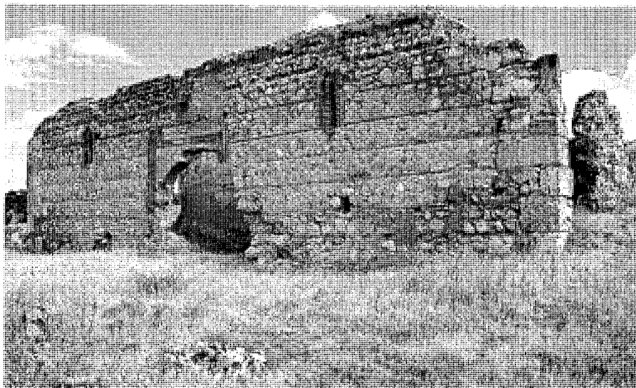
Ermita, restos fachada acceso.
